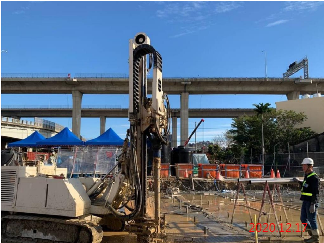
北出土段_地質改良鑽孔埋管作業
