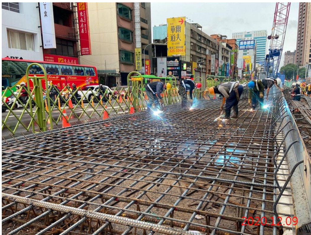
G10 站_連續壁單元鋼筋籠綁紮組立
