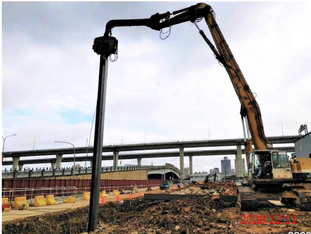
北出土段_臨時擋土型鋼支撐打設
