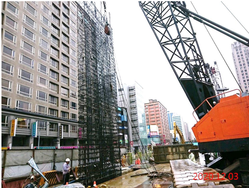
G11 站_連續壁單元鋼筋籠吊放
