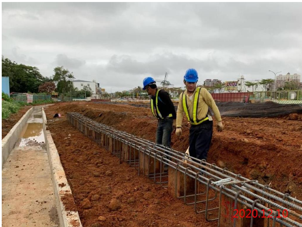
北出土段_擋土型鋼繫梁施作
