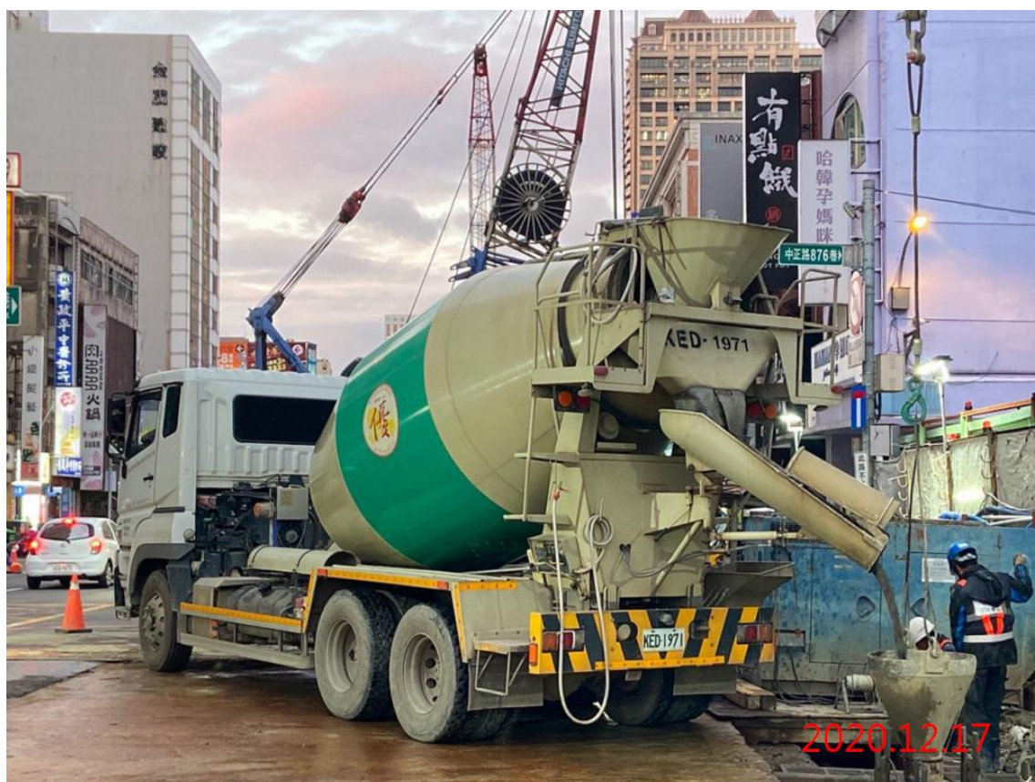
G10 站_連續壁單元混凝土澆置
