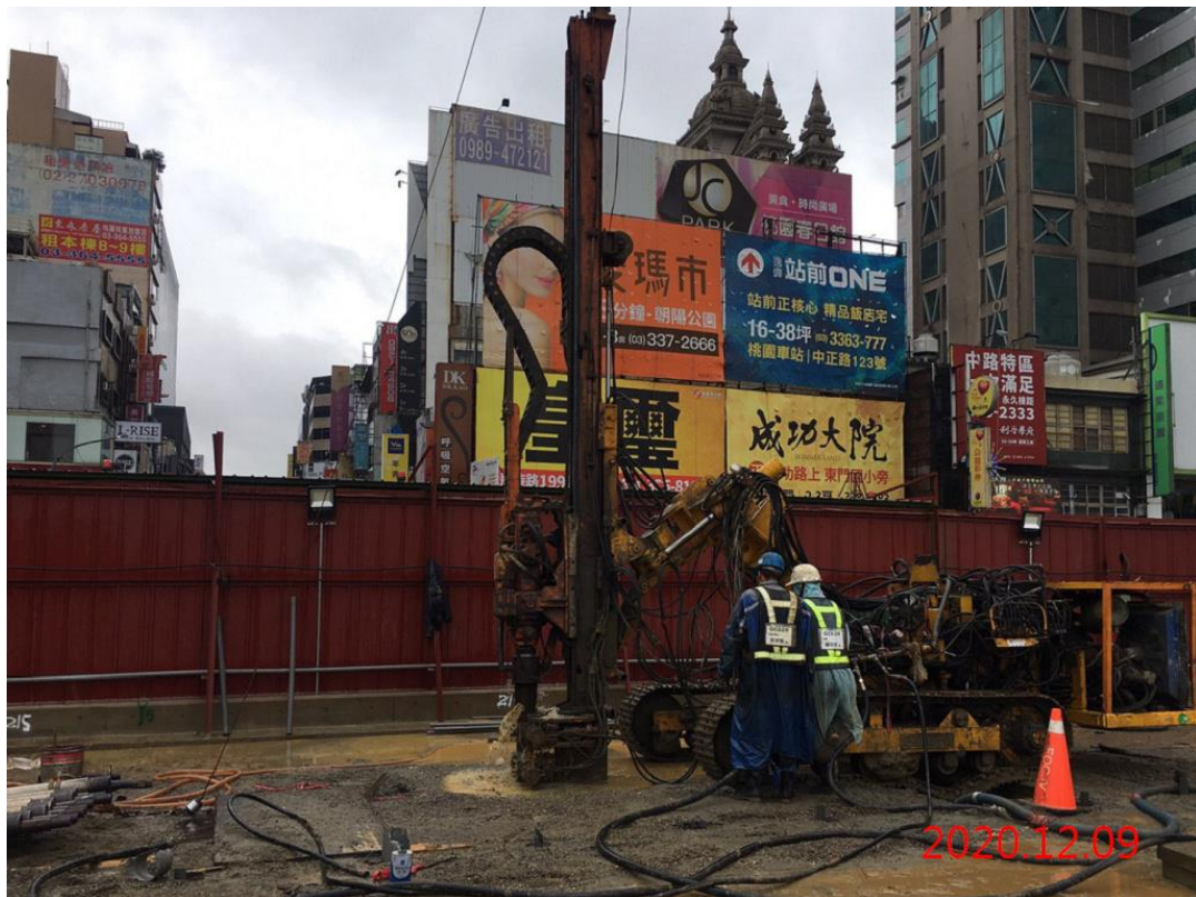
G07 站_槽溝保護(地質改良)鑽孔
