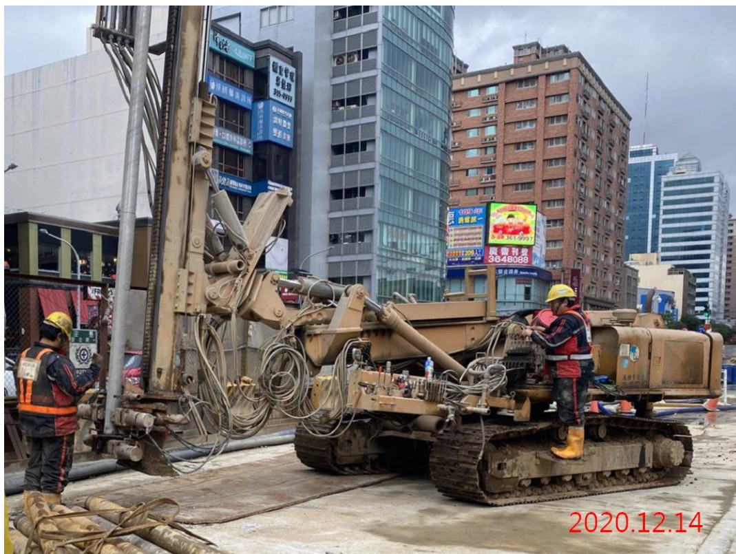
G11 站_壁中傾度管鑽孔(監測儀器安裝)
