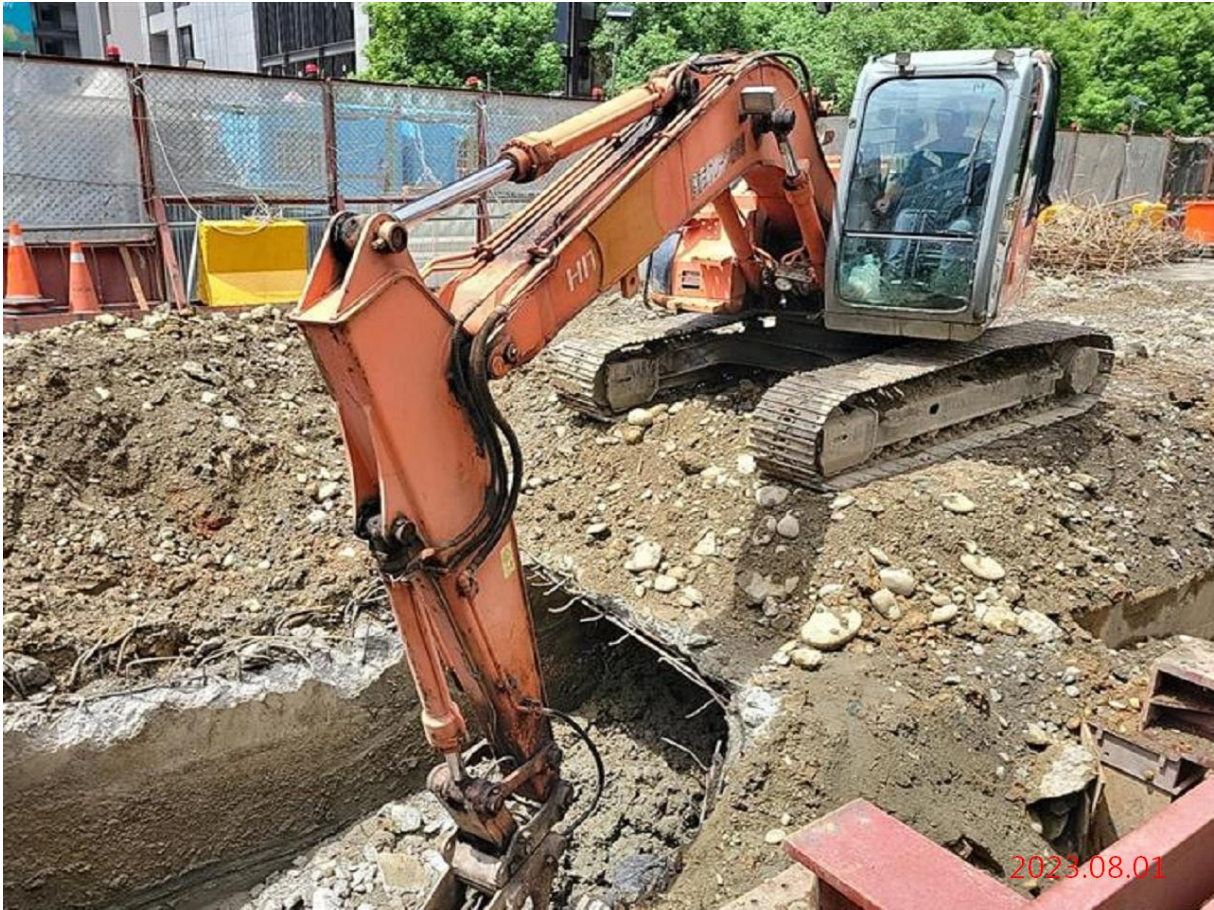
G10 站_出入口淺挖
