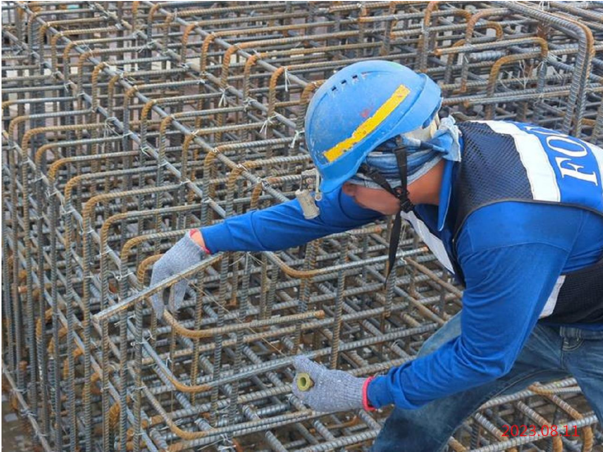
G12 站_通風井 1F 版鋼筋綁紮
