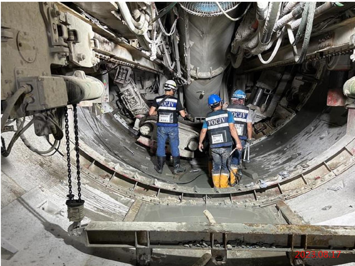
潛盾隧道_小圓潛盾機掘進(G12-G11)
