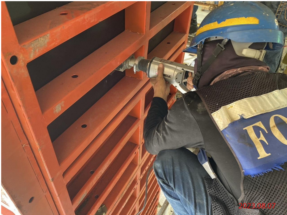
G07 站_站體結構 B1F 北區 SRC 柱澆置
