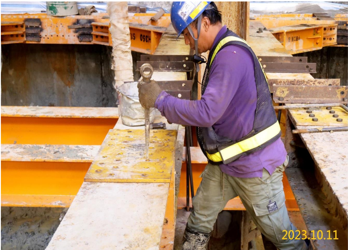
G03 站支撐系統施作
