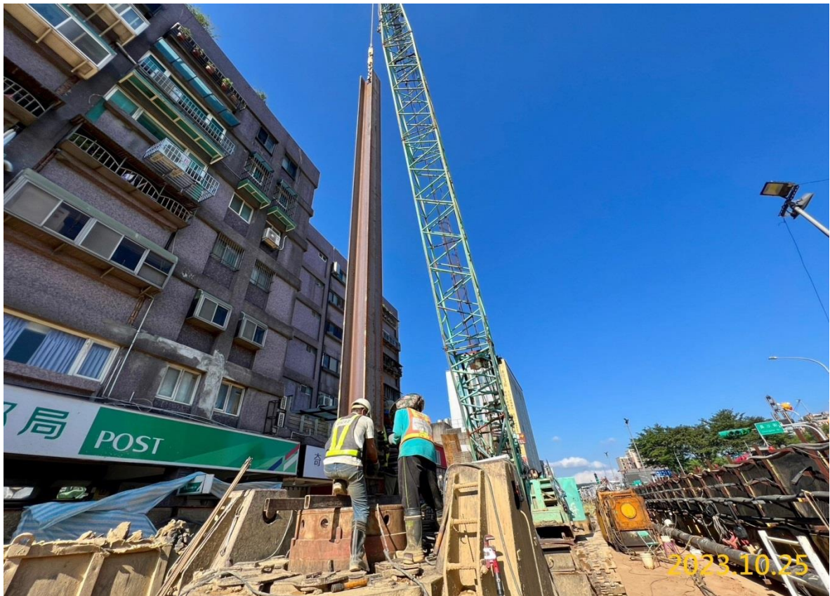
G06 站中間柱施作
