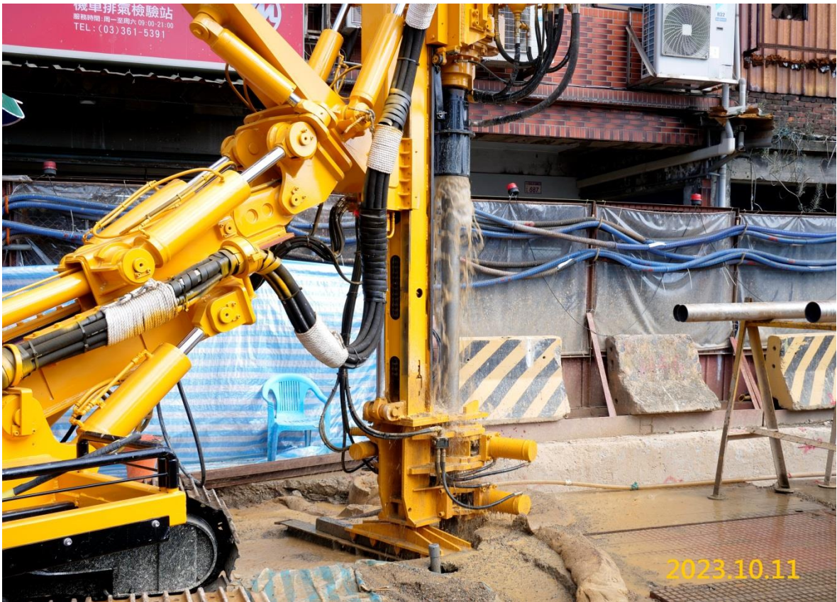
VS4 通風豎井地盤處理施作
