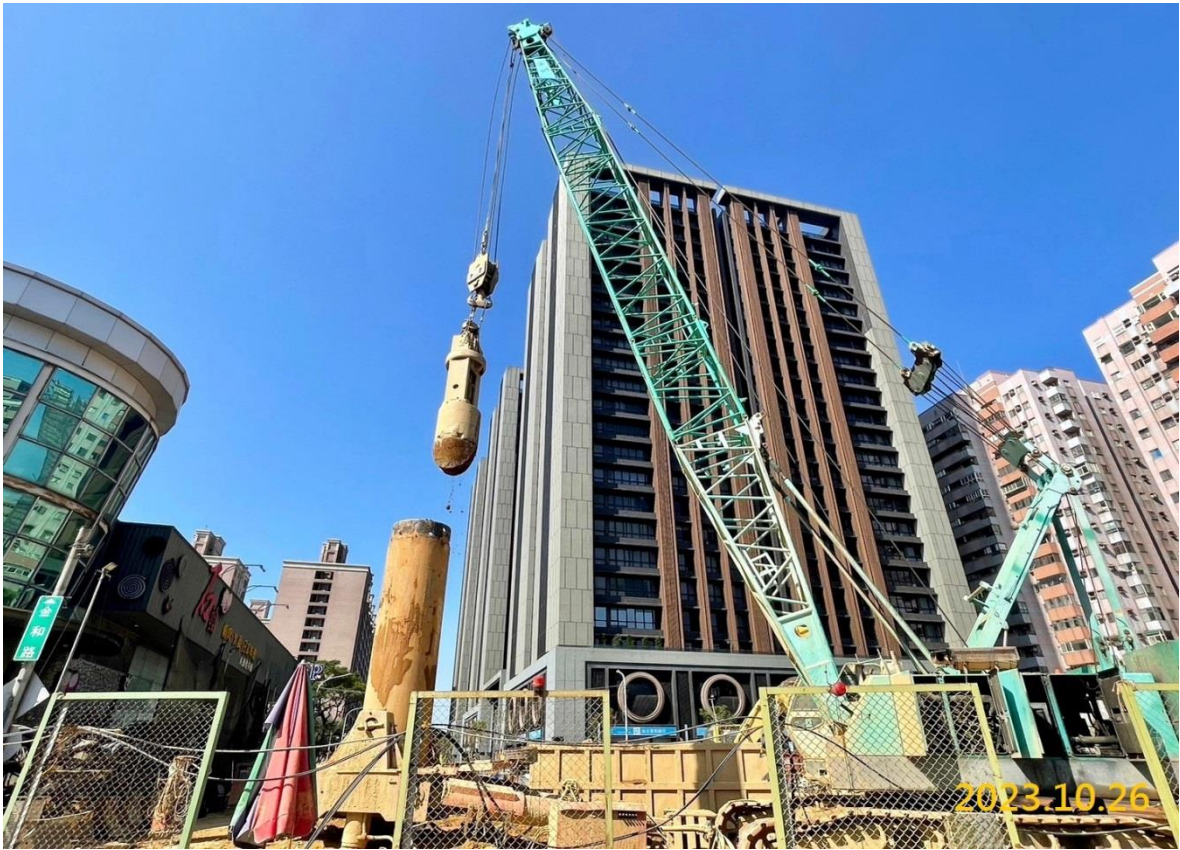
G04 站中間柱施作
