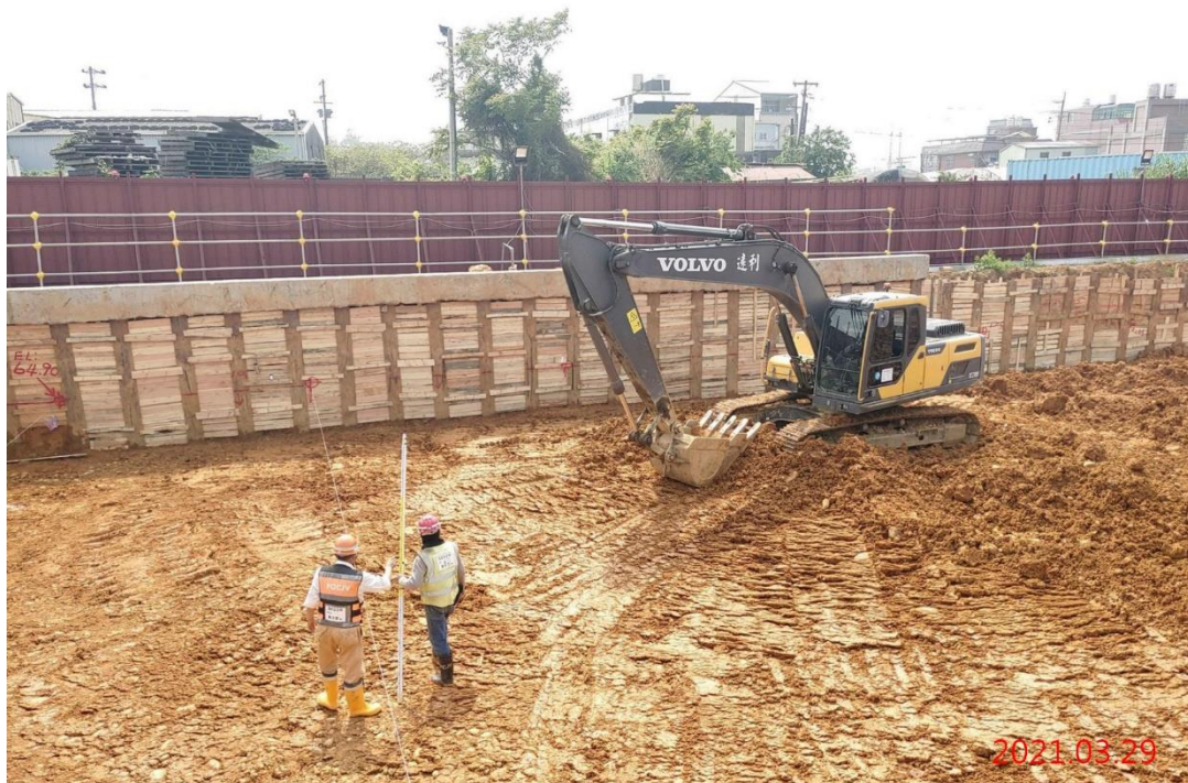
北出土段_土方降挖整地施作
