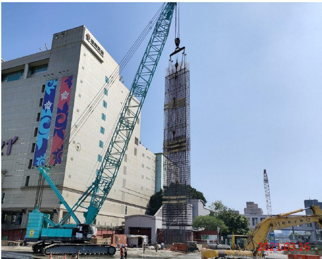
G07 站_連續壁單元鋼筋籠吊放
