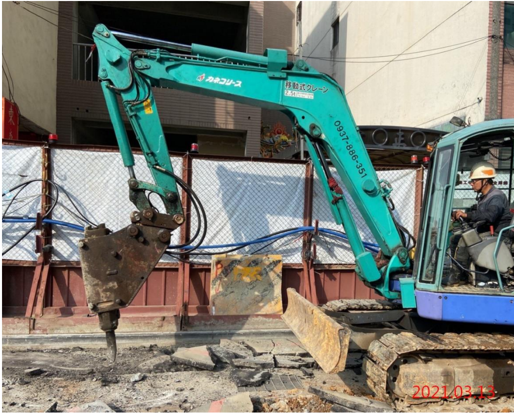
G10 站_西側連續壁管線探挖
