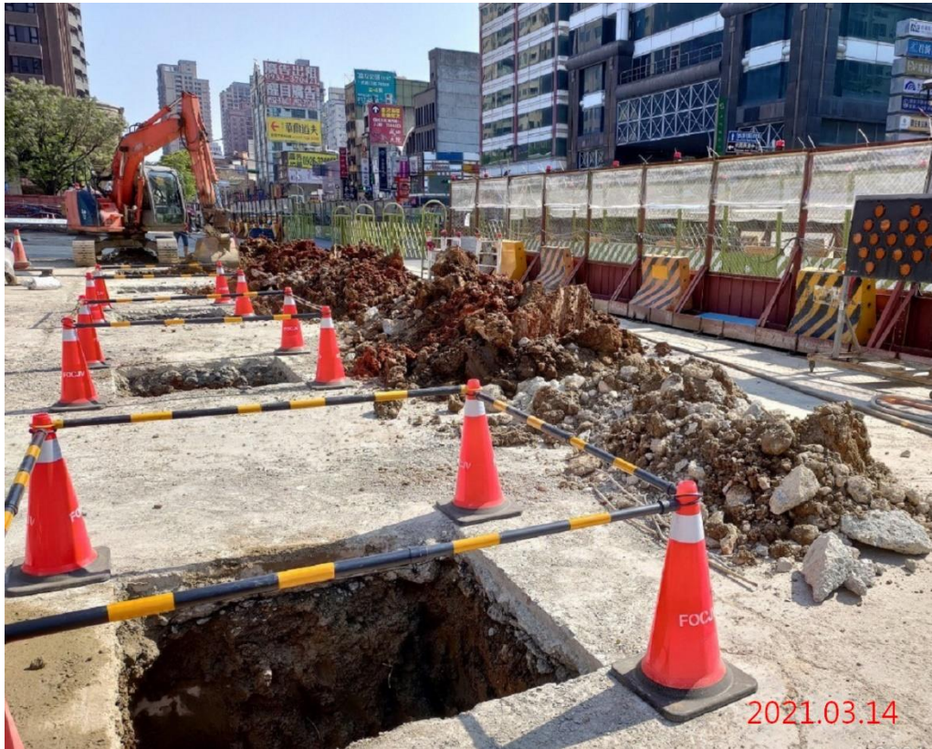
G11 站_中間柱探挖
