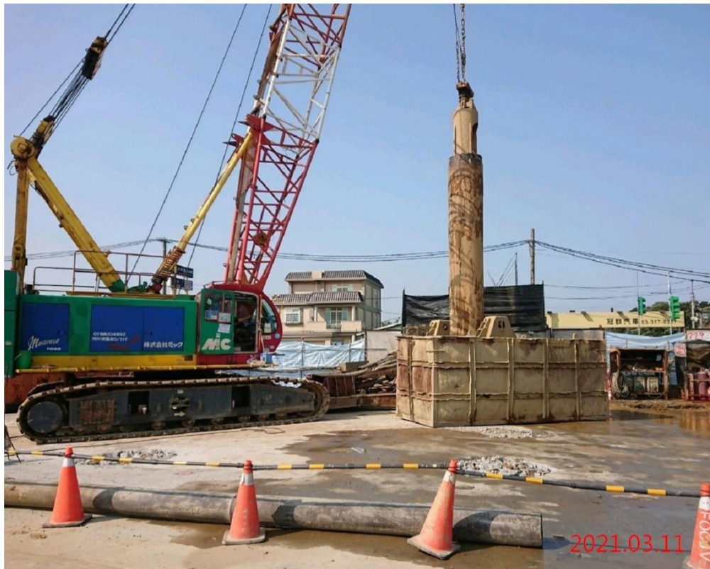
G12 站_中間柱 B2 施作
