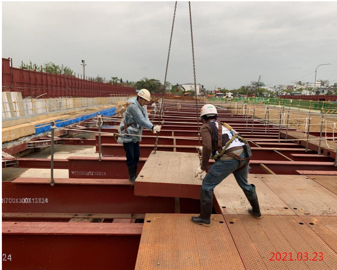
北出土段_覆工鋼鋪設
