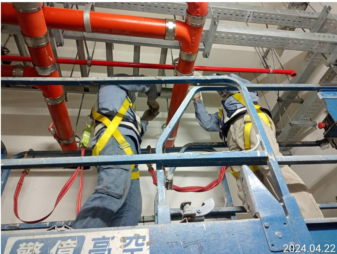
G32 站電氣管路施作
