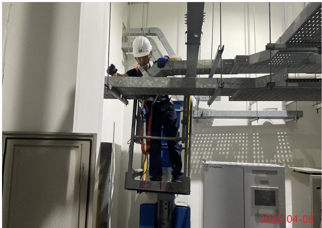
G15 站通訊系統管槽施作
