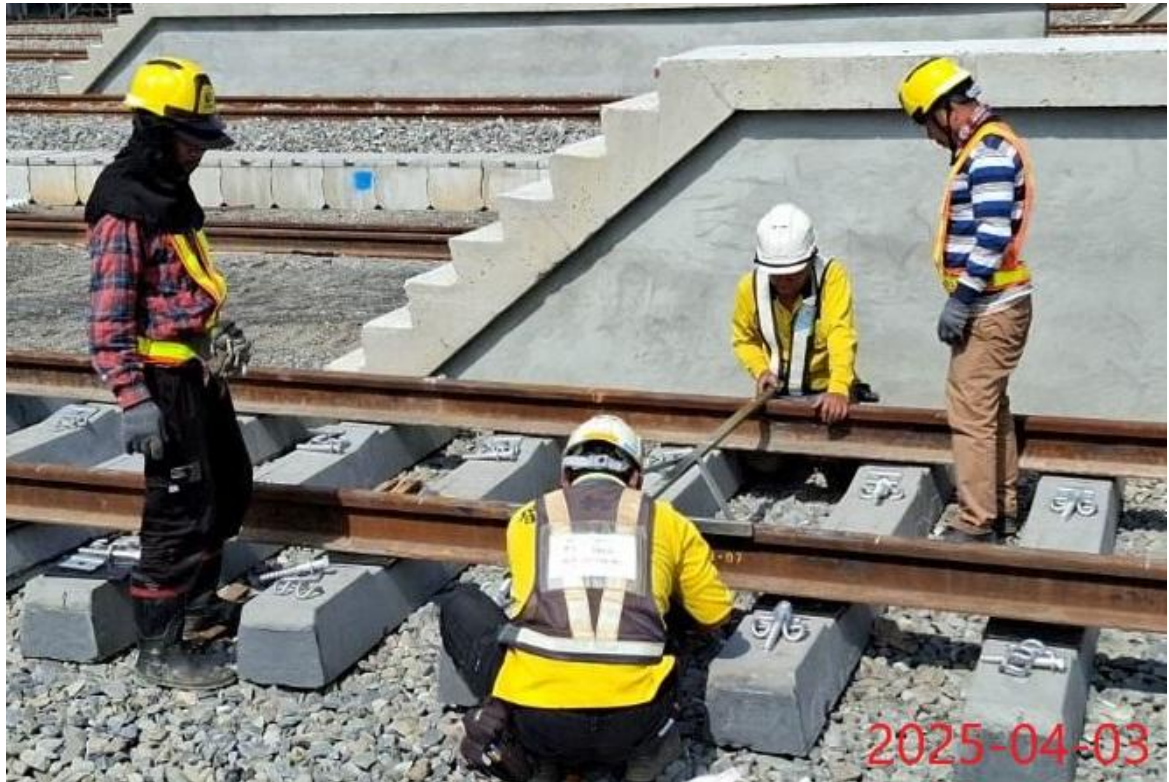
北機廠軌道施工
