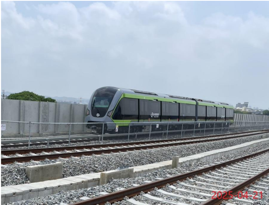
捷運綠線電聯車北機廠測試軌動態測試
