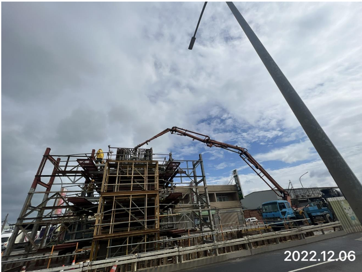
大園三民路二段 墩柱混凝土澆置
