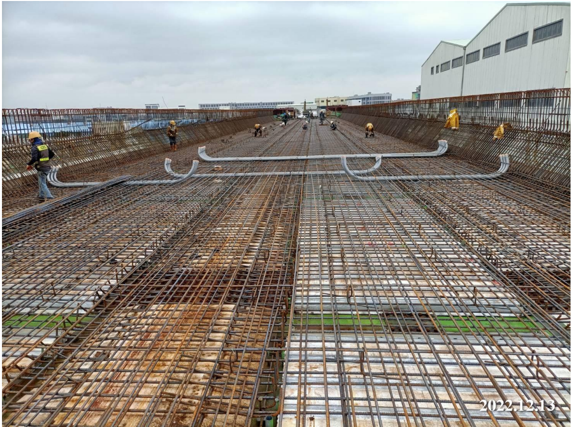
蘆竹中正北路 場鑄箱型梁鋼筋綁紮
