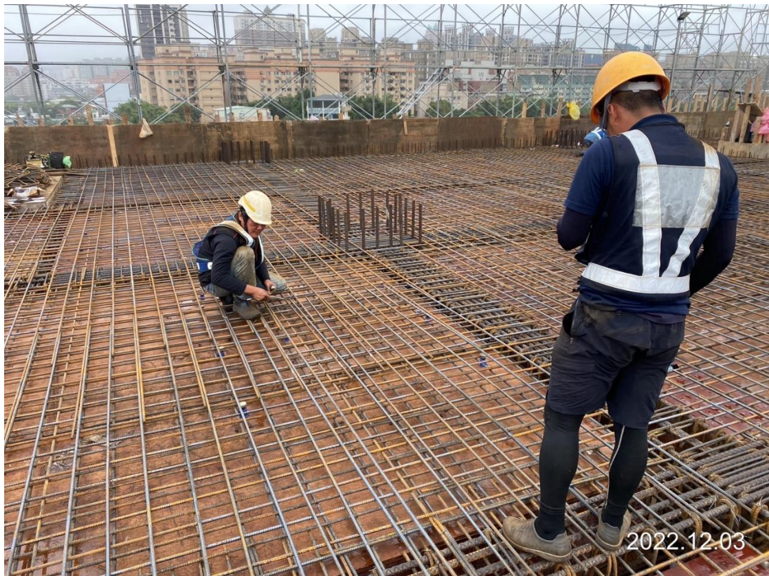
蘆竹中正北路 G13a 車站出入口 2 樓鋼筋綁紮
