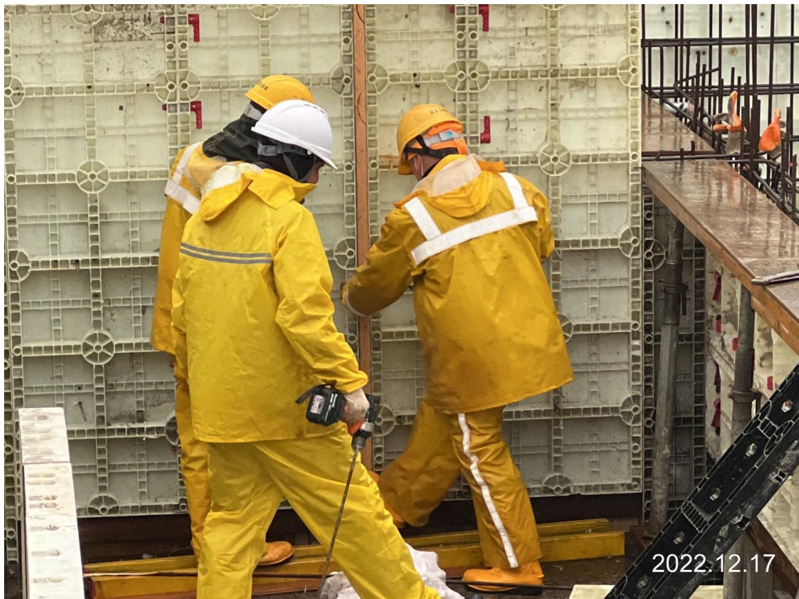
八德新闢道路 G02 車站出入口 3 樓柱牆模板組立
