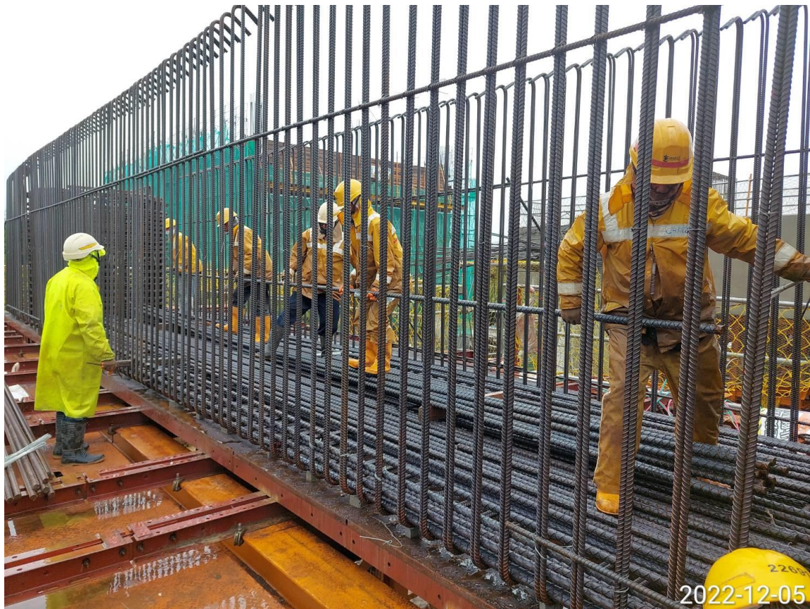
大園三民路段 帽梁鋼筋綁紮
