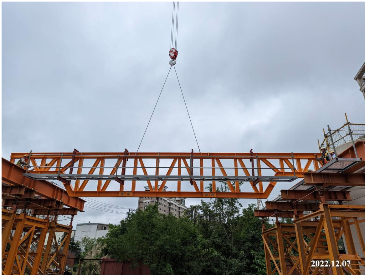
八德新闢道路 場鑄箱型梁支撐架組立
