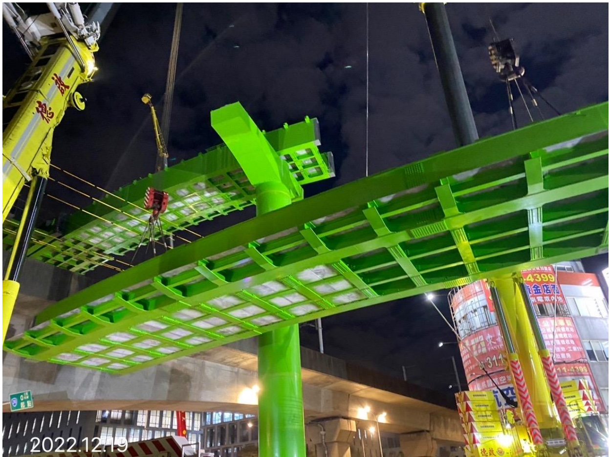
蘆竹南崁路二段 鋼 U 型梁吊裝
