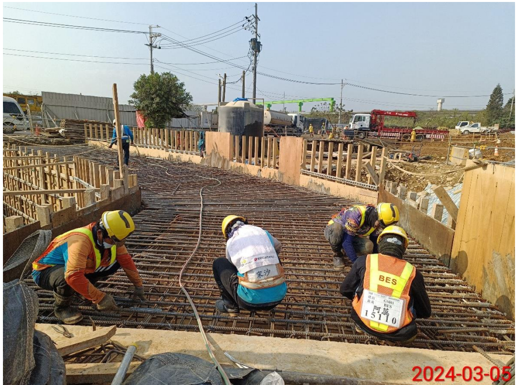
北機廠箱涵施工
