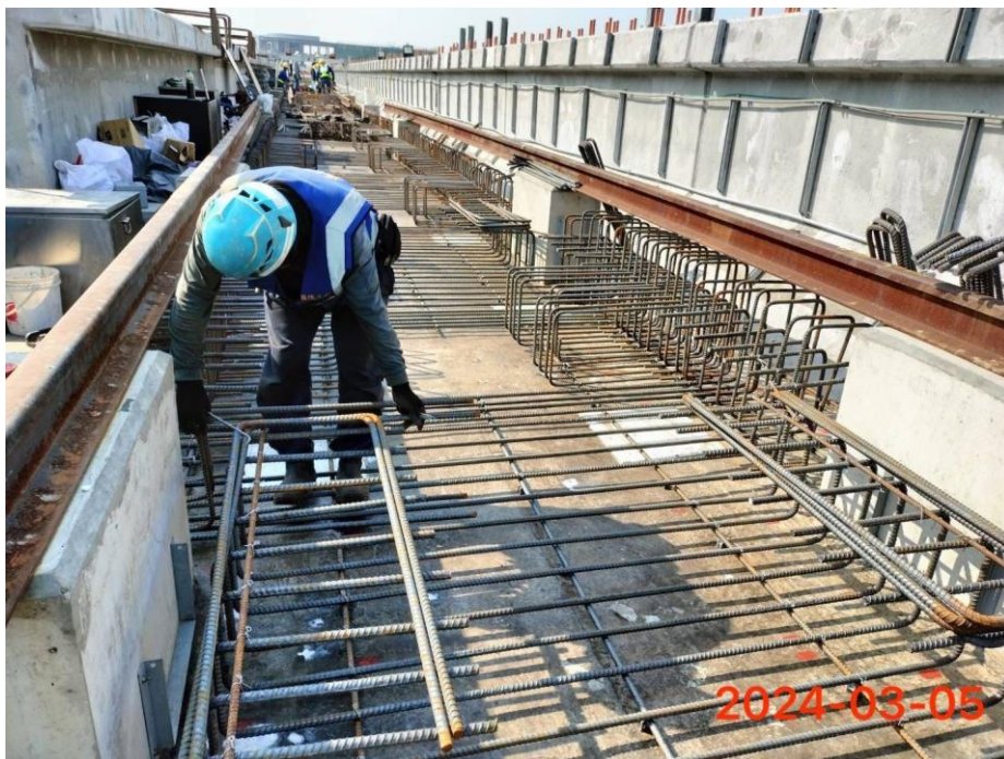
G13A-G14 站間軌道施工
