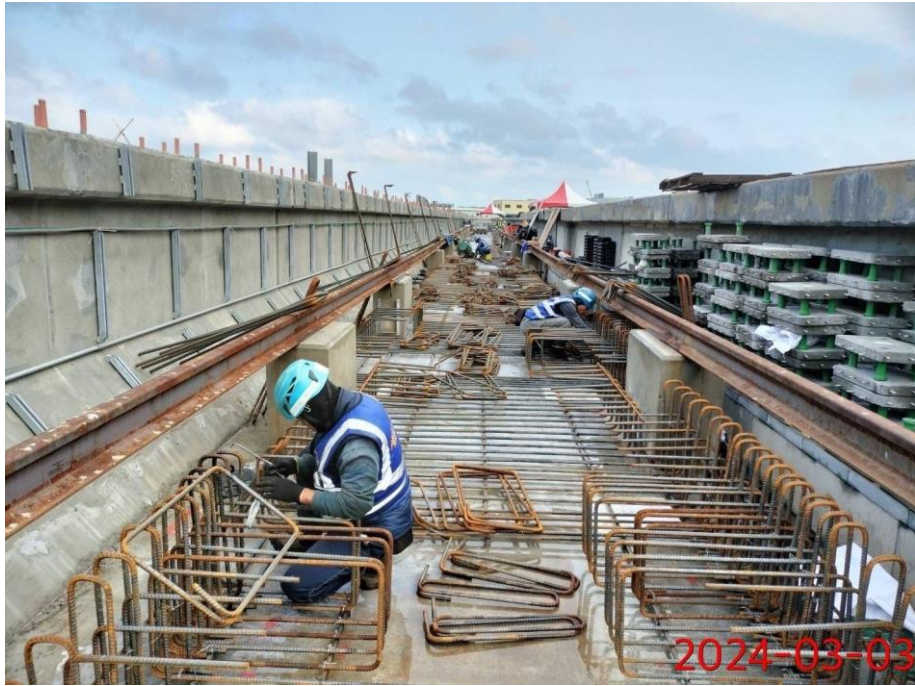
G13A-G14 站間軌道施工
