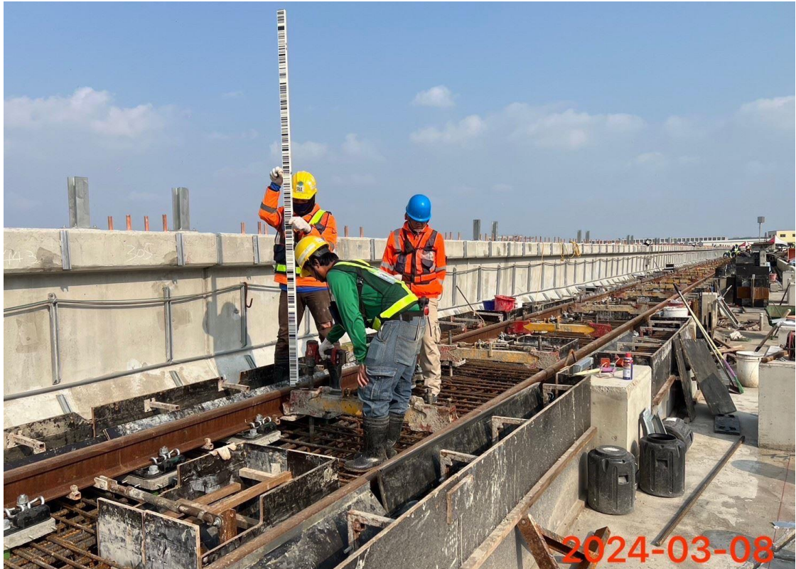
G13A-G14 站間軌道施工
