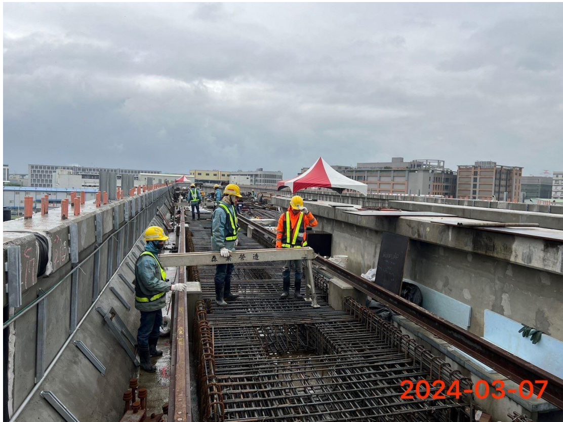
G13A-G14 站間軌道施工
