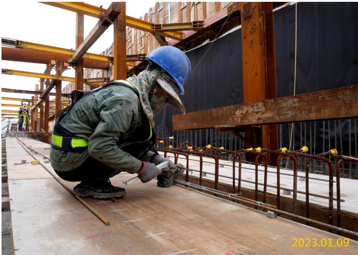
南出土段結構體底版鋼筋綁紮
