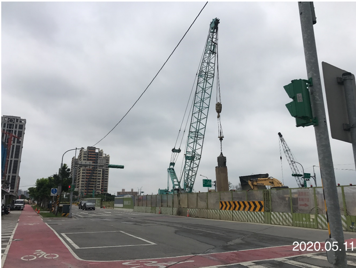
八德建德路 基樁鑽掘
