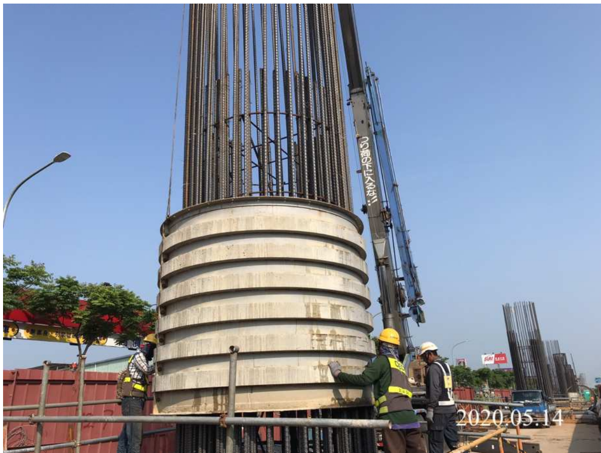
蘆竹中正北路 墩柱第一昇層模板組立
