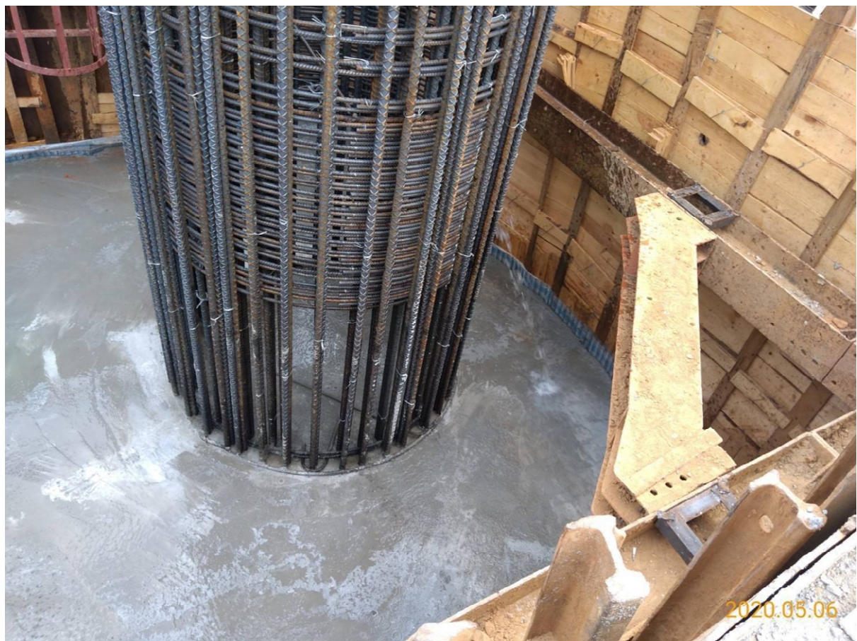
蘆竹中正北路 樁帽混凝土養護
