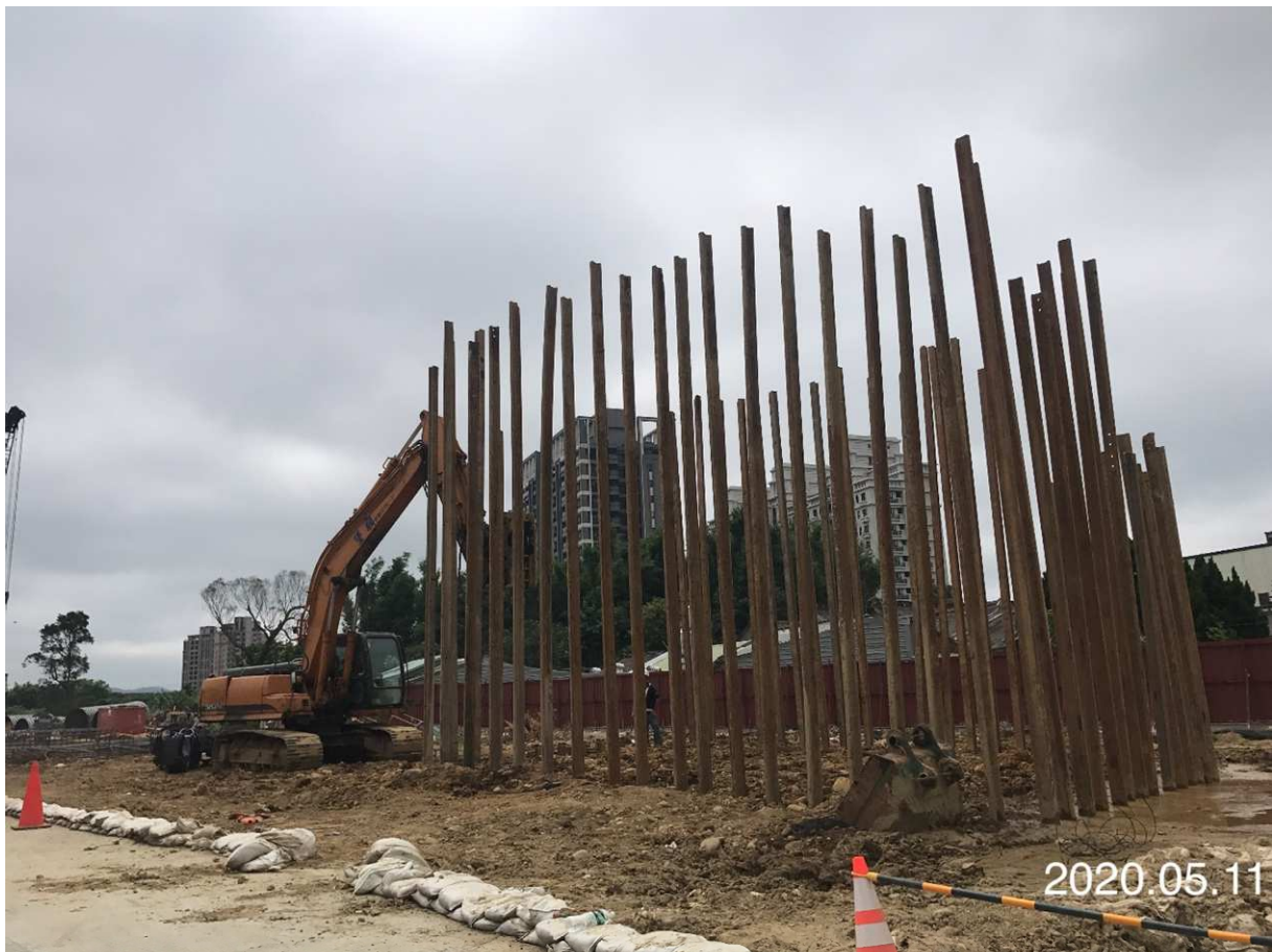
八德新闢道路 樁帽鋼軌樁打設
