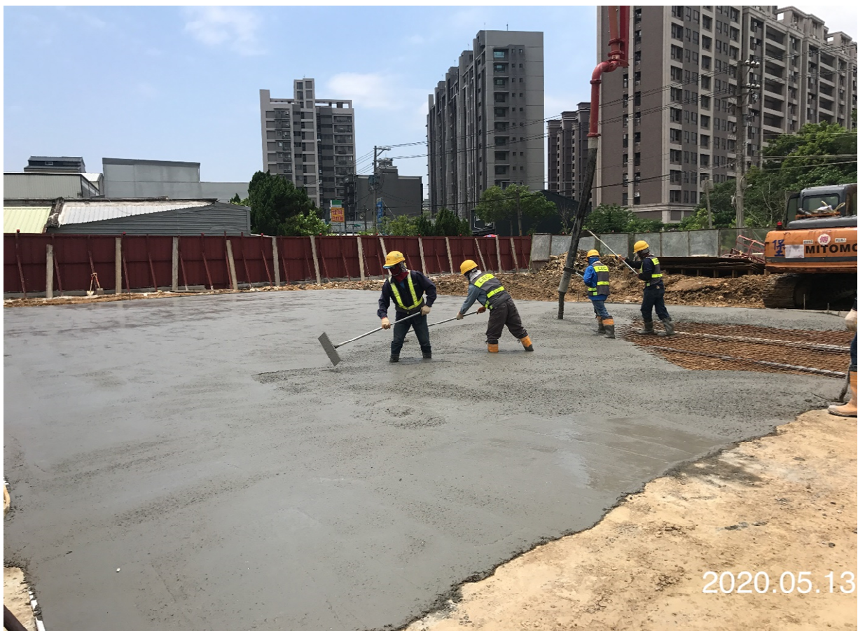
八德新闢道路 施工便道施作
