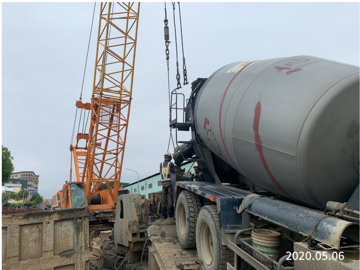
蘆竹南崁路二段 基樁混凝土澆置
