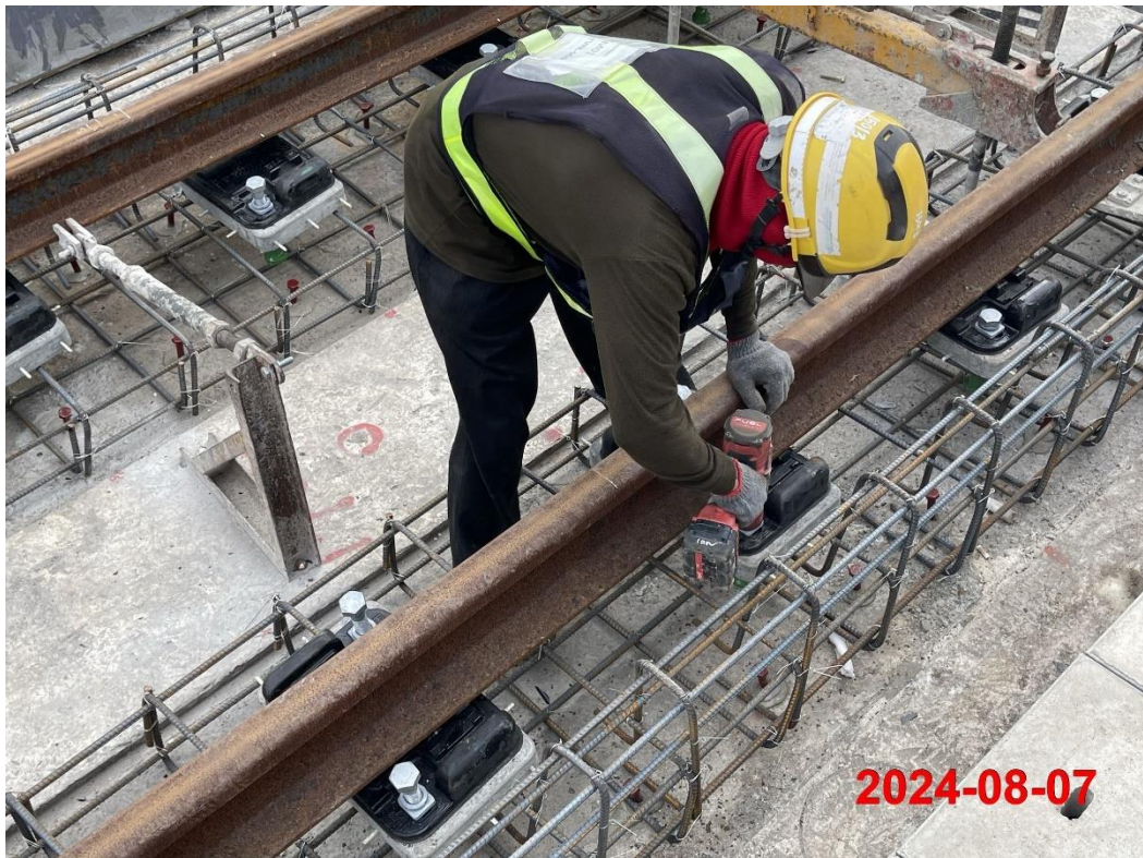
G13a-G14 站間軌道施工
