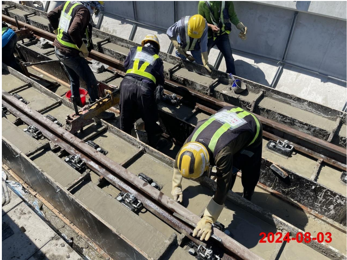
G13a-G14 站間軌道施工
