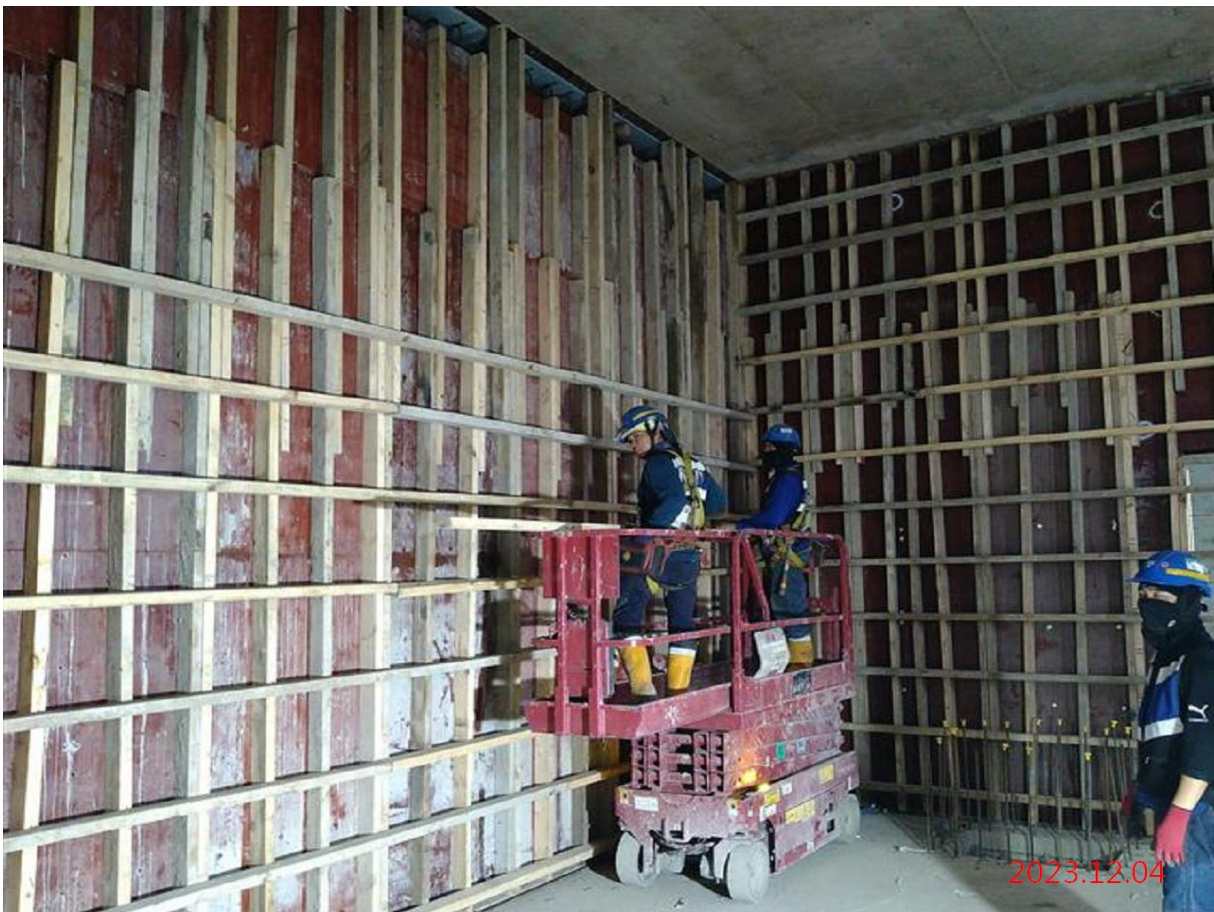
G11_站體穿堂層隔間牆模板施作
