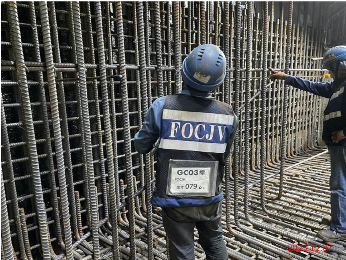
G10_站體底板鋼筋施作
