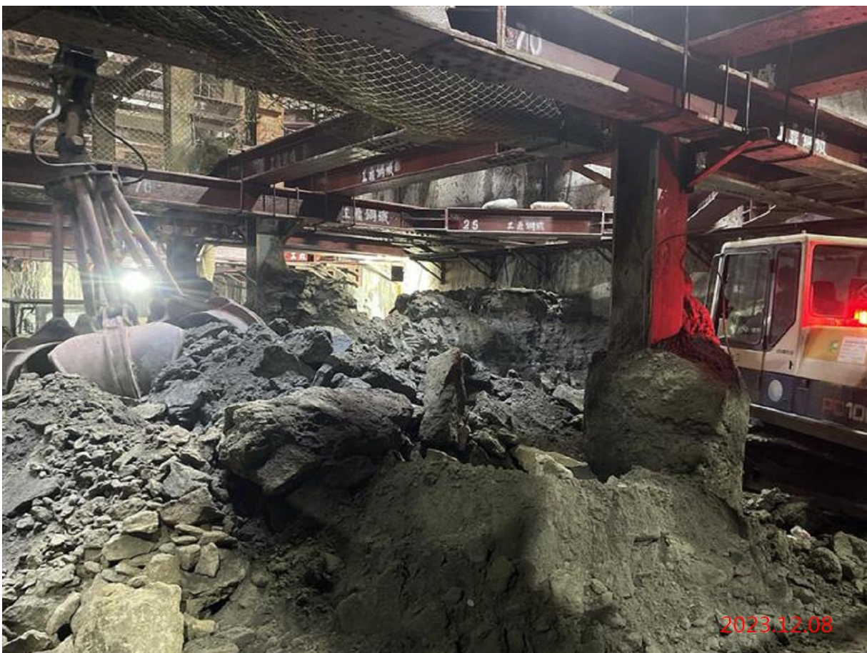
G09_地下站體第八層開挖
