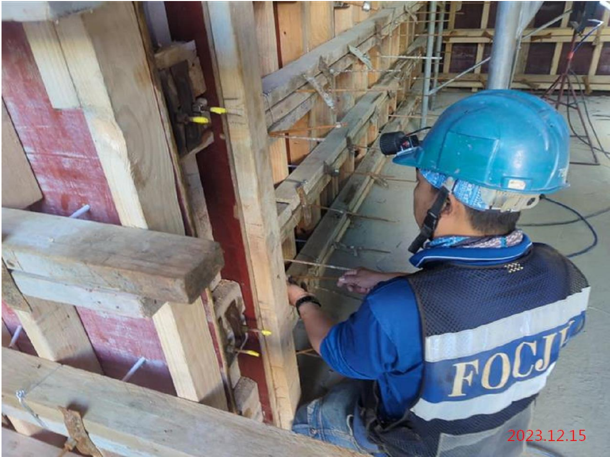
G12_出入口隔間牆模板施作
