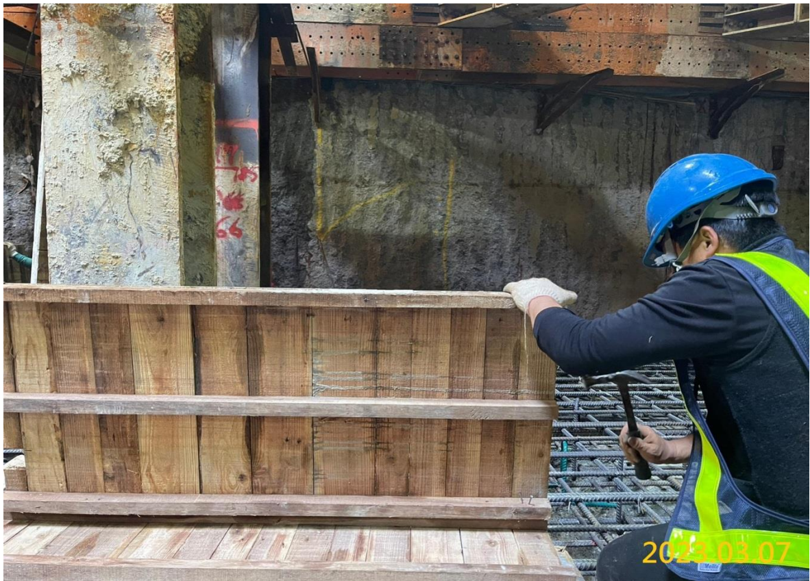
G03 站結構體施作
