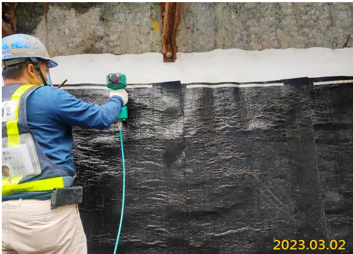
南出土段結構體防水施作
