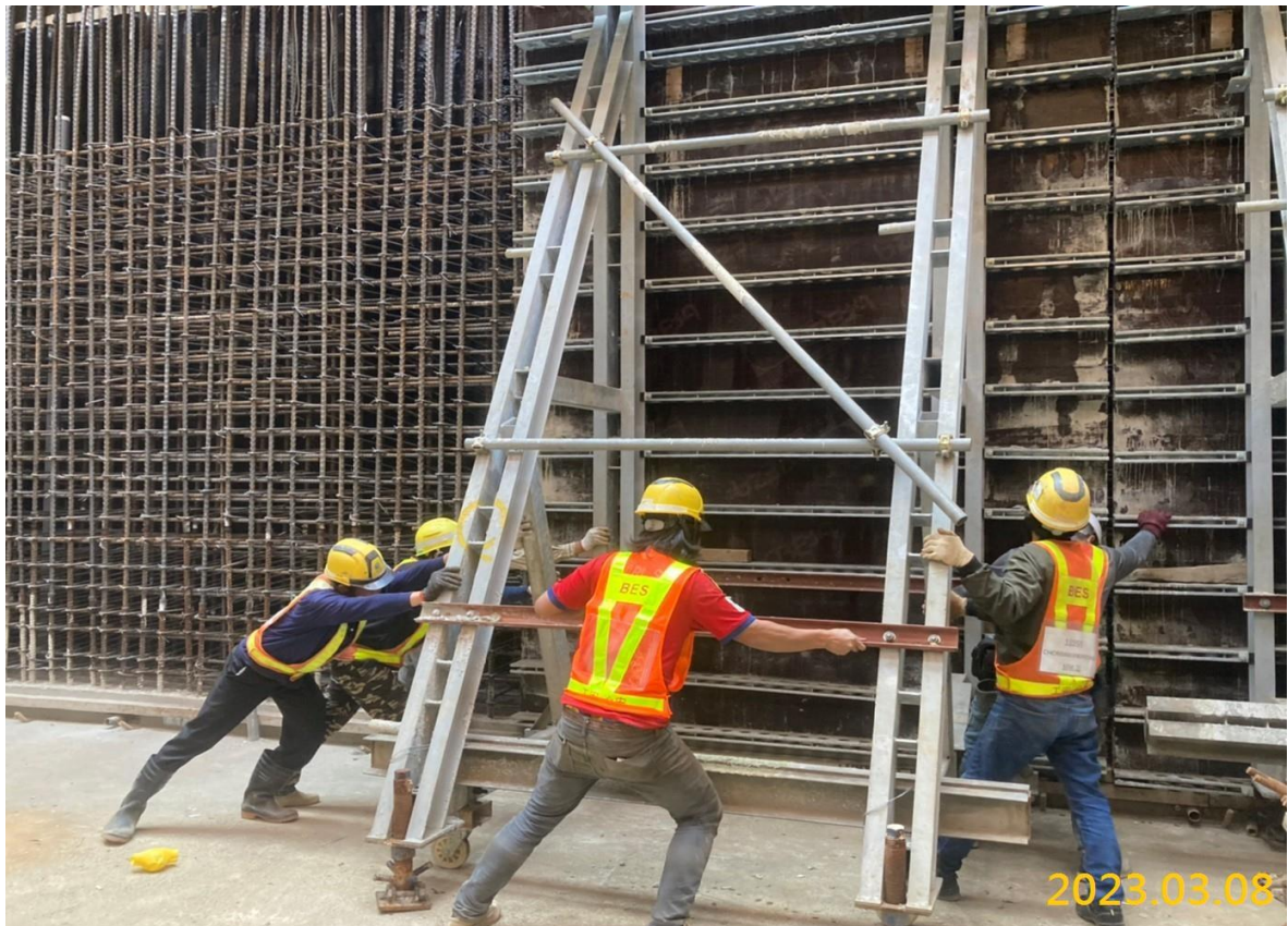
VS6 通風豎井結構體系統模組立
