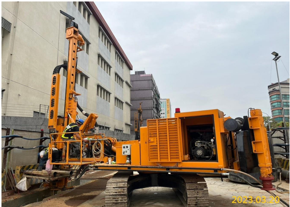
G06 站地盤處理施作
