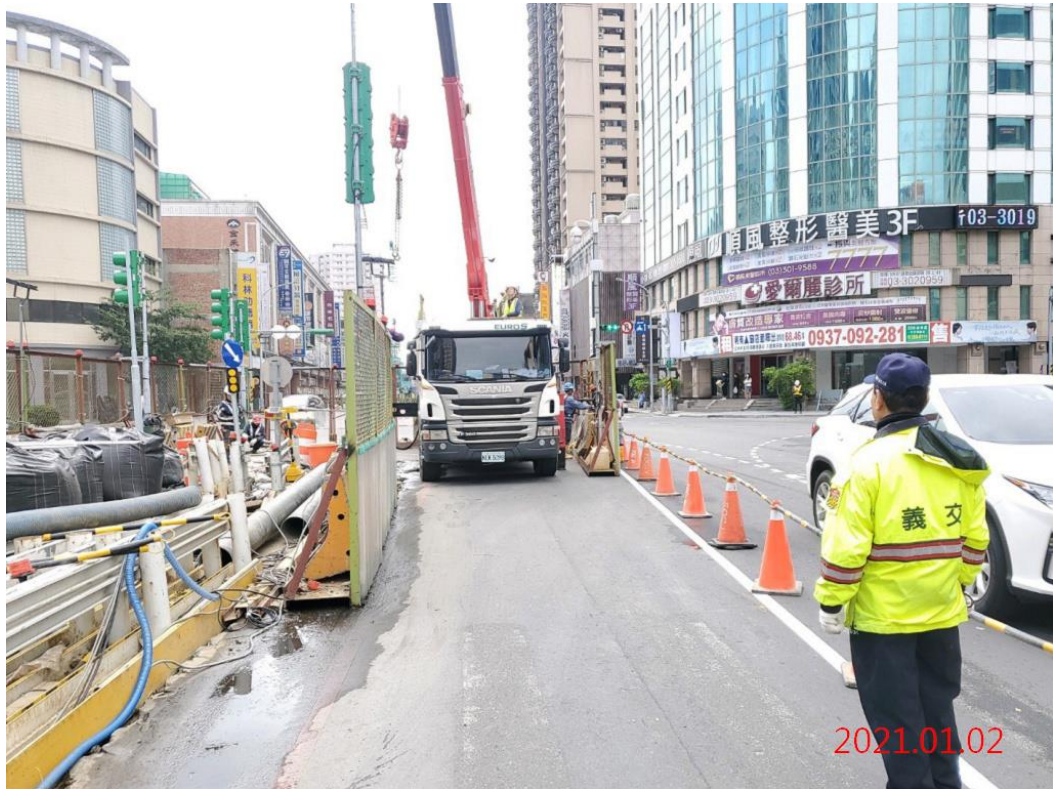
G10 站_圍籬移設
