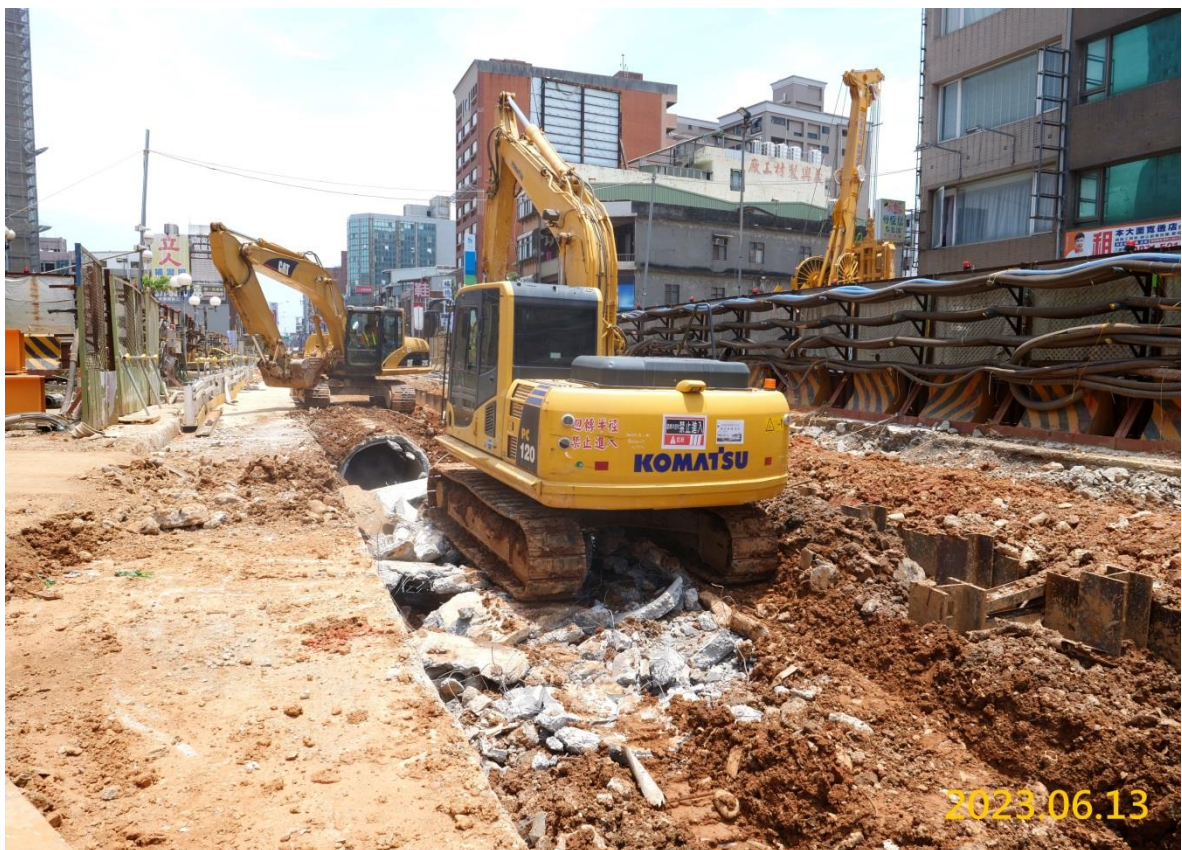
G04 站淺層開挖施作
