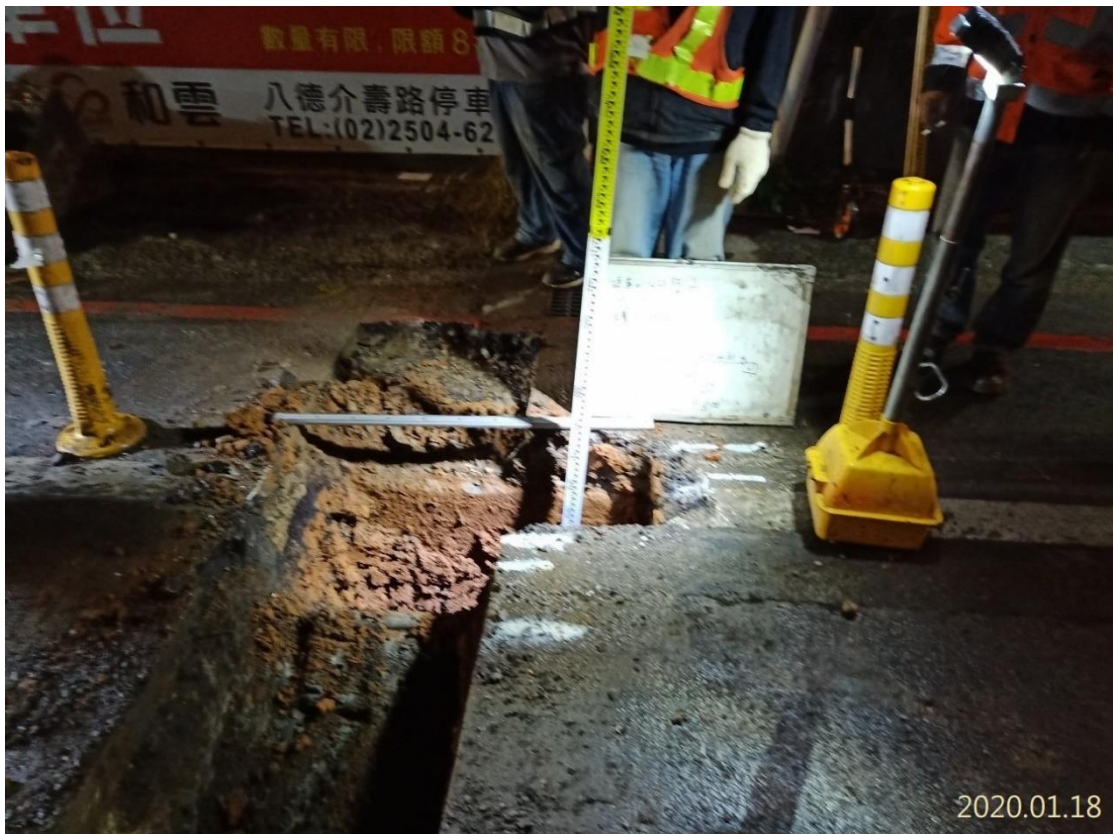
G04 站(八德區介壽路大潤發附近)管線試挖作業(109.01.18)
