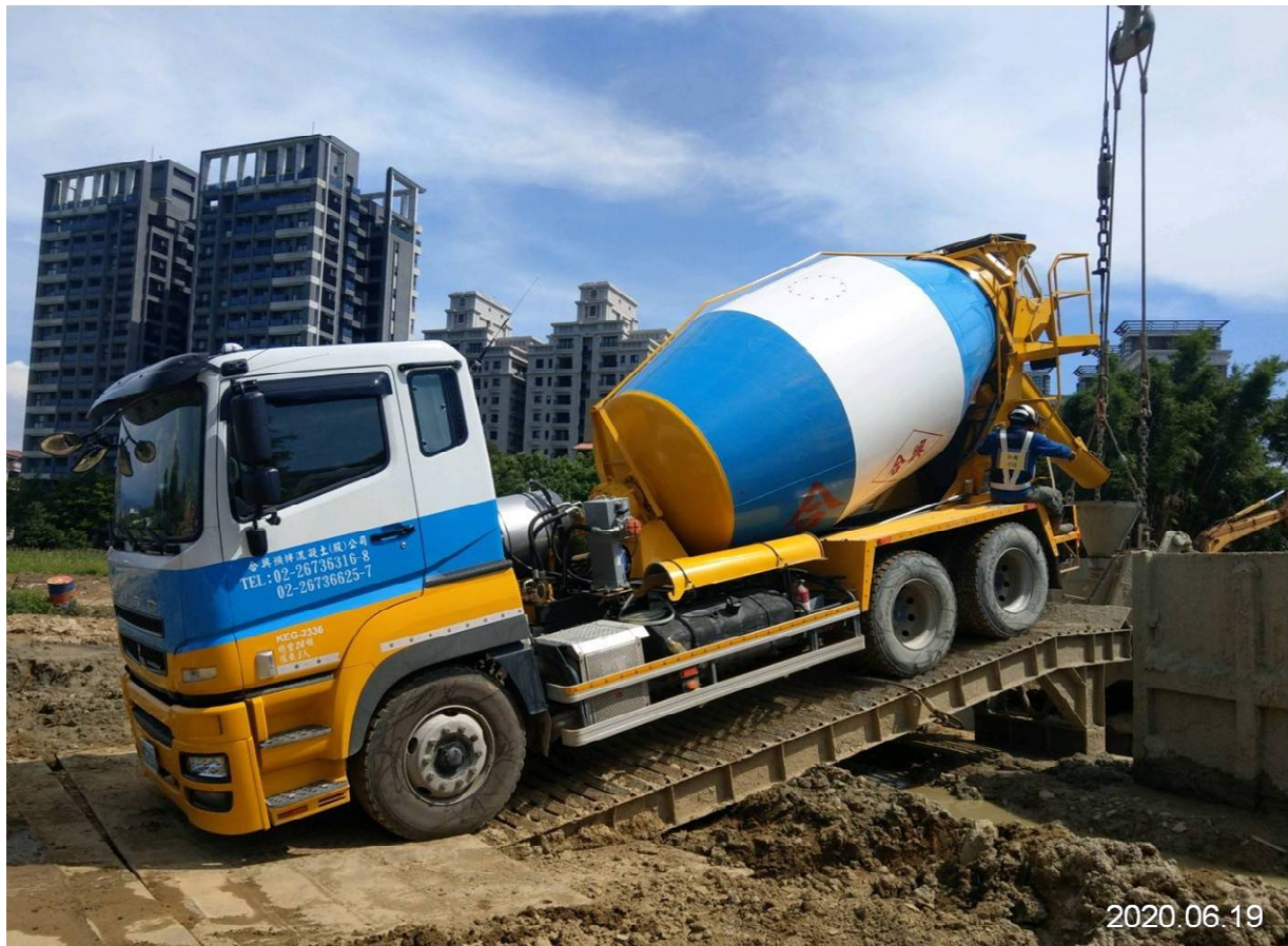
八德新闢道路 基樁混凝土澆置
