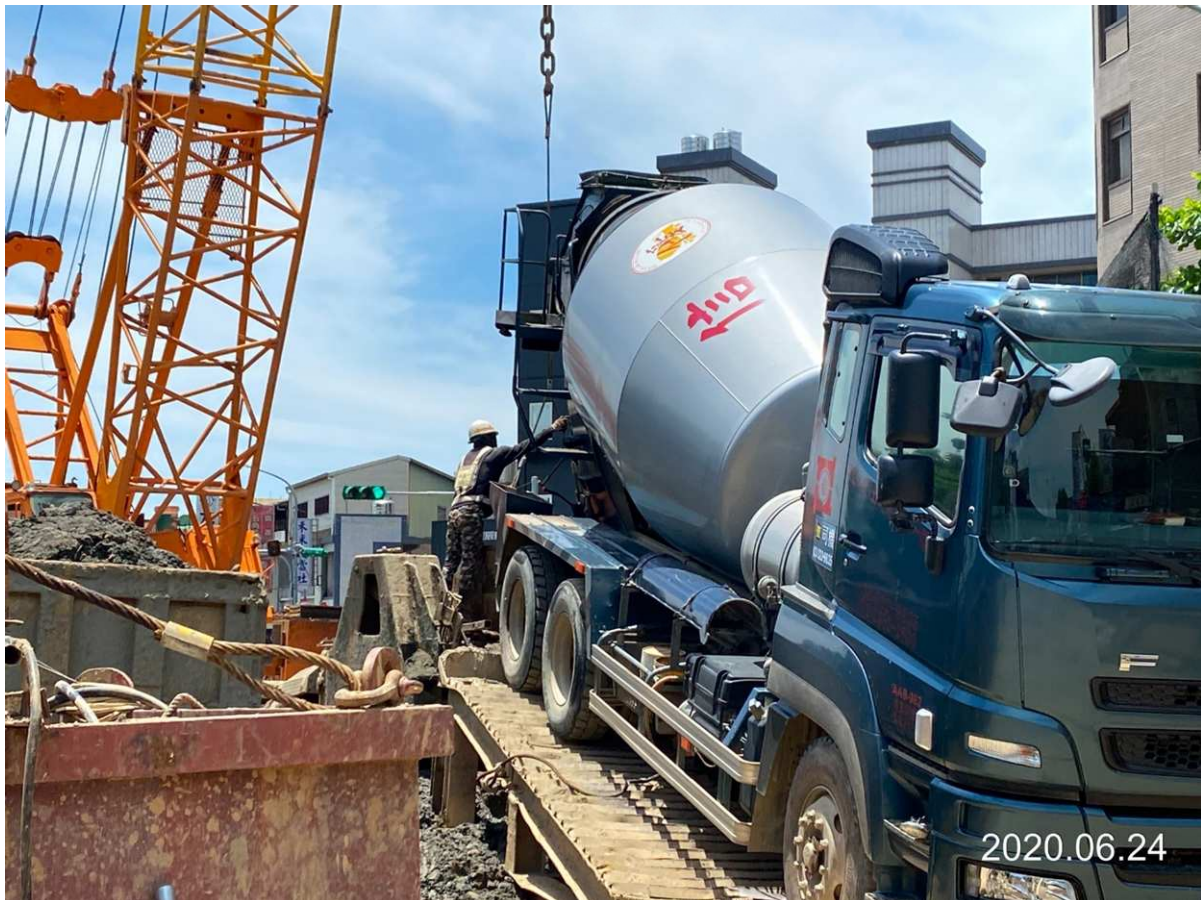
蘆竹南坎路二段 基樁混凝土澆置
