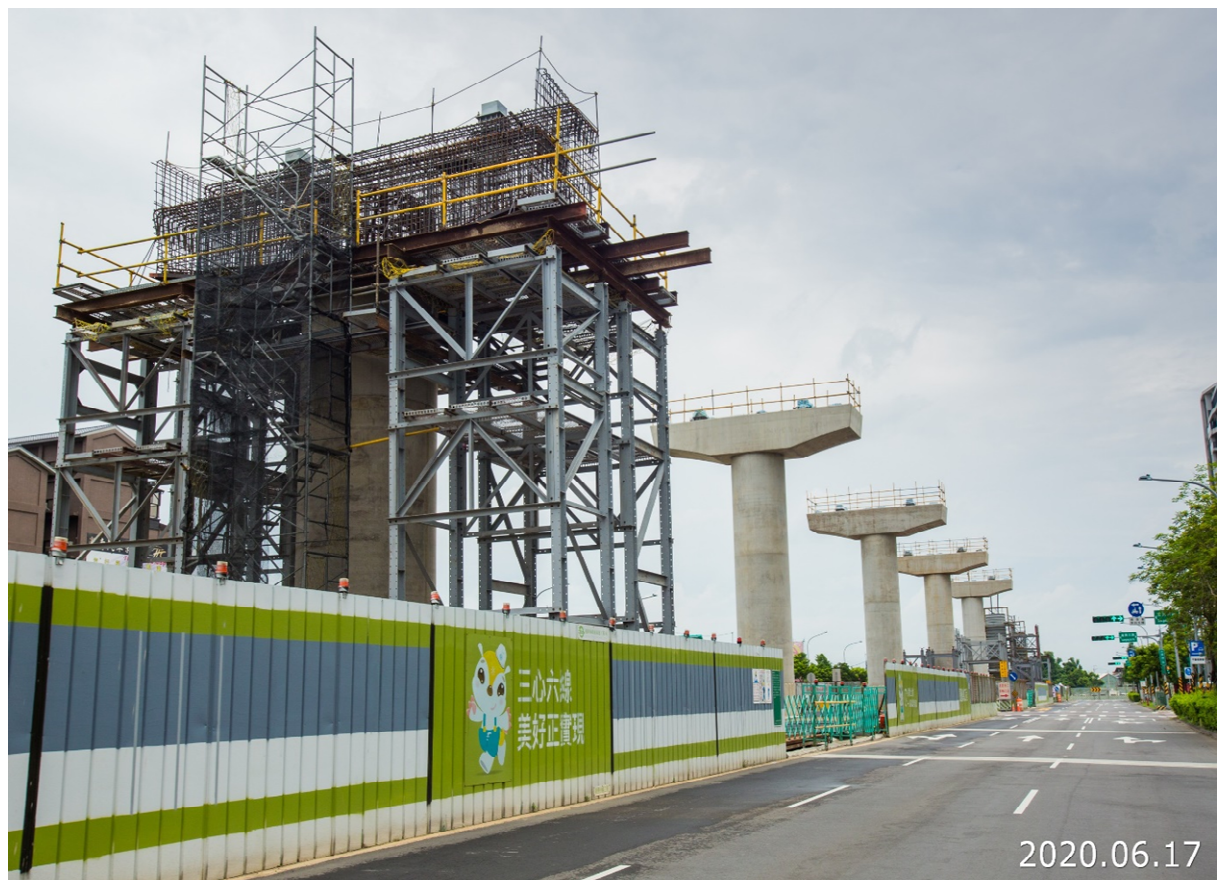
八德建德路 下部結構施工情形
