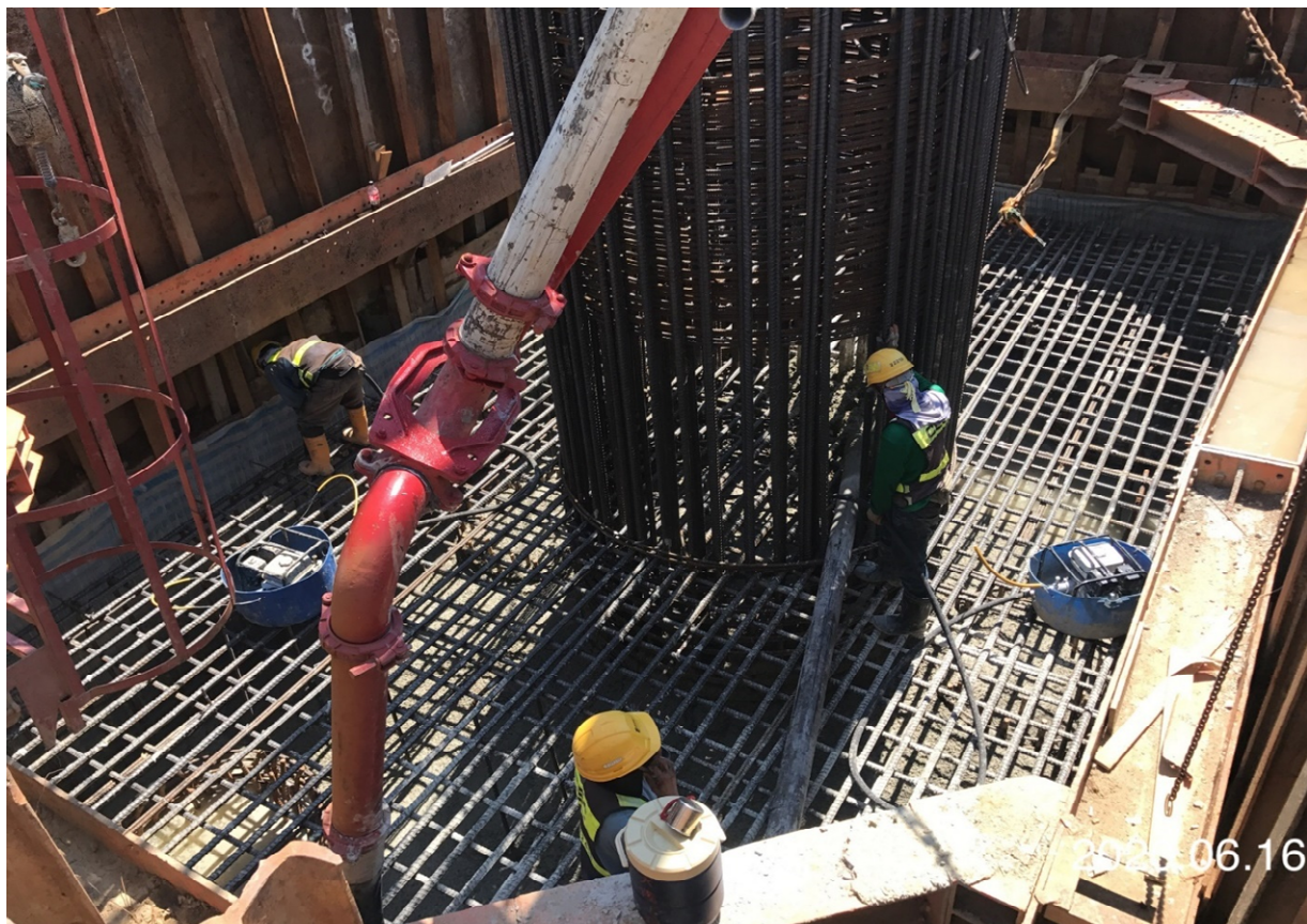
八德新闢道路 樁帽混凝土澆置
