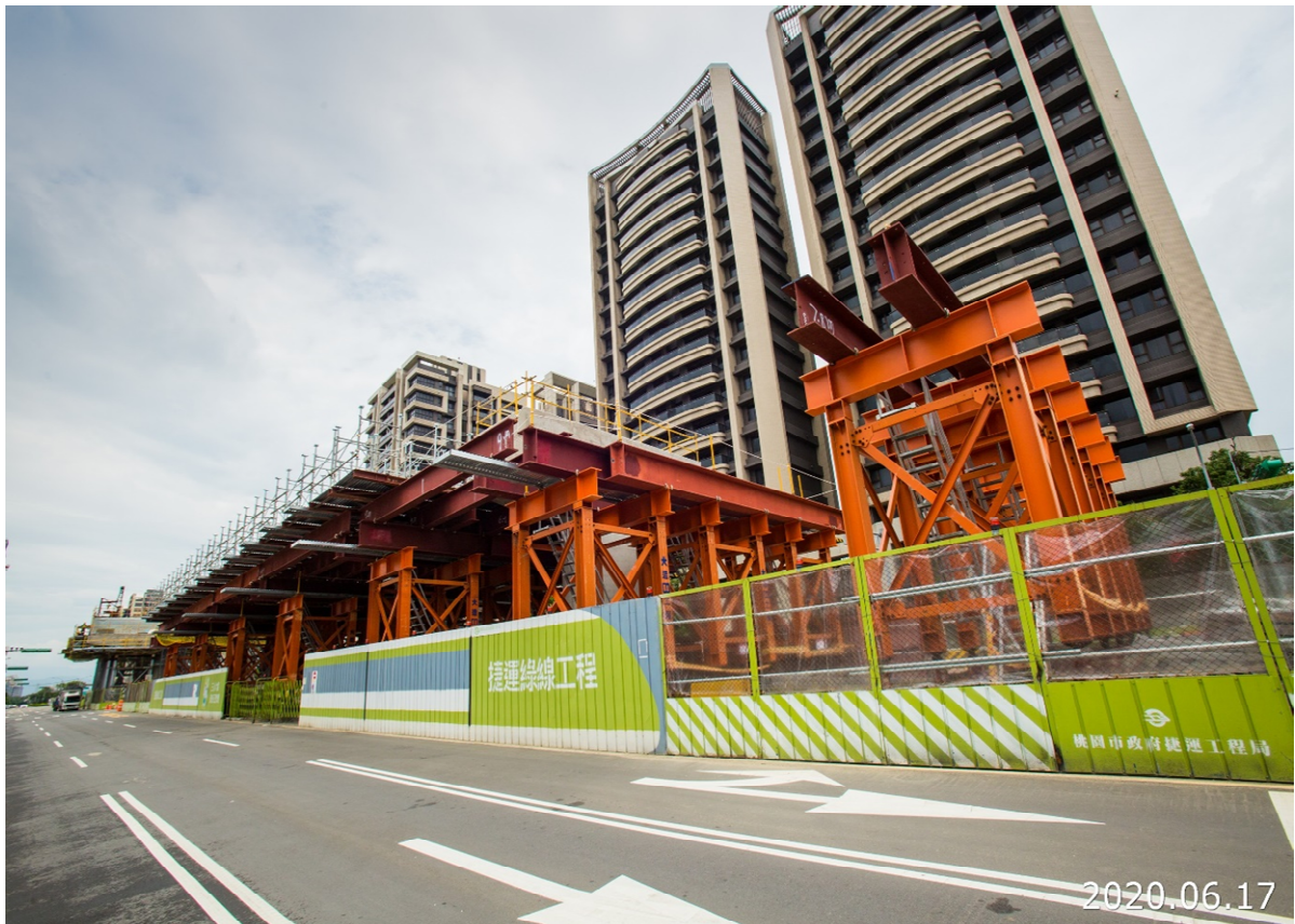
八德建德路 場撐箱型梁支撐架組立情形
