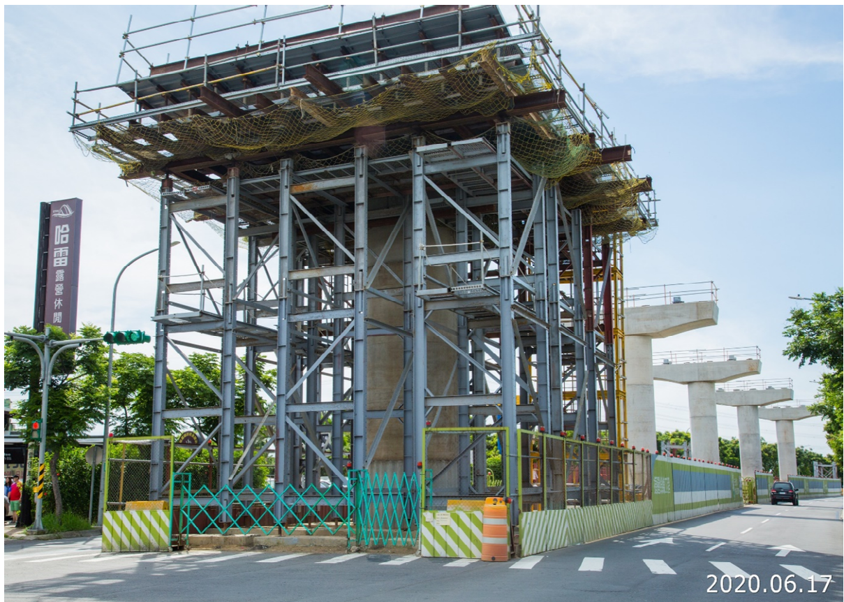
蘆竹中正北路 帽梁施工架搭設情形
