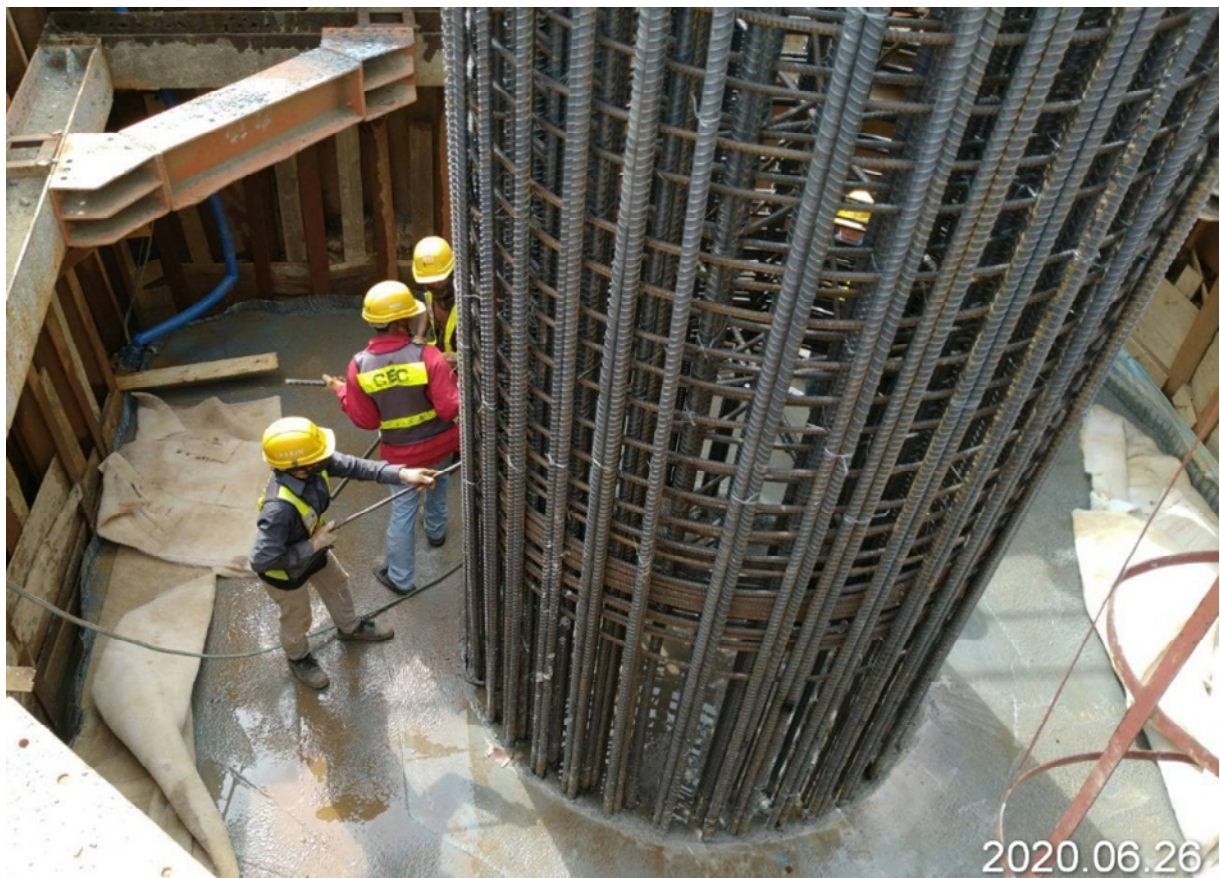
八德新闢道路 墩柱第一昇層鋼筋綁紮
