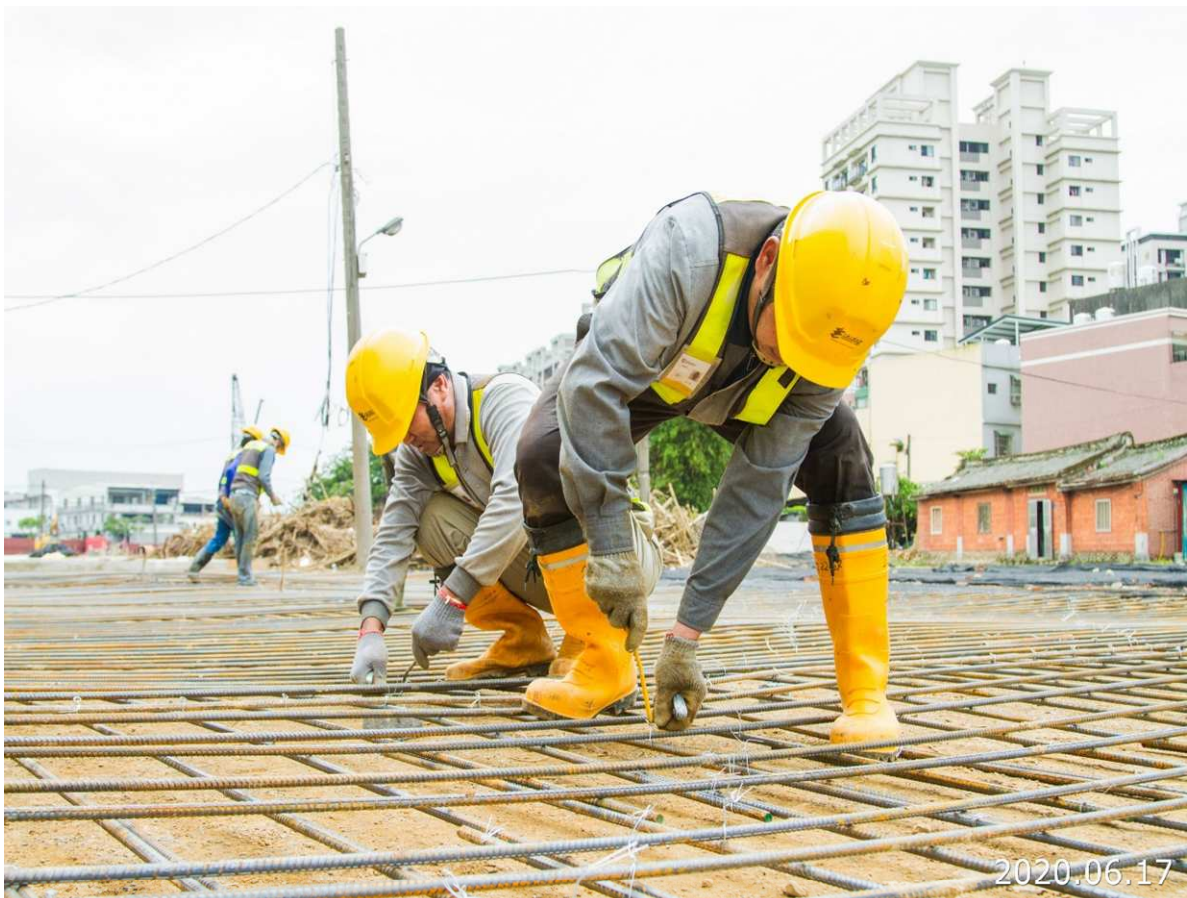
八德新闢道路 施工便道施作
