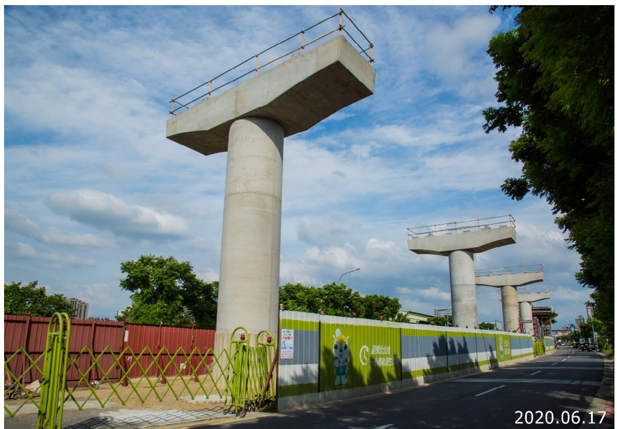
蘆竹中正北路 下部結構施工情形
