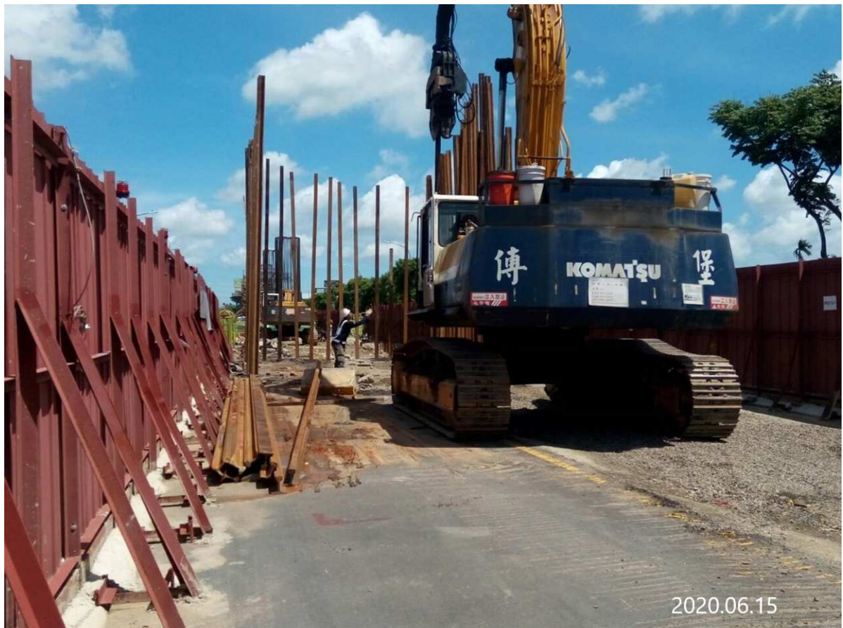
蘆竹中正北路 樁帽鋼軌樁打設
