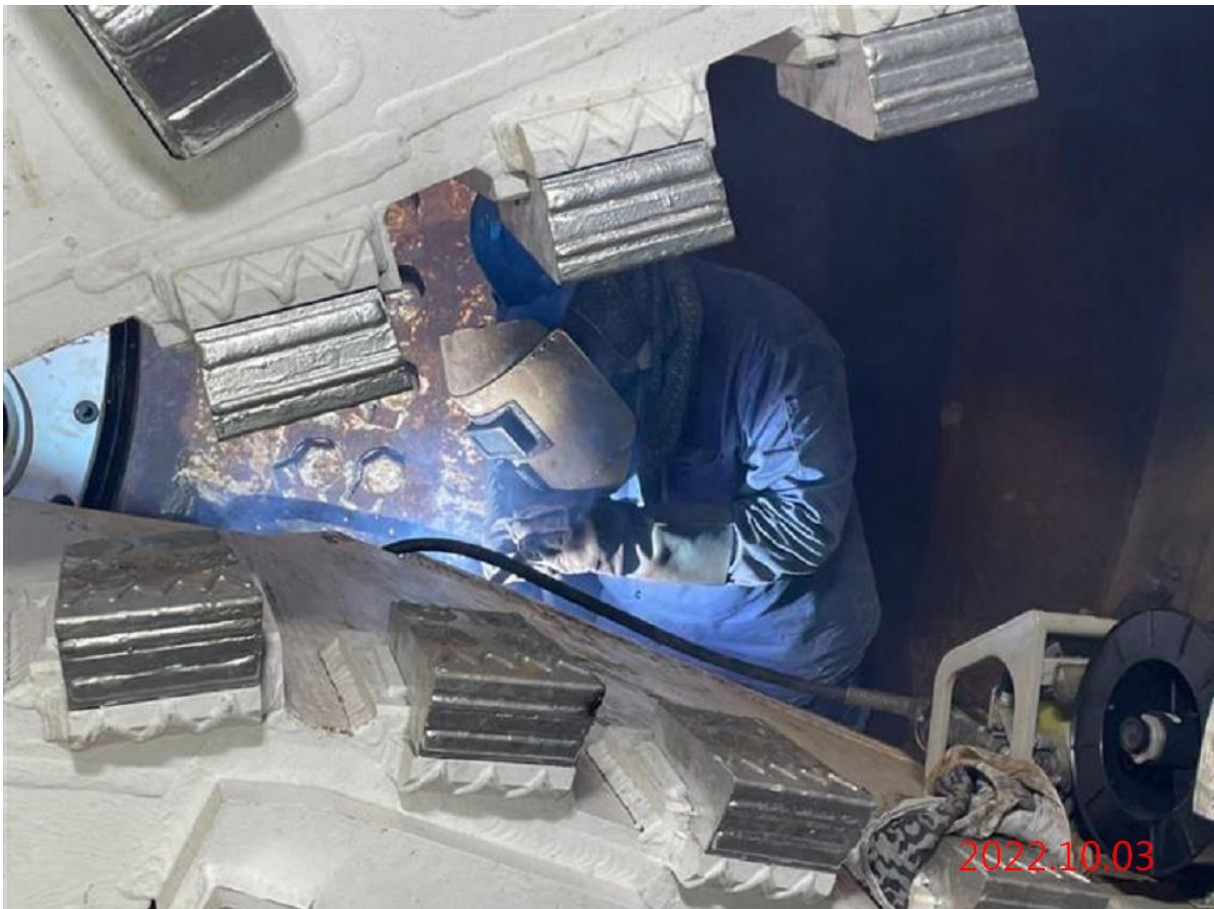
潛盾隧道_潛盾機新切刃盤安裝
