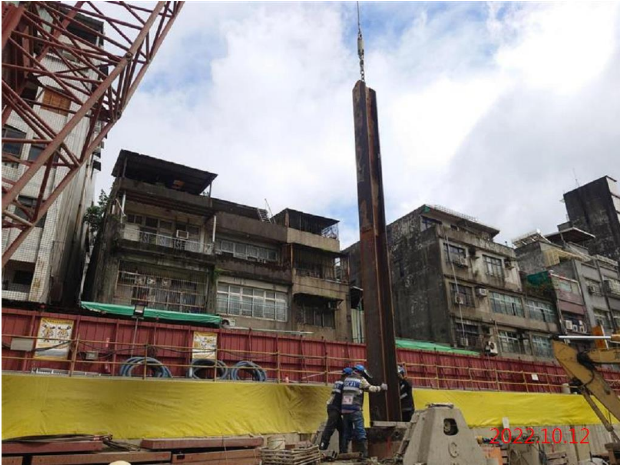
G08 站_中間柱鋼柱吊放
