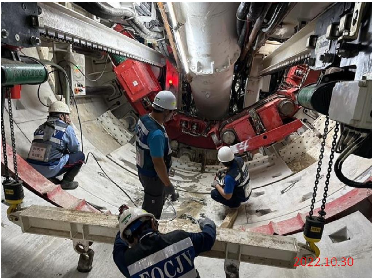
潛盾隧道_潛盾機掘進及環片組立
