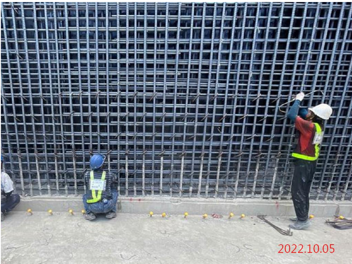
G12 站_通風井側牆鋼筋綁紮
