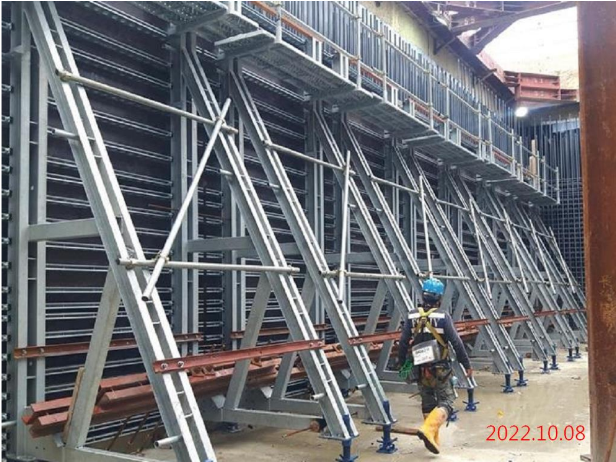
G12 站_通風井側牆模板組立
