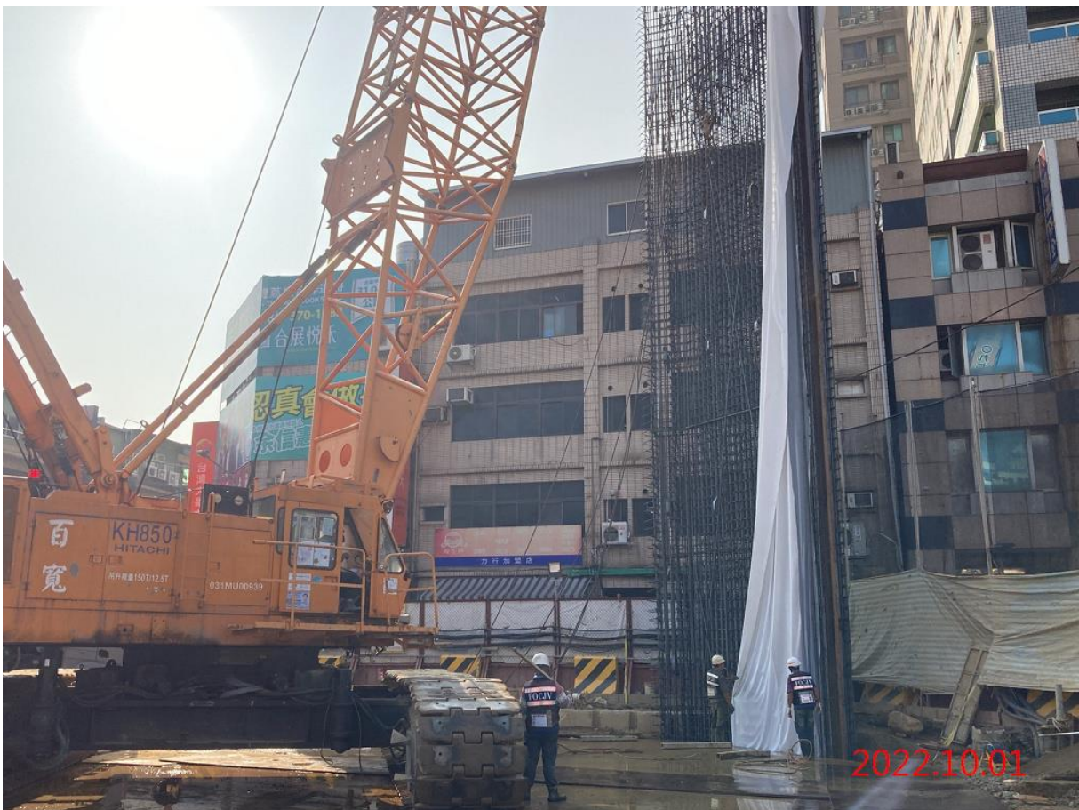
G09 站_連續壁鋼筋籠吊放
