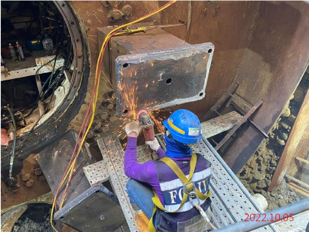
潛盾隧道_潛盾機檢修
