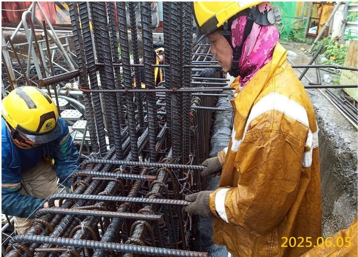
G03 通風井結構牆施作
