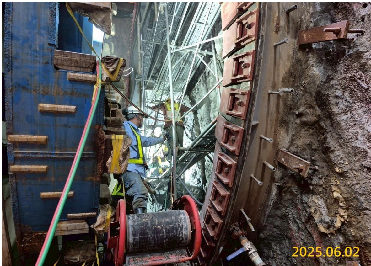
G06 站北井潛盾隧道發進前置作業-鏡面二次破除
