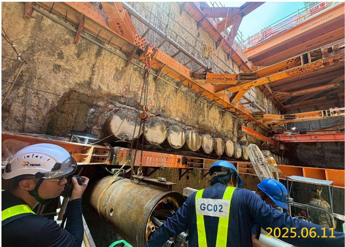
VS4 通風豎井路外段管幕推管前置作業
