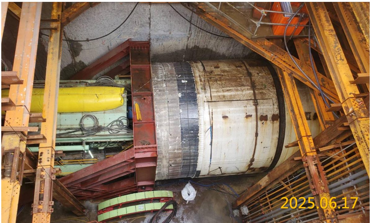
G06 站北井潛盾隧道下行線初期掘進
