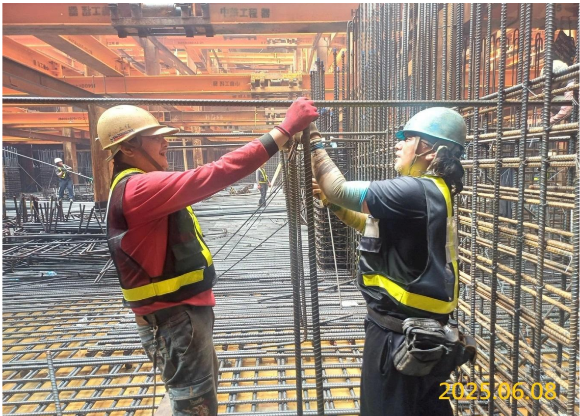
G04 出入口 B 底版施作
