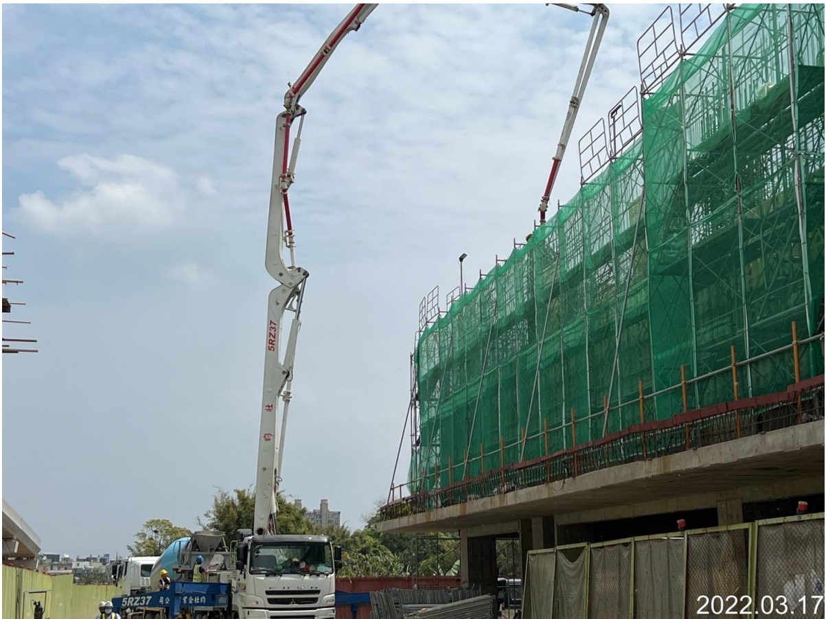
八德新闢道路 G02 車站 2 樓柱牆混凝土澆置
