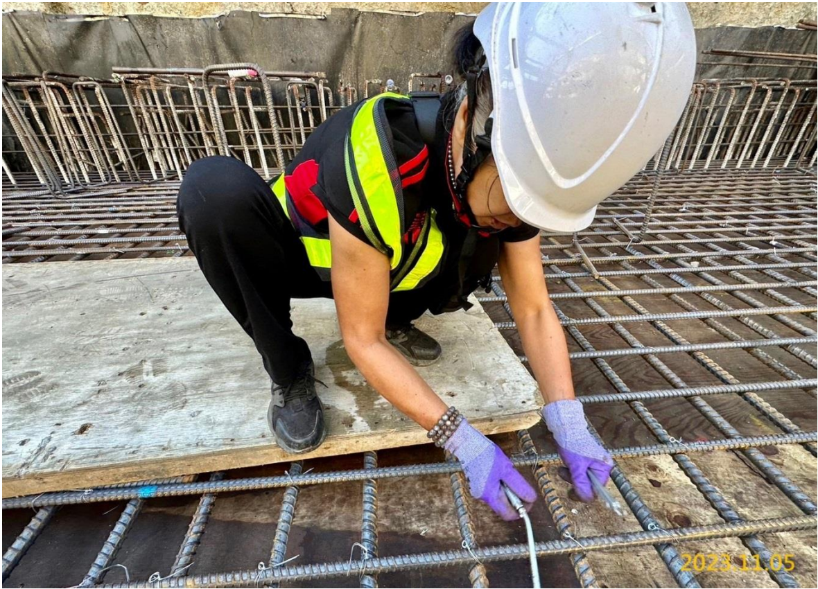
南出土段結構體施作
