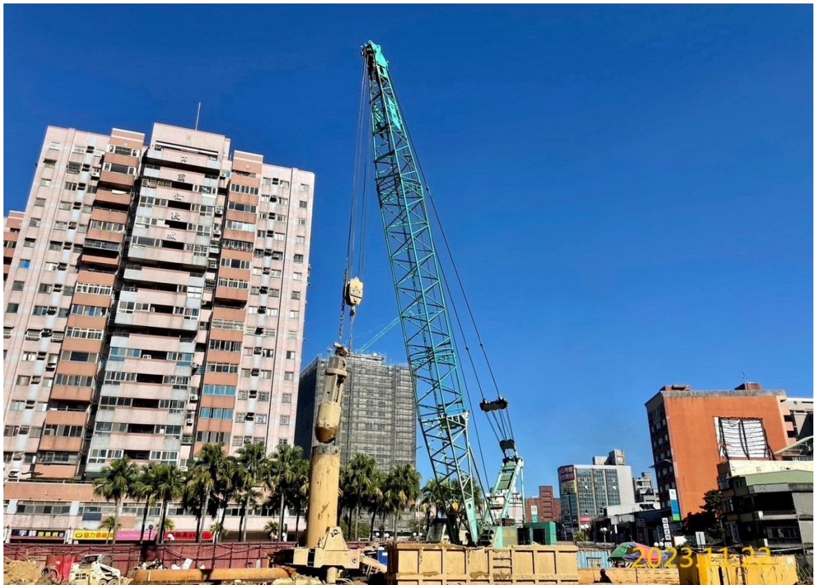
G04 站中間柱施作
