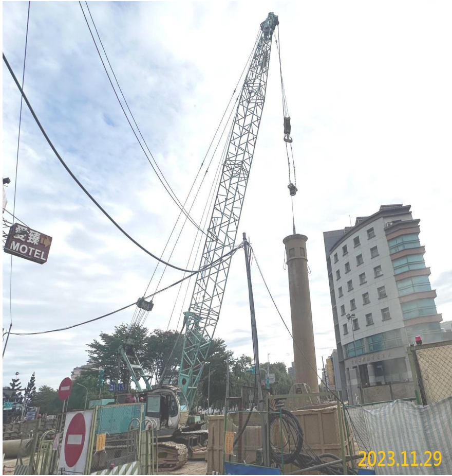
G06 站中間柱施作
