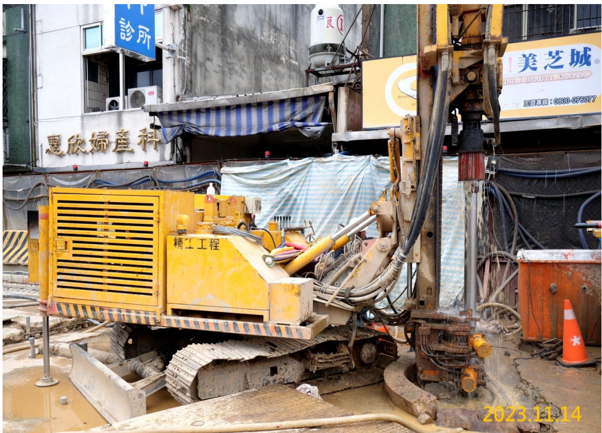
VS4 通風豎井地盤處理施作
