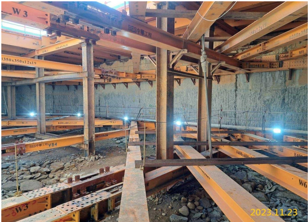
VS4 通風豎井支撐架設
