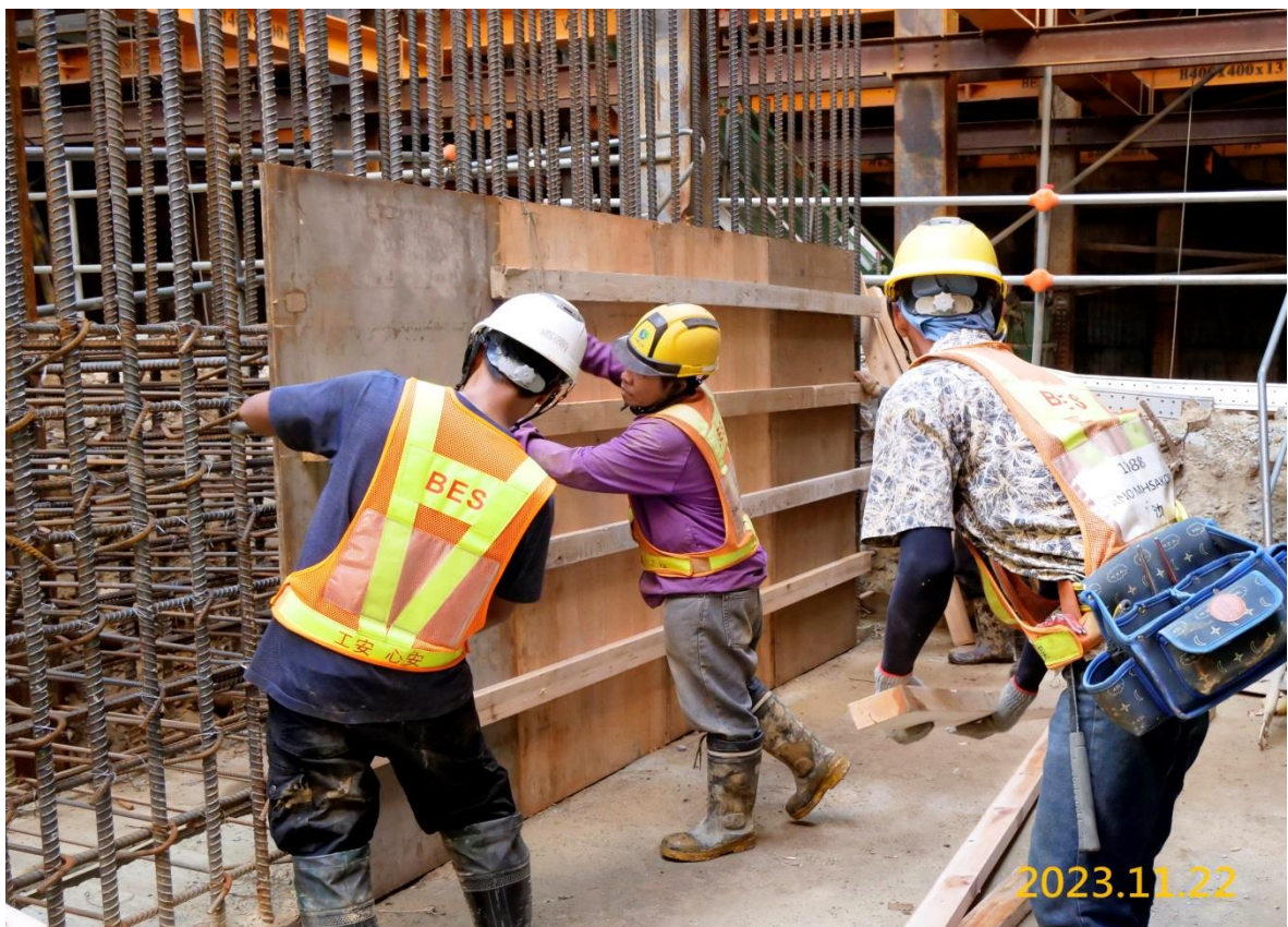
VS5 通風豎井結構體施作
