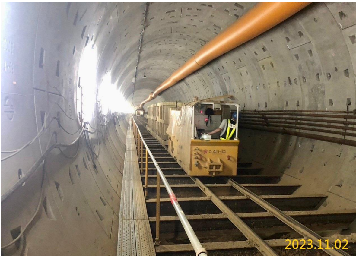
G03 站潛盾隧道掘進作業
