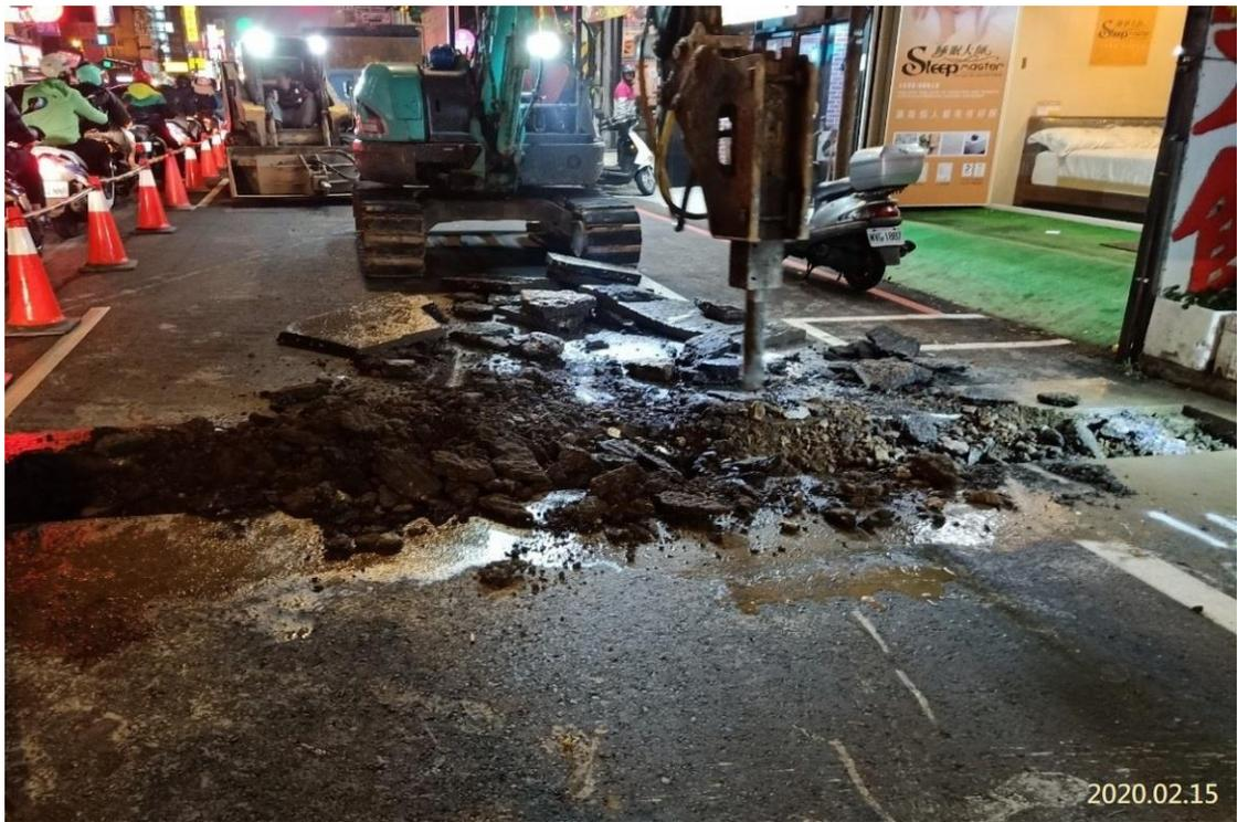
VS4(桃園大圳附近)管線試挖作業
