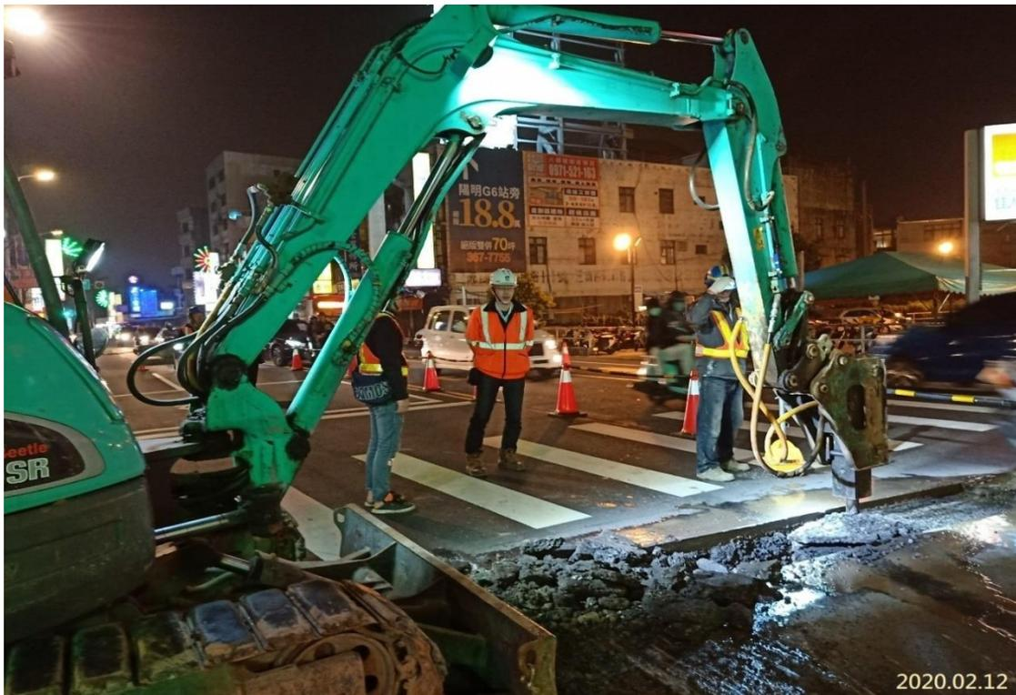
G05 站(東培工業附近)管線試挖作業
