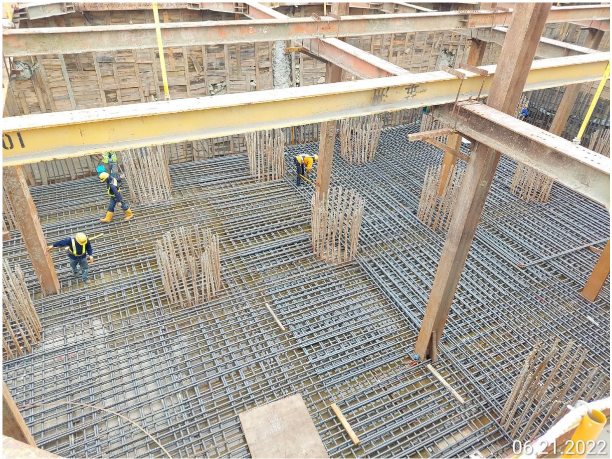
大園坑菓路 樁帽鋼筋綁紮
