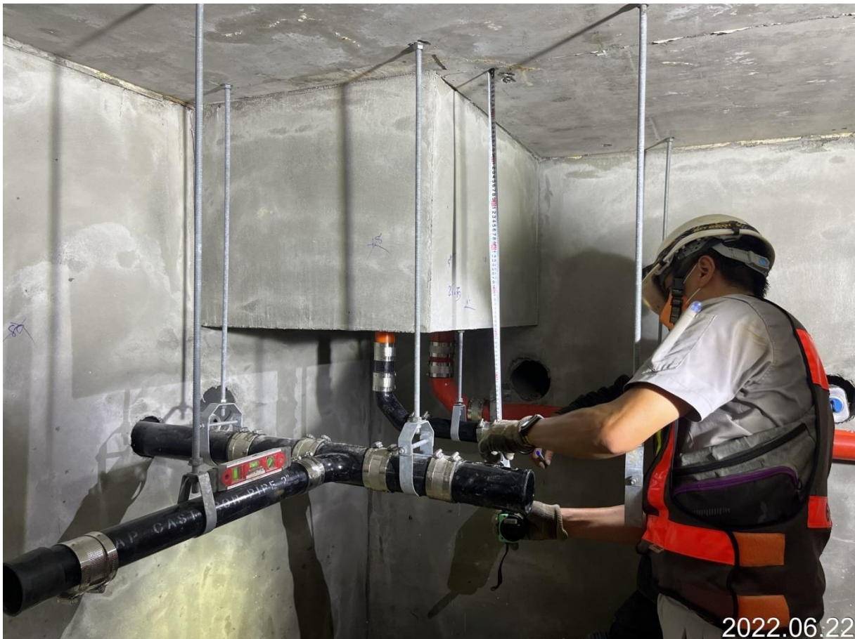
八德新闢道路 G02 車站出入口給排水管線施作
