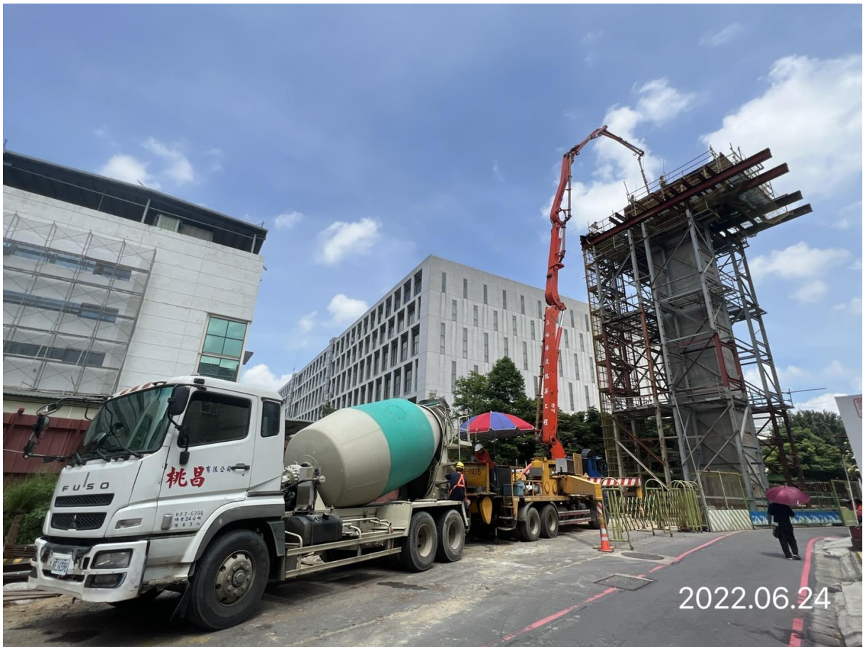
蘆竹蘆興街 帽梁混凝土澆置
