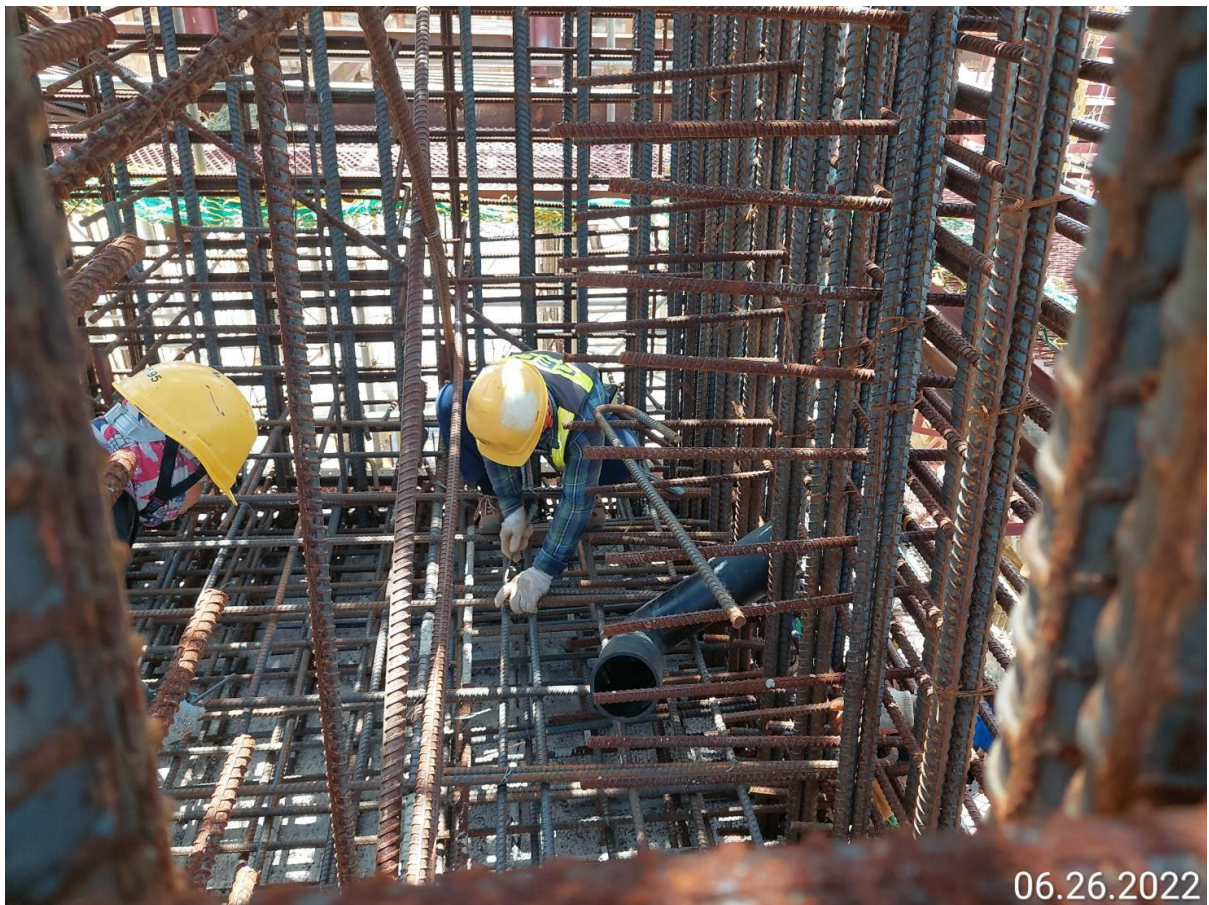
大園坑菓路 墩柱鋼筋綁紮
