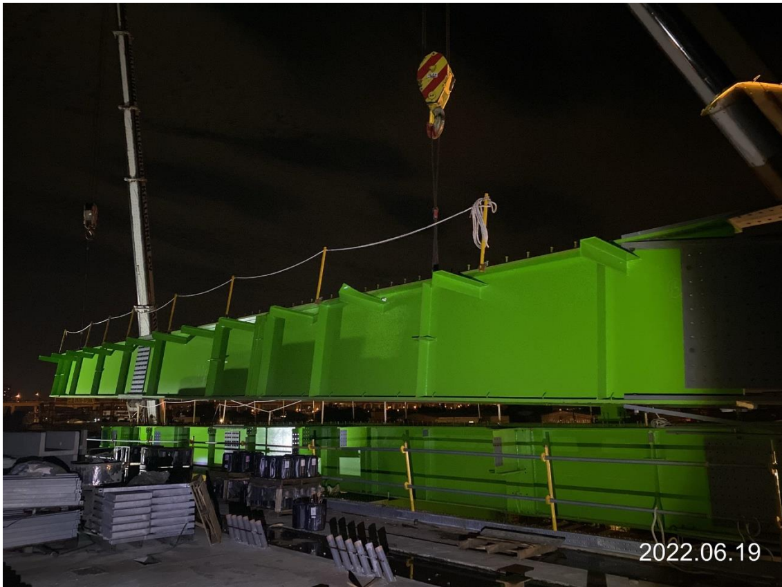
蘆竹中正北路 G13 車站月台梁施作
