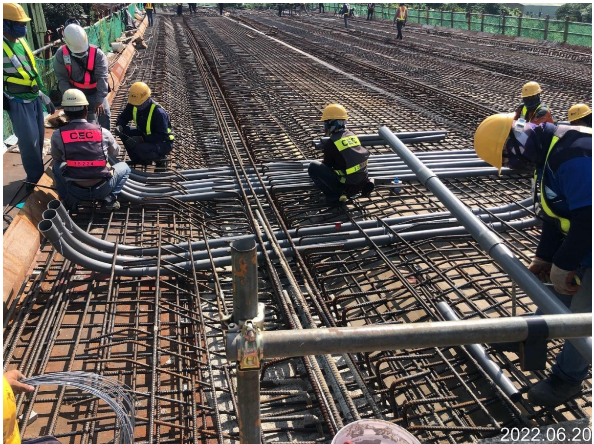
大園坑菓路 場撐箱型梁鋼筋綁紮
