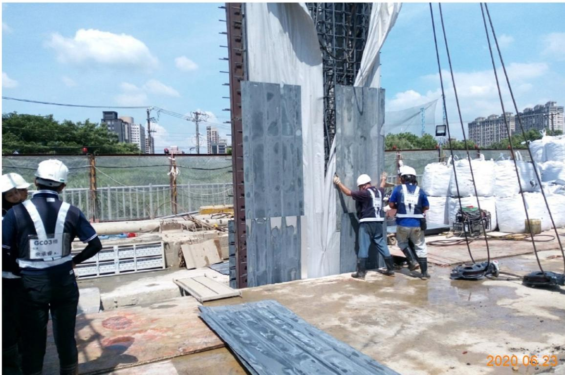
G12 站\_連續壁鋼筋籠吊放
