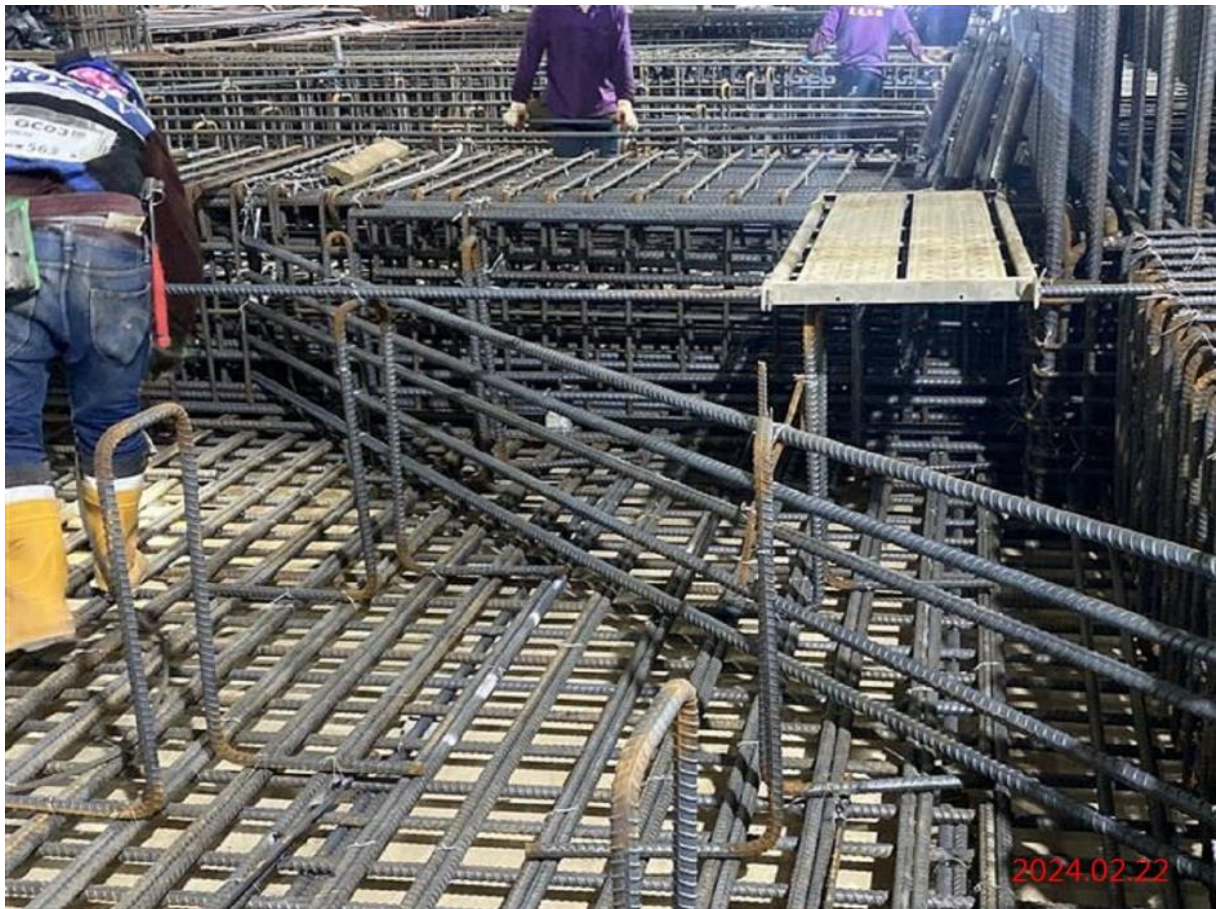
G07_結構 B3F 第一、二區鋼筋綁紮
