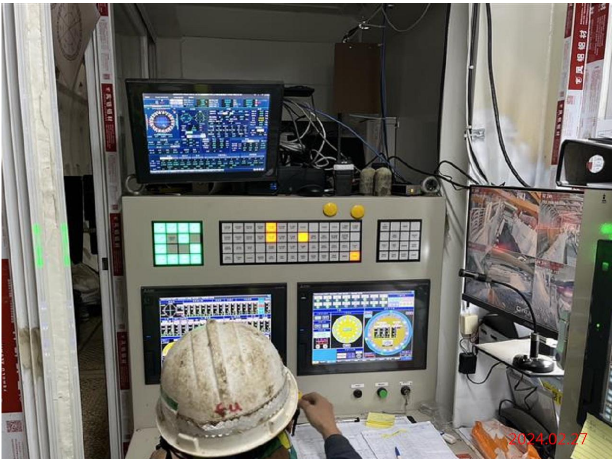
潛盾隧道_中圓上行線掘進(G10-G09)
