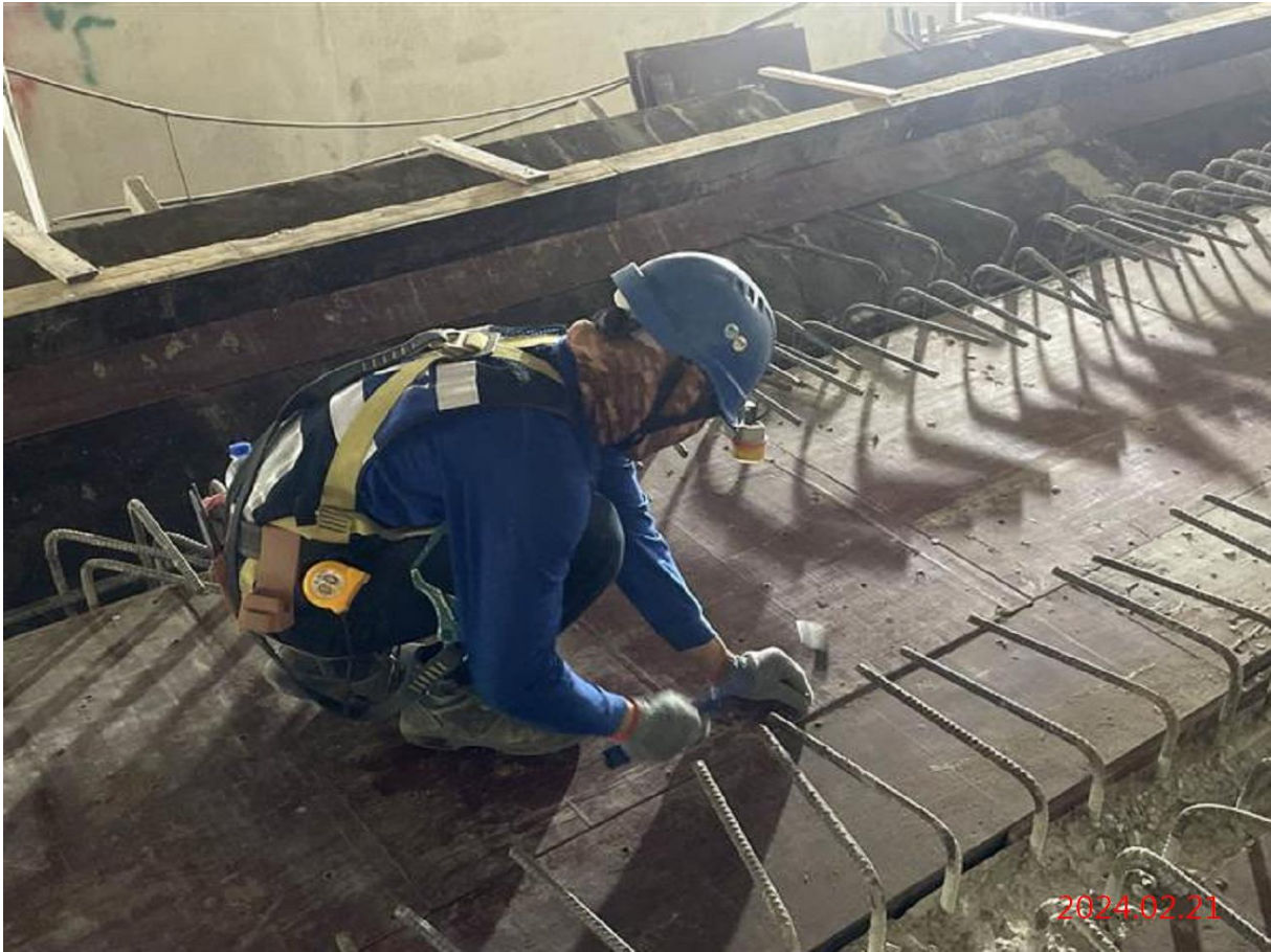
G12_站體月台版模板施作
