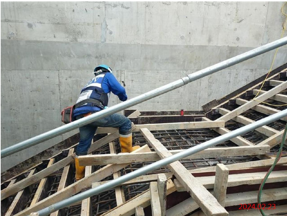
G12_出入口 A 夾層樓梯模板施作
