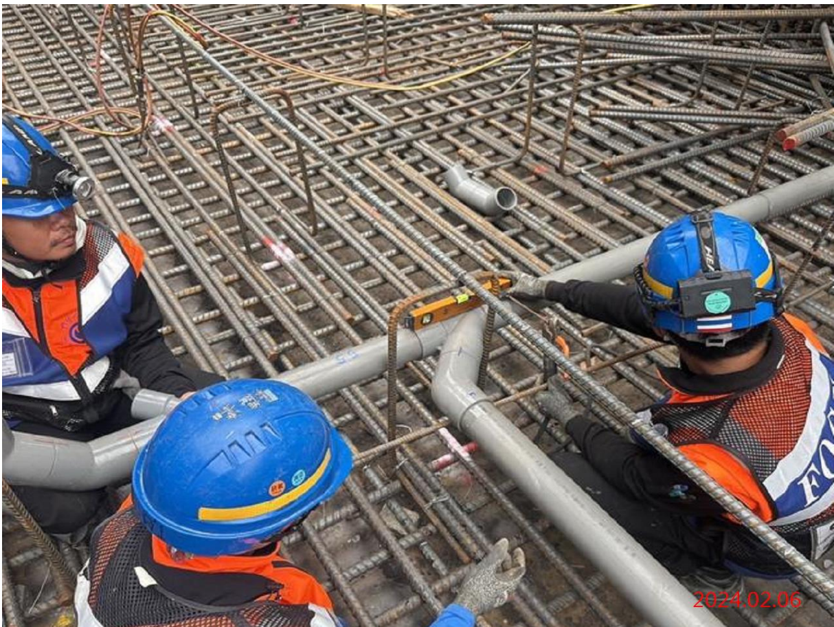
G11_出入口夾層版預埋管施作
