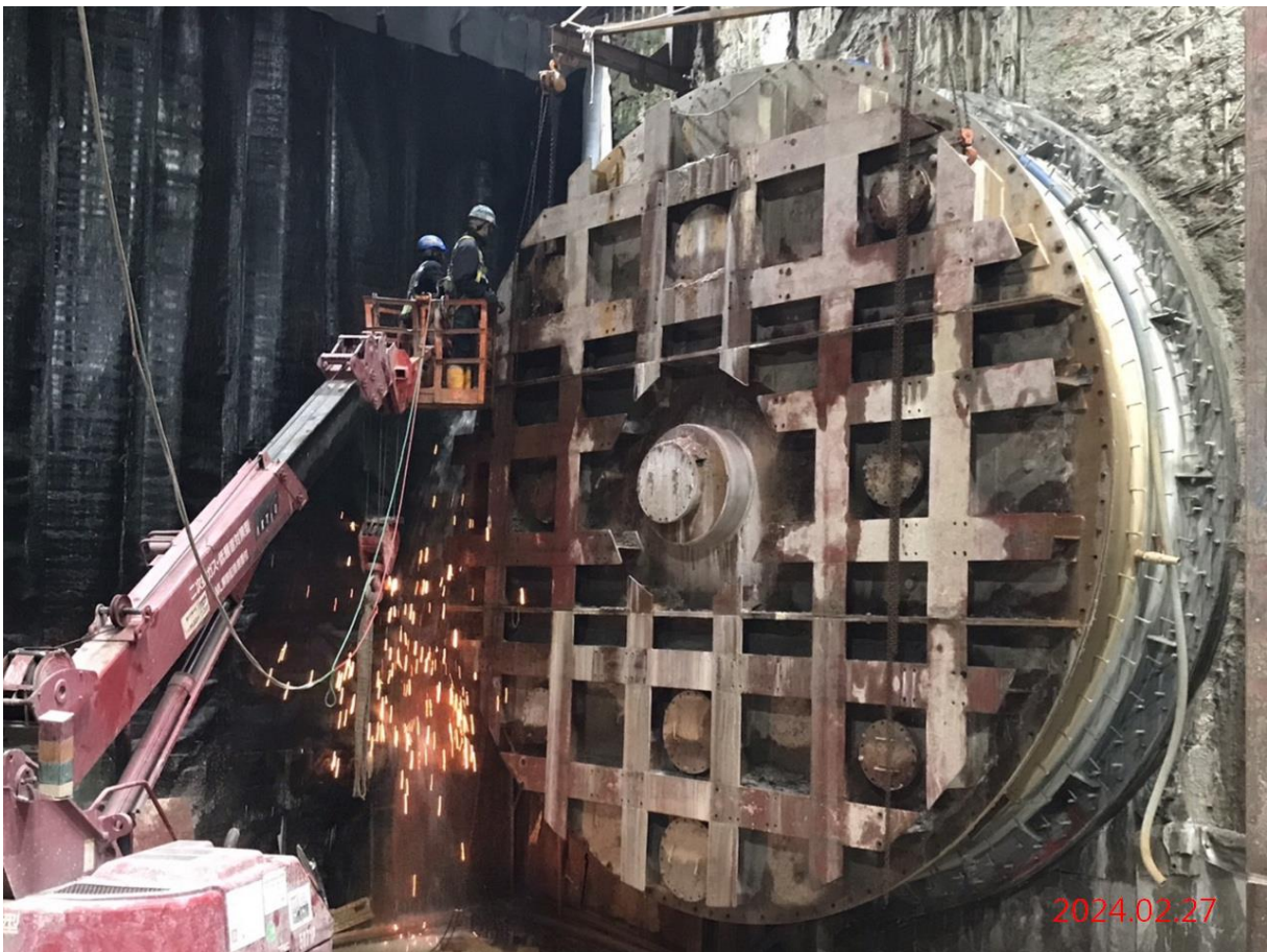
潛盾隧道_小圓下行線 G11 站北井隔艙面板拆除
