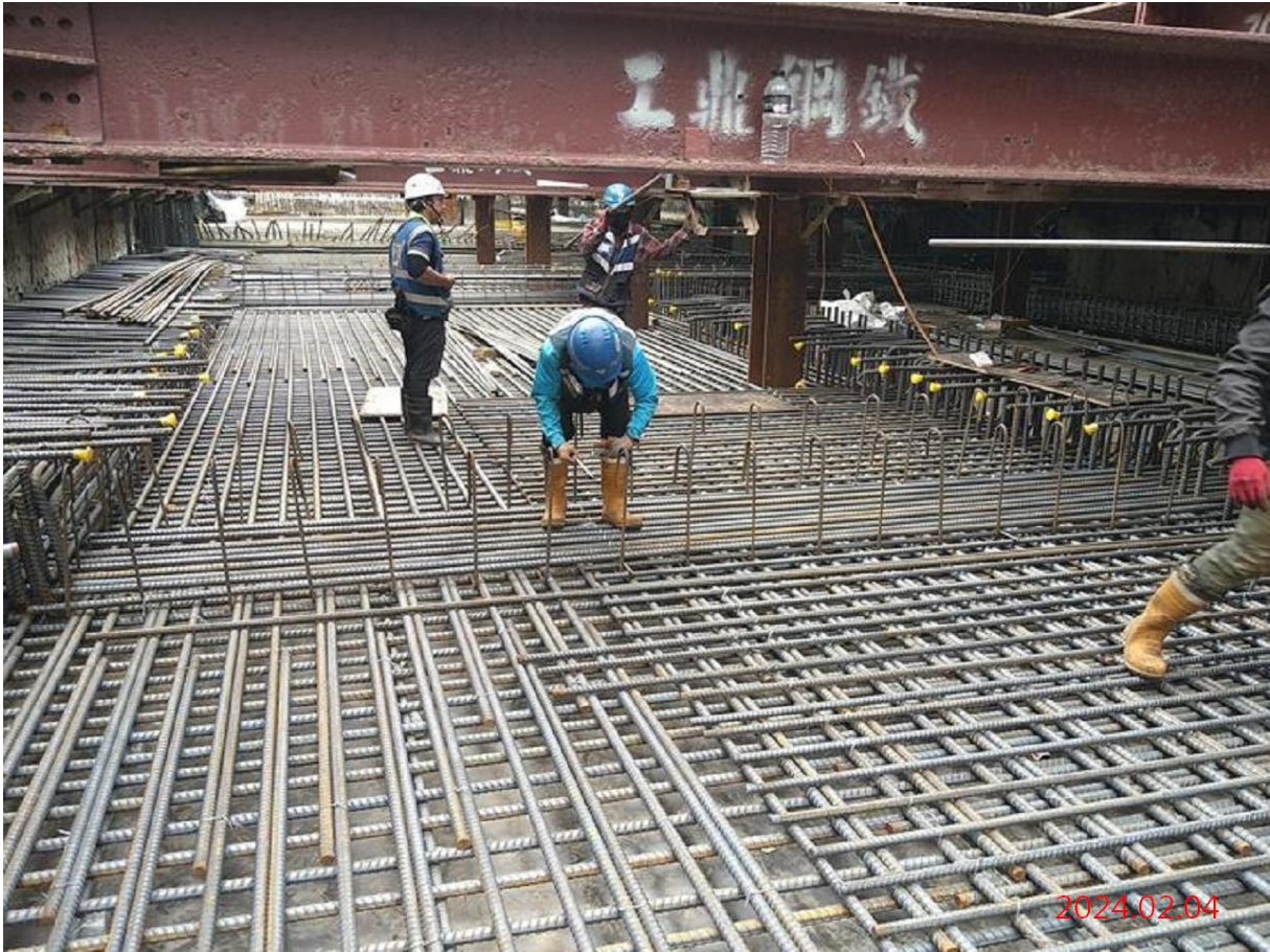
G11_出入口夾層板鋼筋施作
