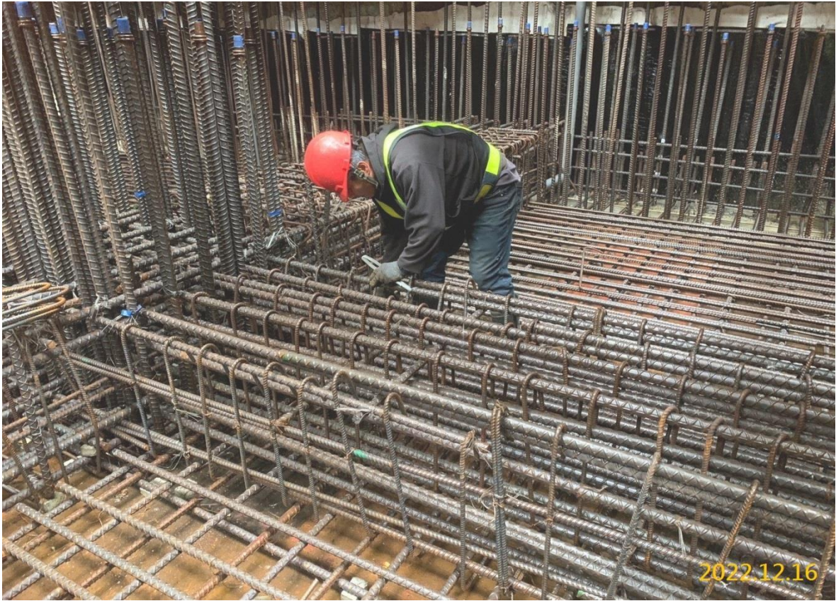
VS6 通風豎井結構體鋼筋綁紮
