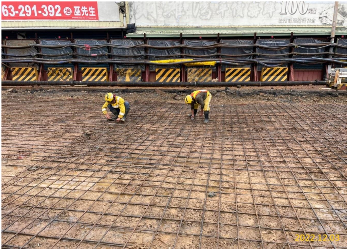
G05 站連續壁導溝工作場地鋪面施作
