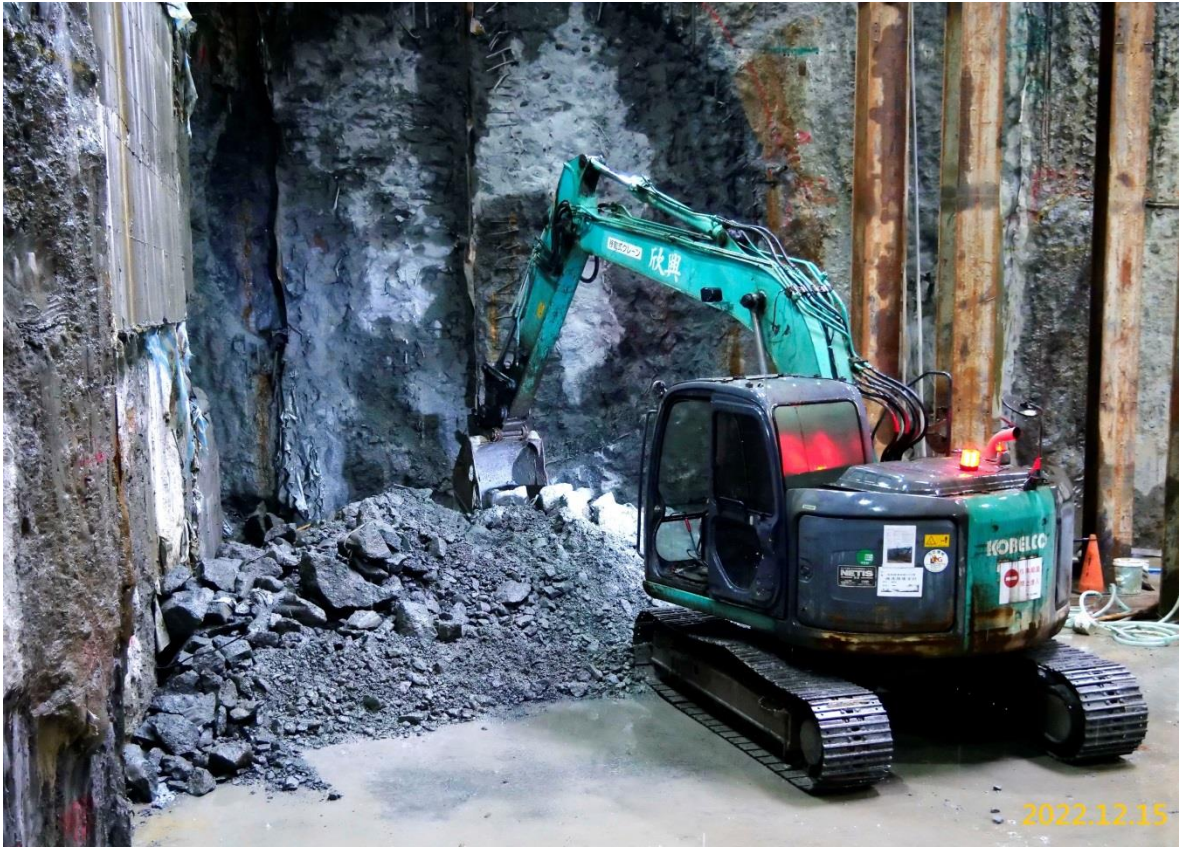
G03 站潛盾隧道鏡面破除
