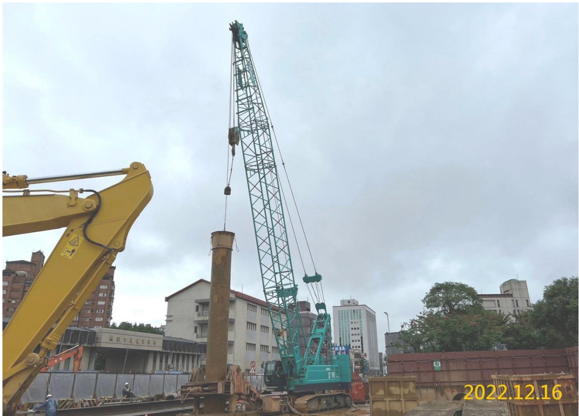
G06 站中間柱施作
