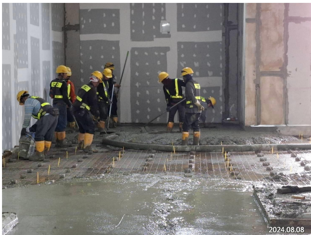
G14 車站站體穿堂層墊層混凝土澆置
