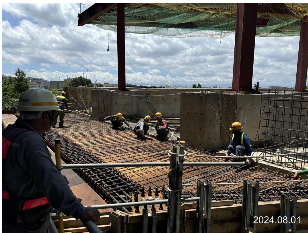
G32 月台梁（TG3~TG5）頂版鋼筋綁紮
