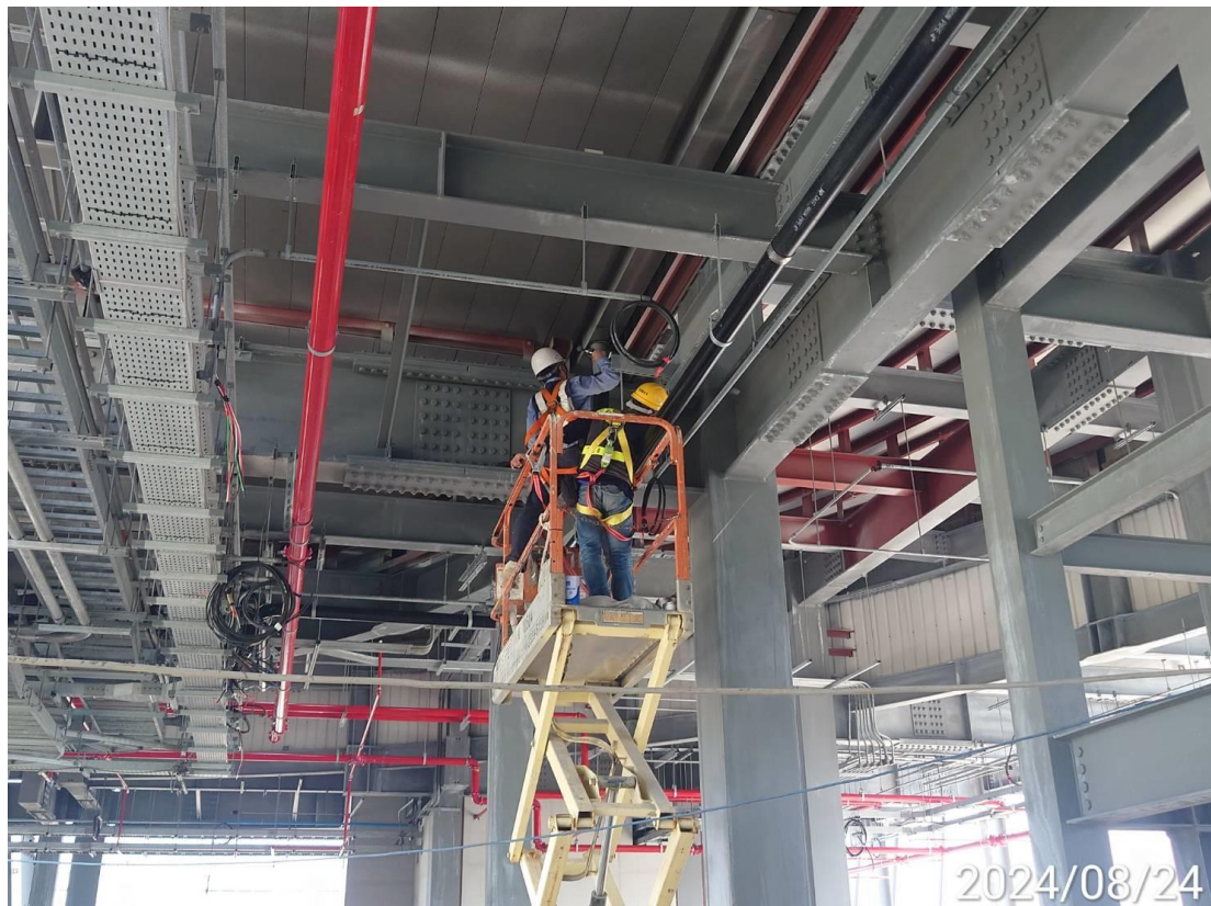
G13a 車站站體屋突雨排管施作
