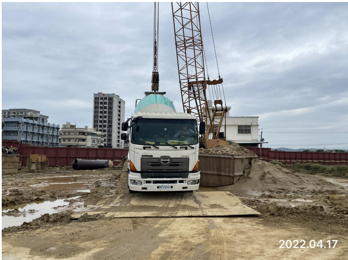
大園三民路二段 基樁混凝土澆置
