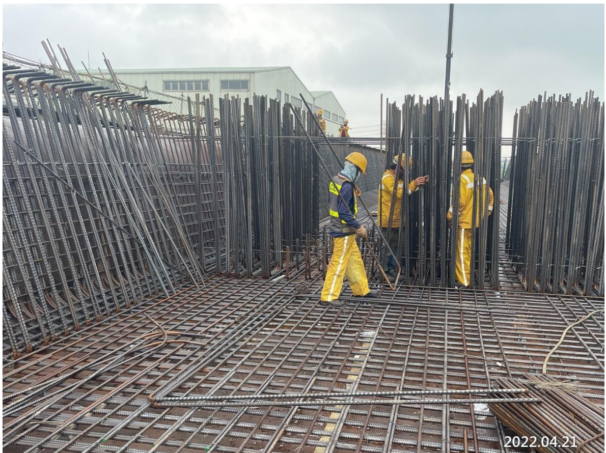
蘆竹中正北路 場撐箱型梁鋼筋綁紮
