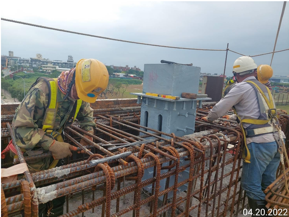
大園坑菓路 帽梁鋼筋綁紮
