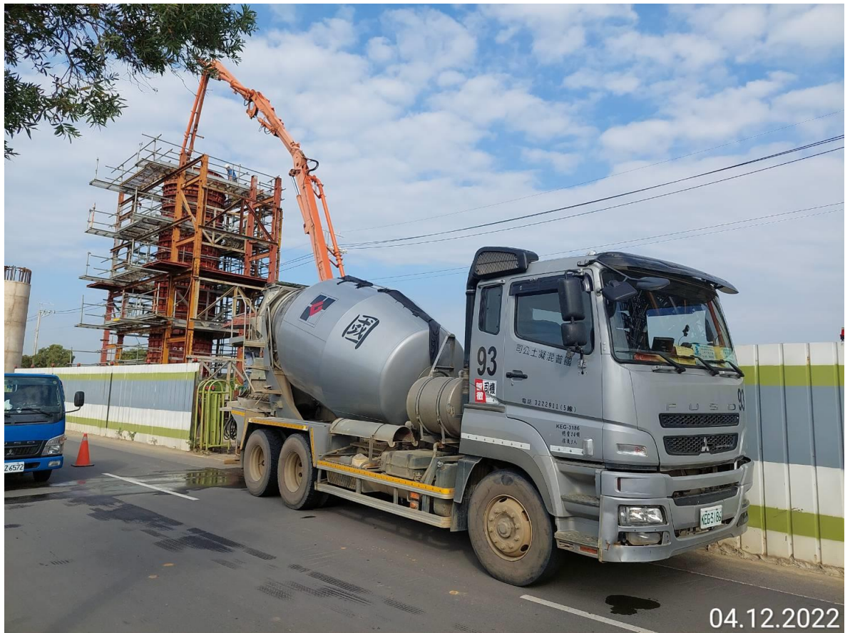
大園坑菓路 墩柱混凝土澆置
