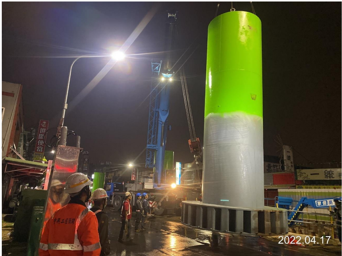
蘆竹南崁路二段 鋼墩柱吊裝
