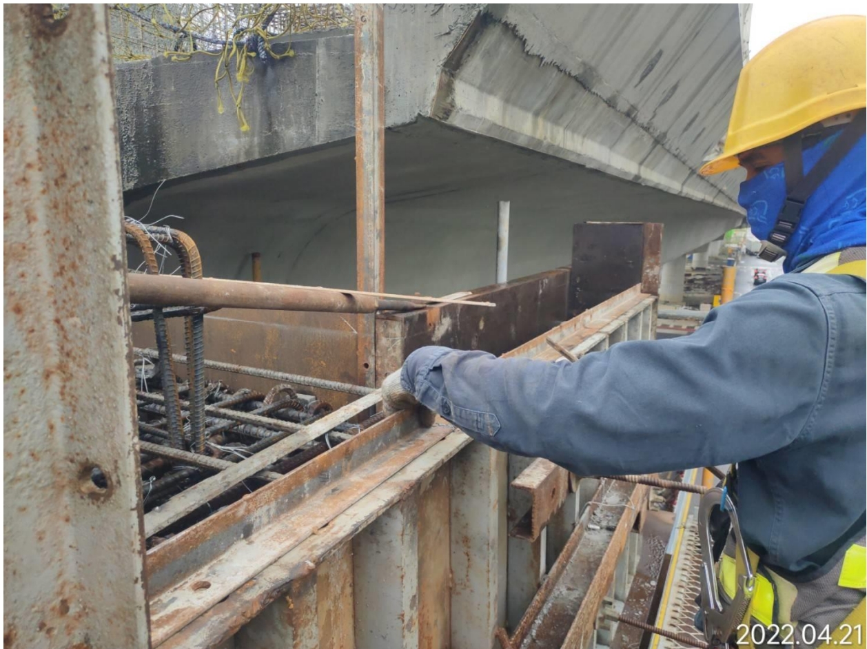
八德建德路 帽梁剪力鋼箱施作
