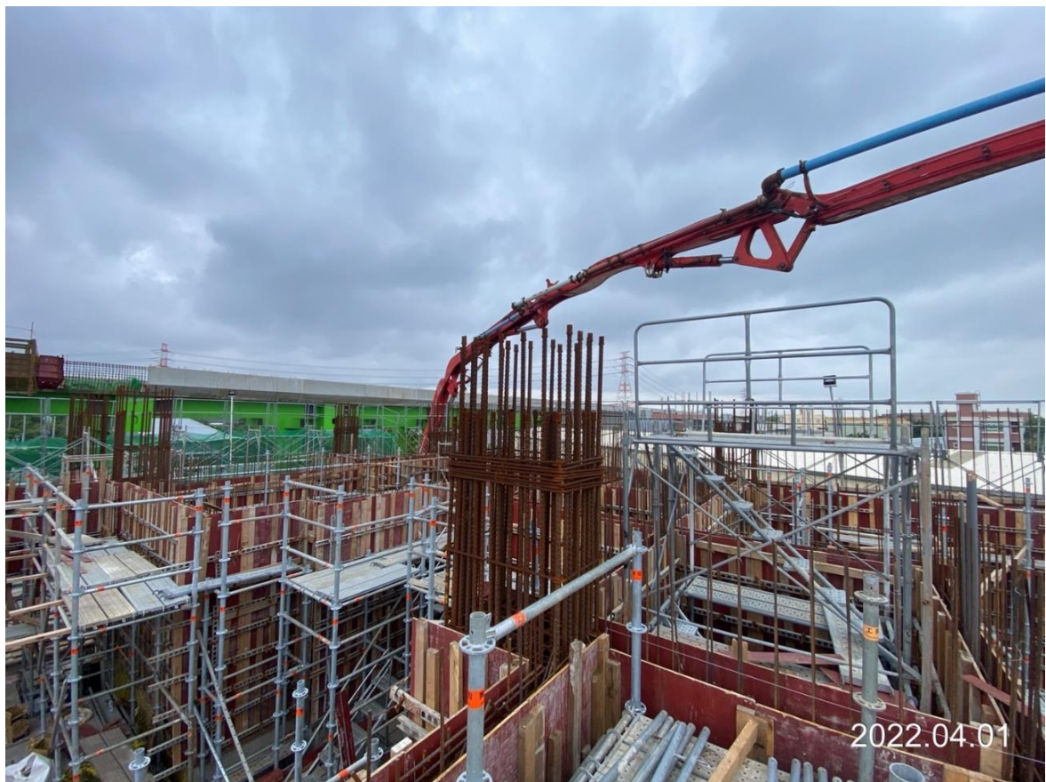
蘆竹中正北路 G13a 車站出入口 1 樓柱牆混凝土澆置
