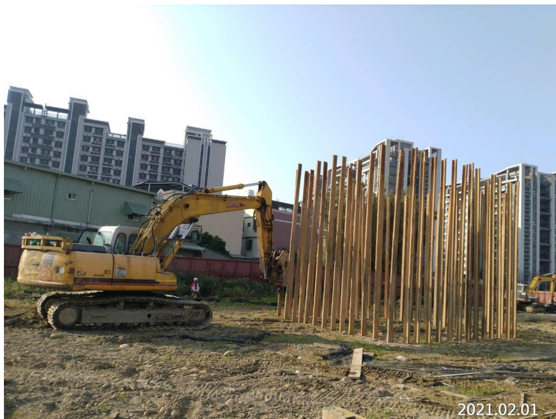
八德新闢道路 樁帽鋼軌樁施作
