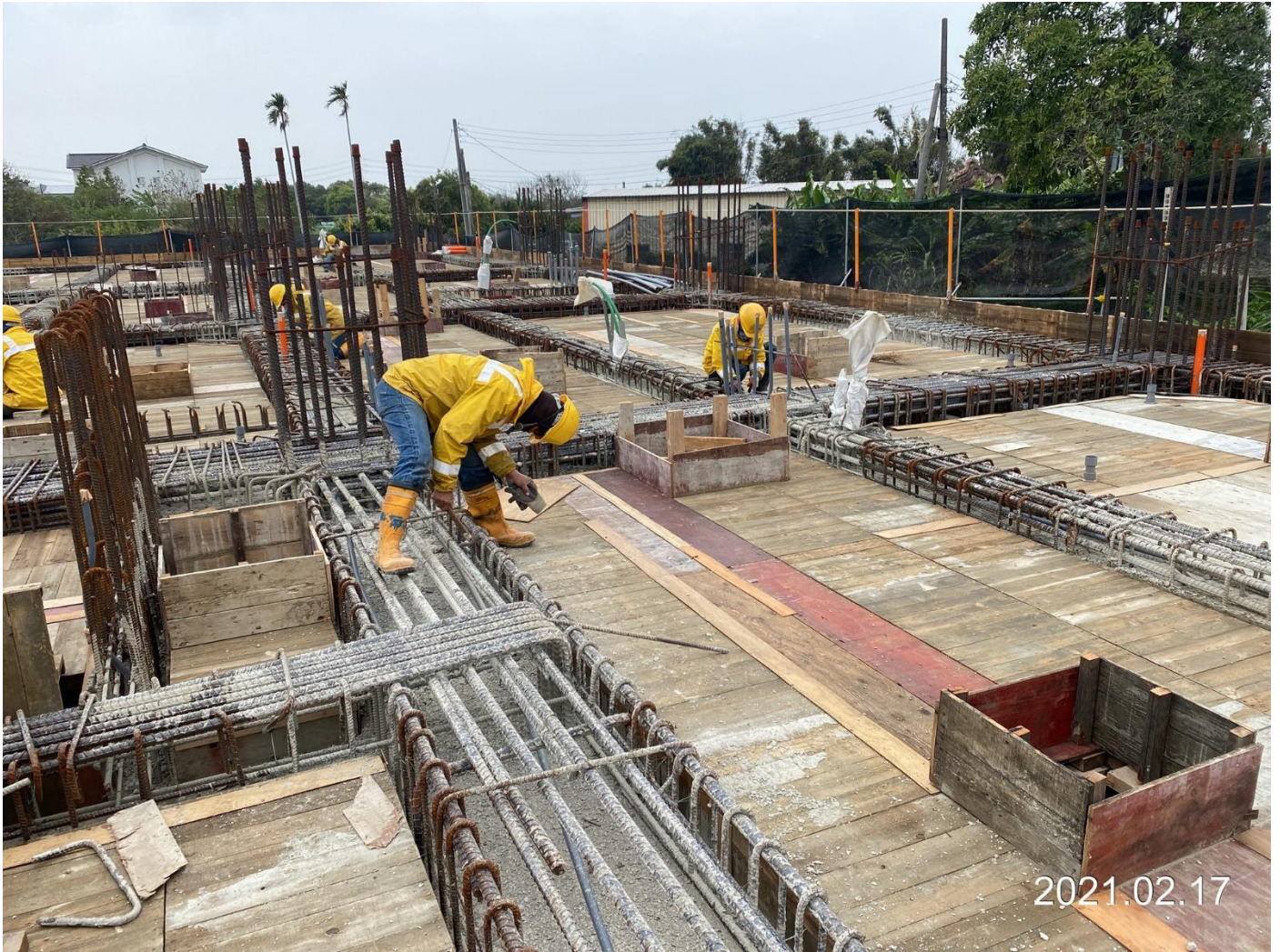
蘆竹中正北路 G13 車站 1 樓版模版組立
