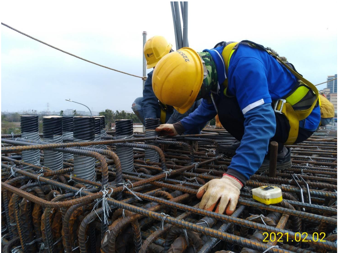
蘆竹中正北段 帽梁盤式支承鋼筋綁紮
