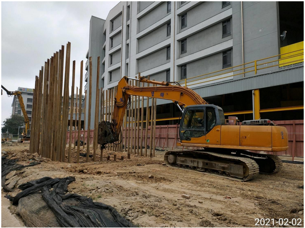
蘆竹蘆興街 樁帽鋼軌樁施作
