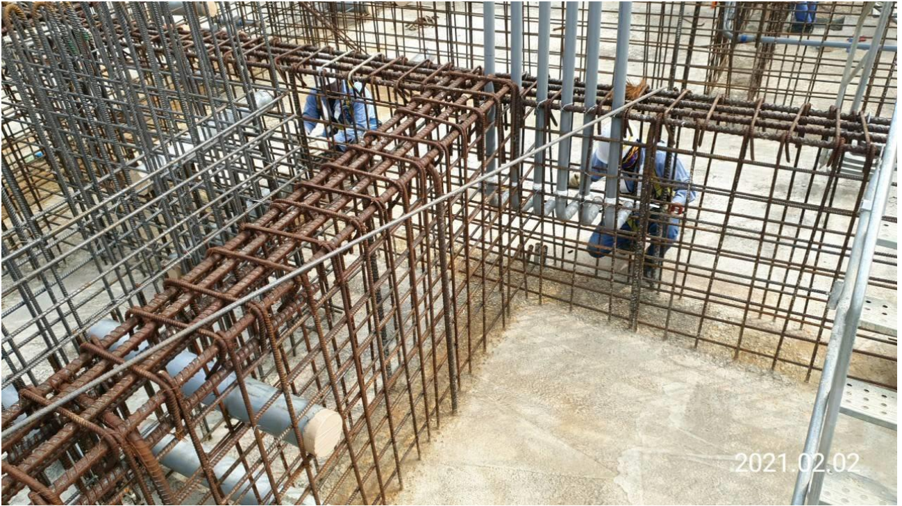
八德建德路 G01 車站出入口地梁鋼筋綁紮
