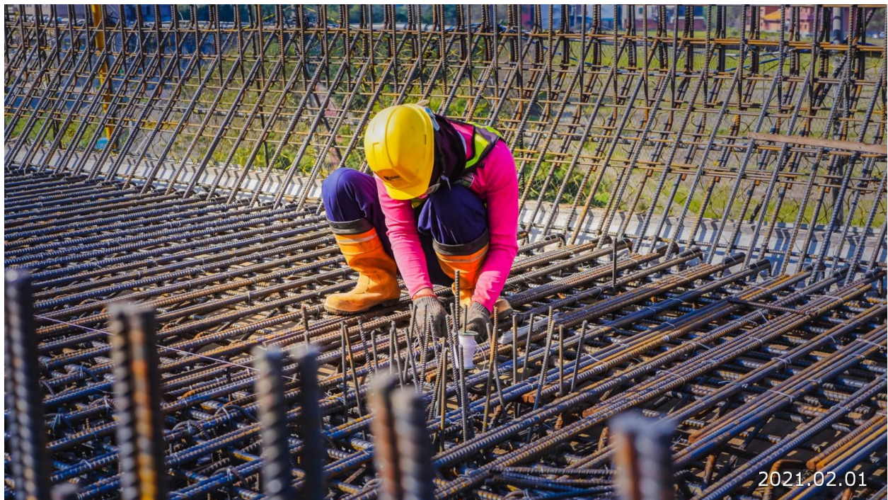
八德新關道路 場鑄箱型梁橋面版施作情形
