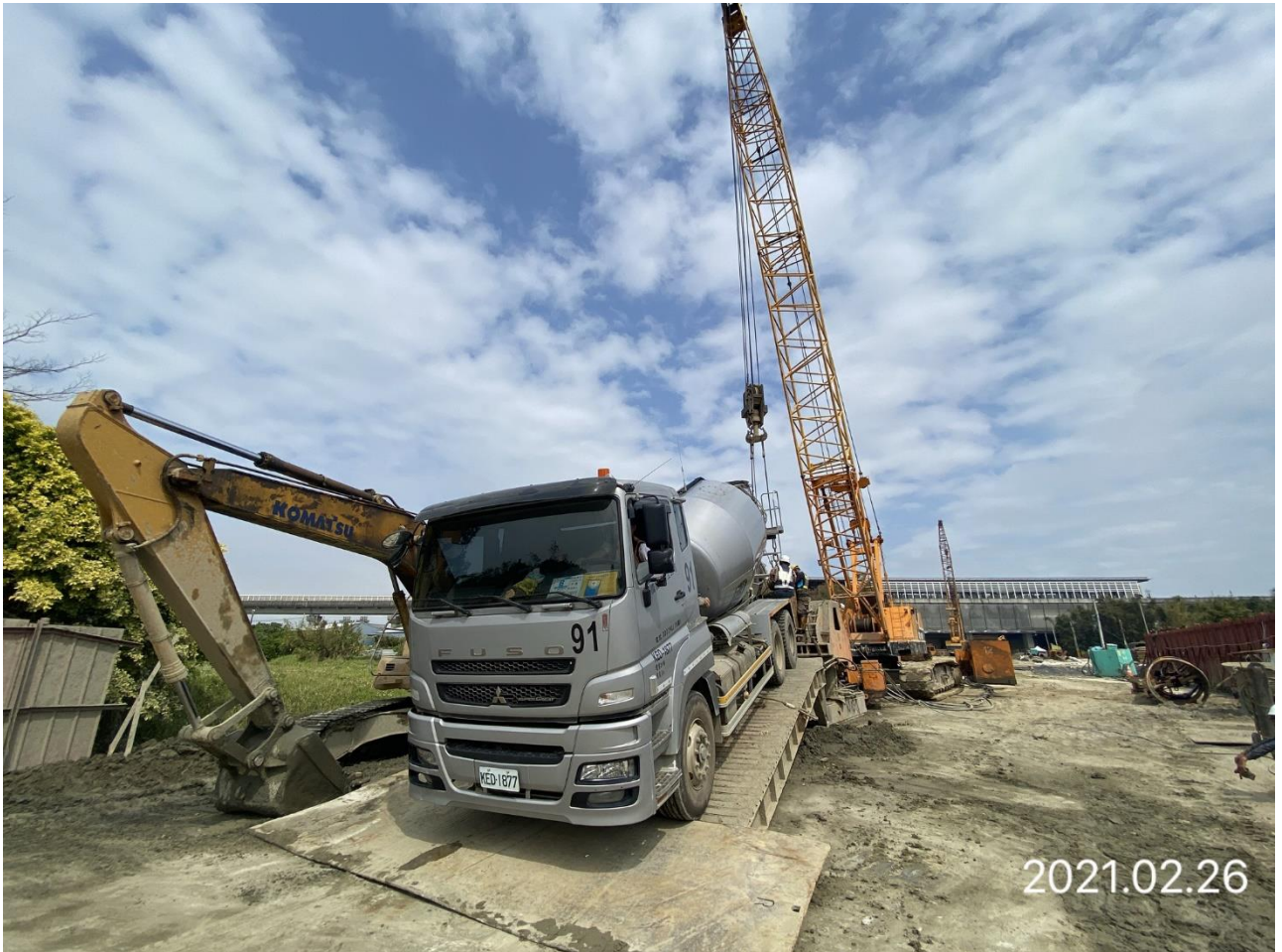
大園坑菓路 基樁混凝土澆置
