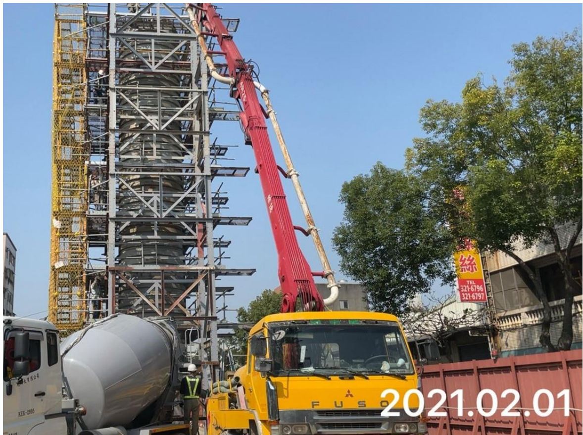
蘆竹南崁路二段 墩柱混凝土澆置
