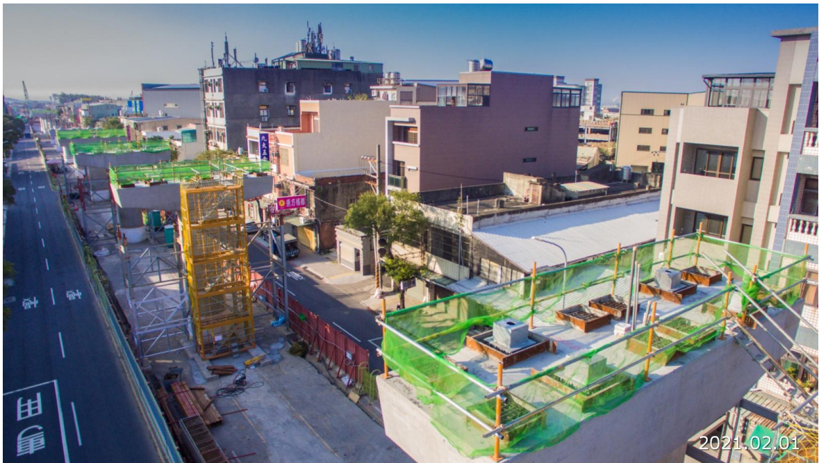
蘆竹南崁路二段 帽梁施作情形
