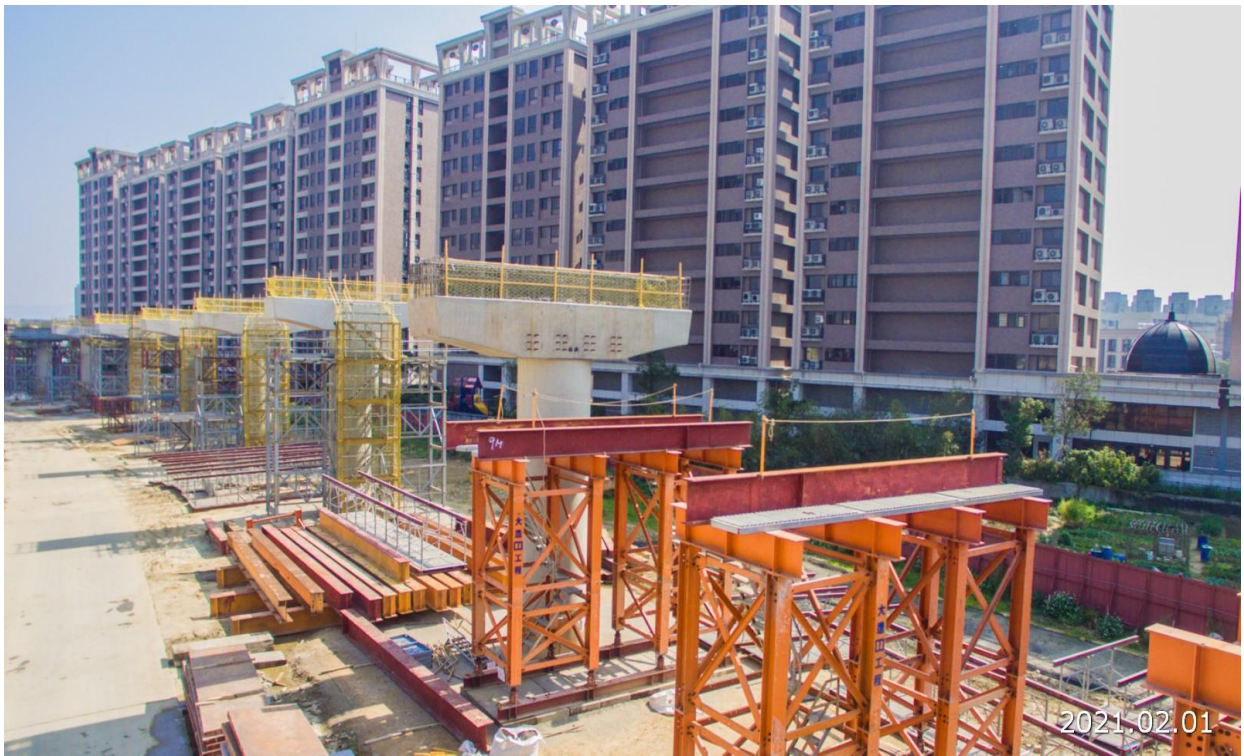
八德新關道路 墩柱施作情形
