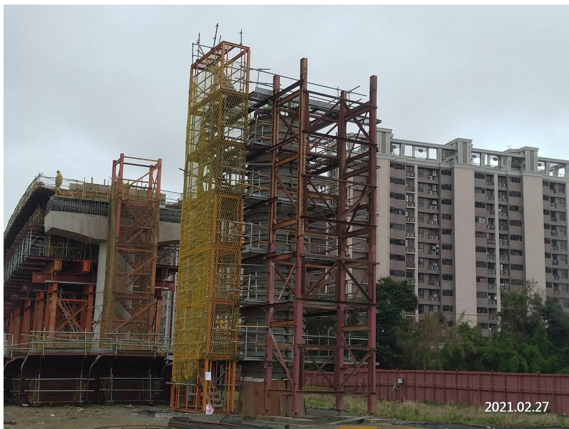
八德新闢道路 墩柱施工架搭設
