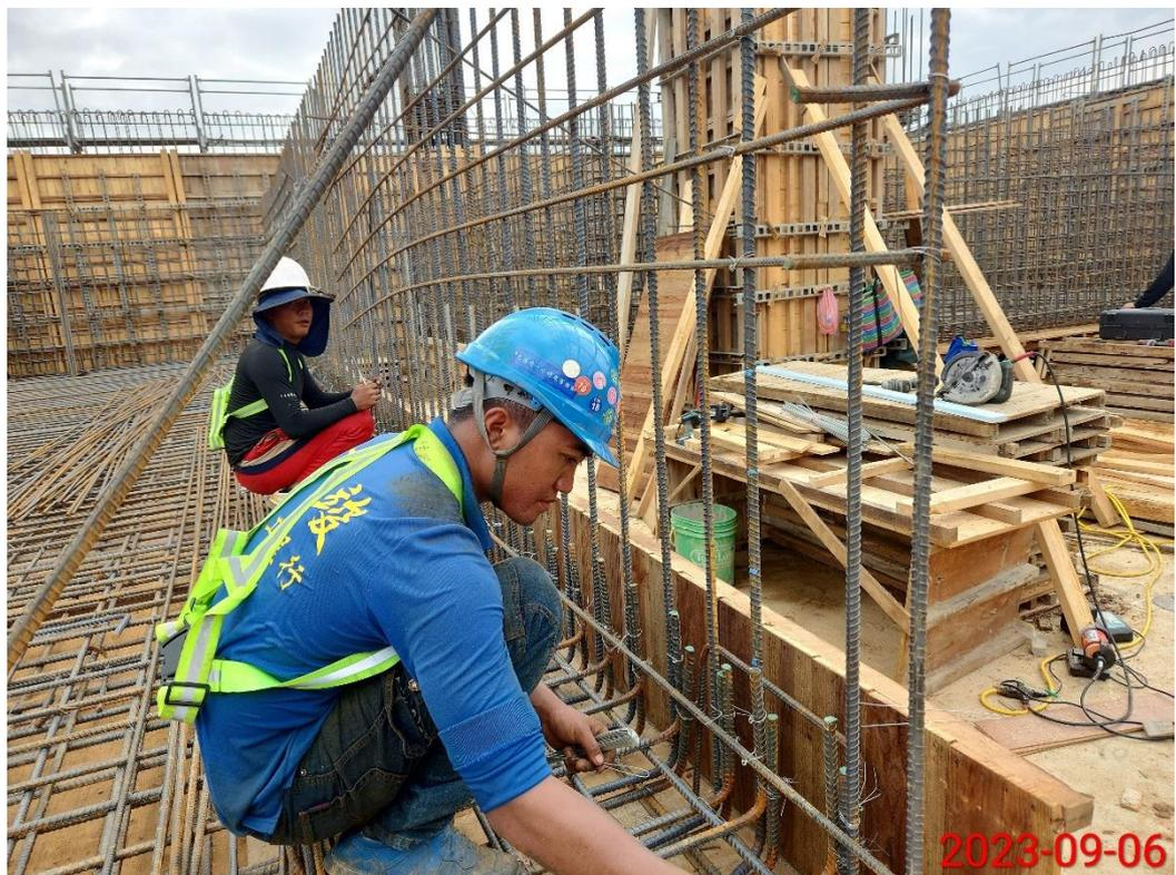
北機廠-管理中心 B1F 隔間牆、水箱鋼筋綁紮與模版組立
