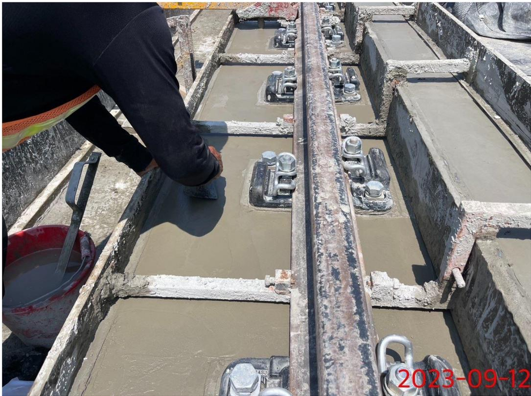
G13a~G14 道床混凝土澆置(D07~D16)
