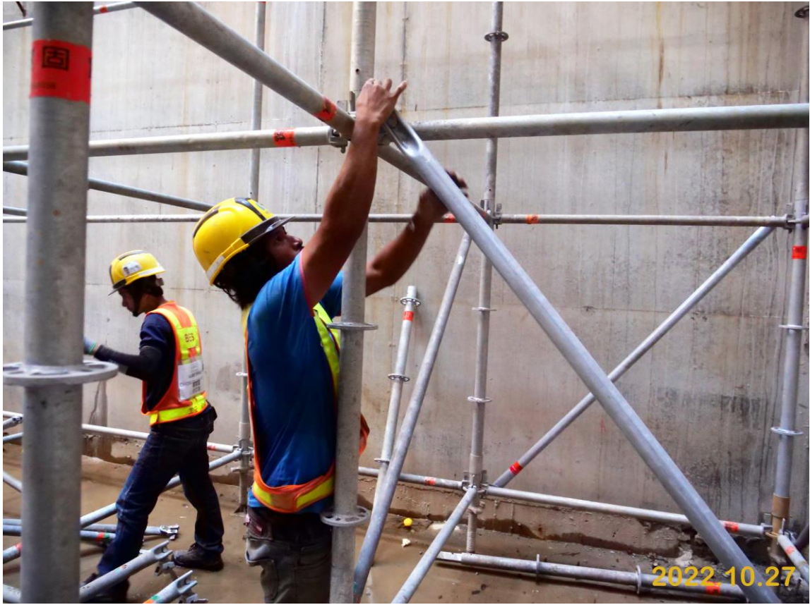
VS6 通風豎井模板支撐架施作
