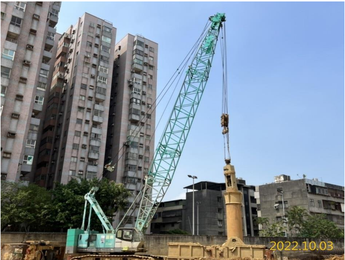
G04 站中間柱施作
