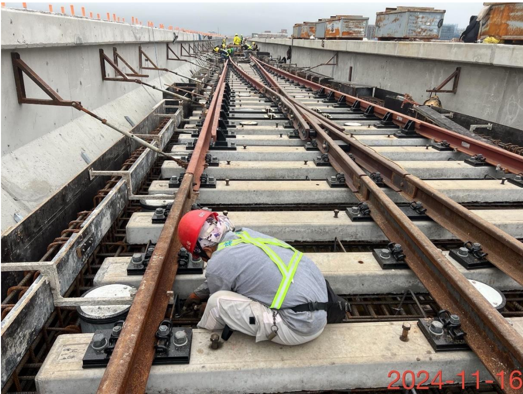
G14-G31 站間軌道施工
