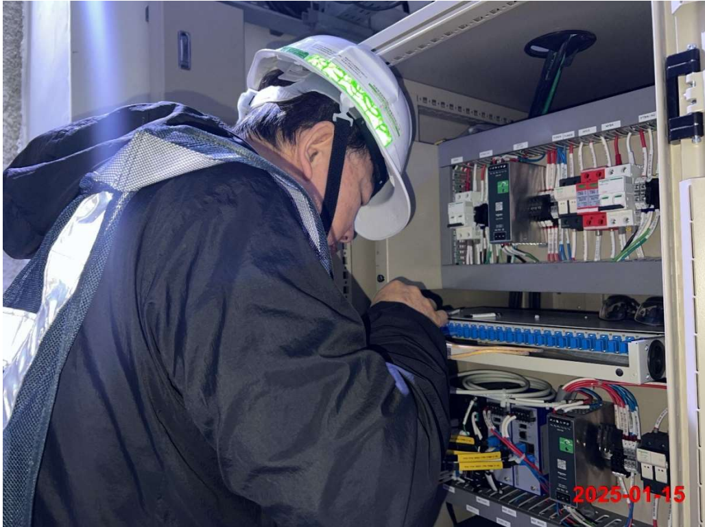
G14 站配電室線標施作
