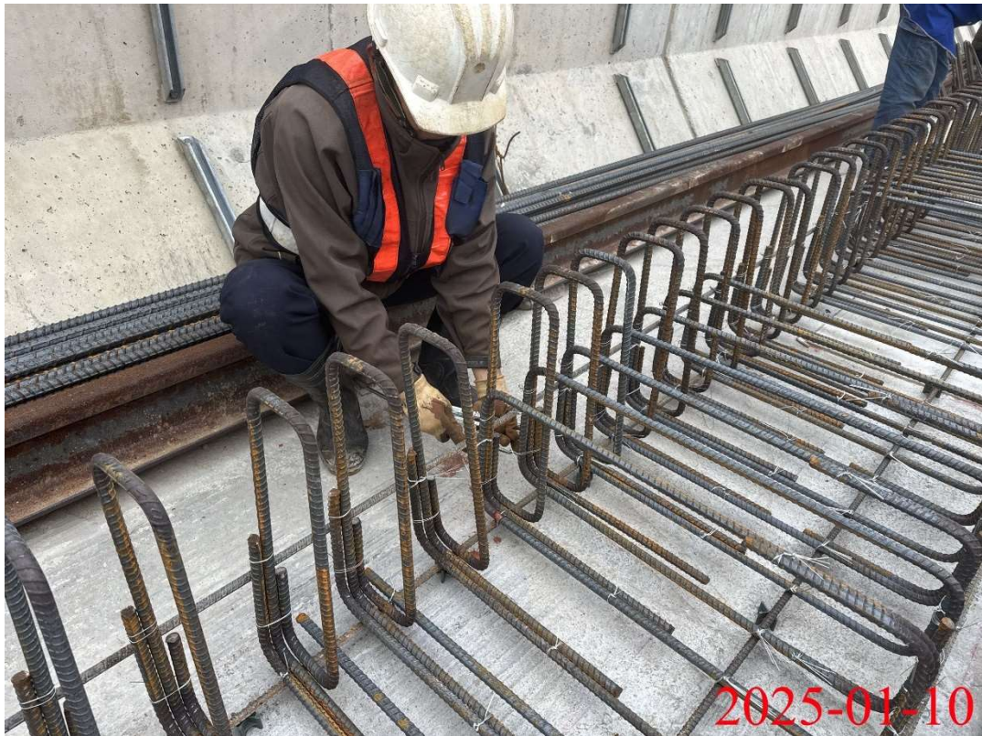
G15a-G15b 站間軌道施工
