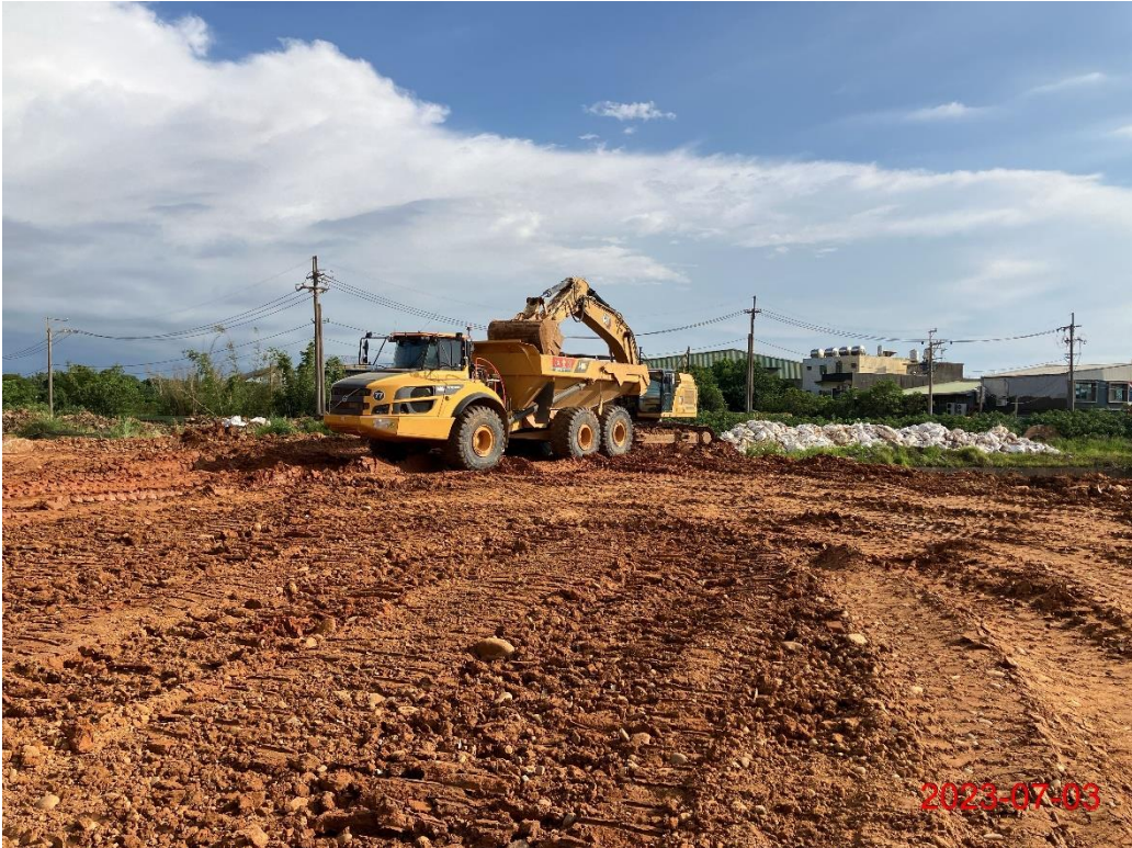
北機廠-軌道區(G 區)土方降挖
