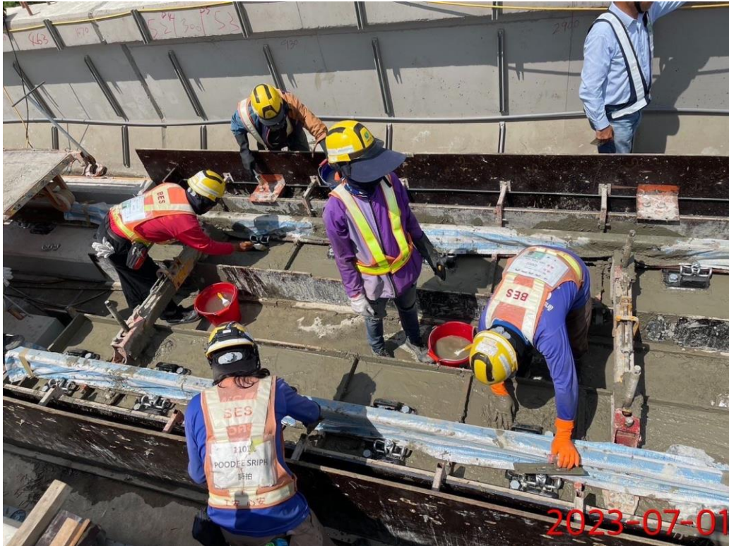
G13~G13a 下行線道床混凝土澆置 ( D53-D63)
