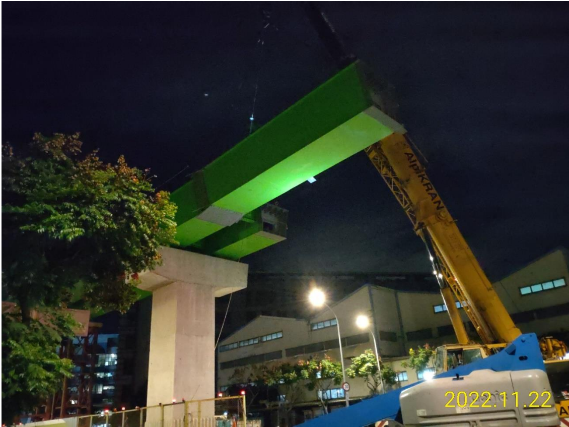
蘆竹中正北路 鋼箱型梁吊裝
