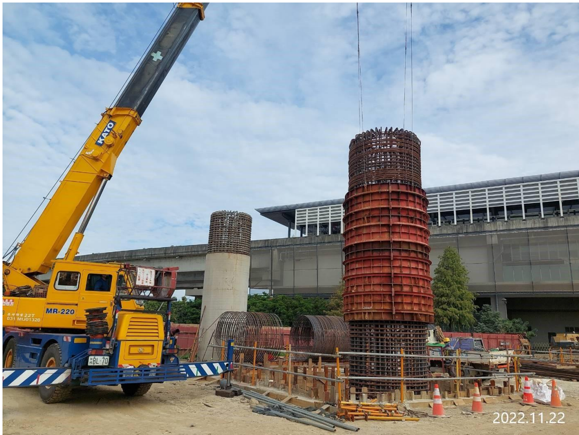
大園三民路二段 墩柱混凝土澆置
