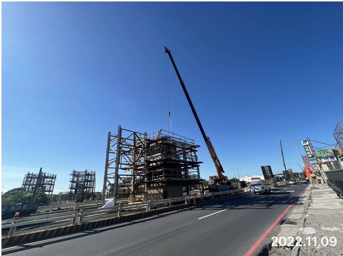
大園三民路段 帽梁施工架拆除
