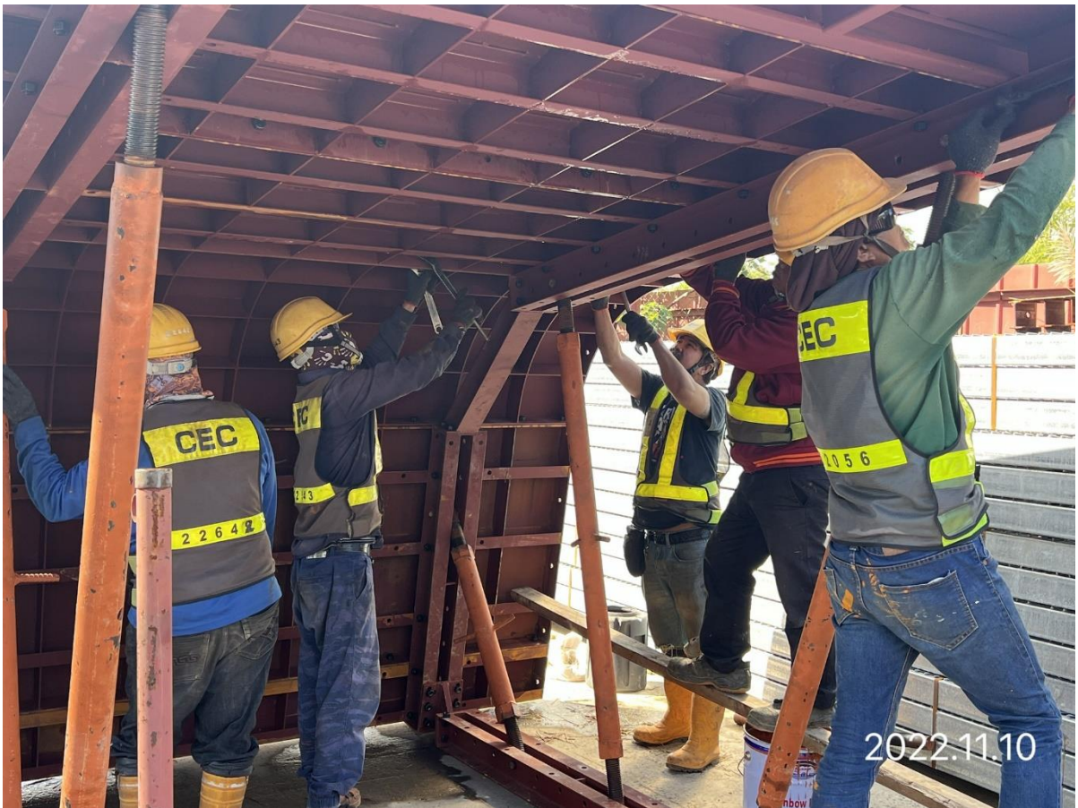
八德新關道路 場鑄箱型梁模板組立
